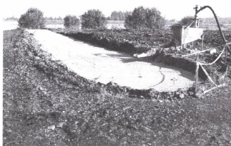
Fot. 4. Rów izolacyjny Photo 4. Isolating trench
