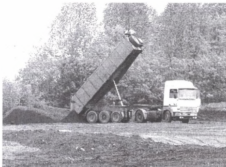
Fot. 7. Przykrycie warstwą ziemi Photo 7. Soil covering
