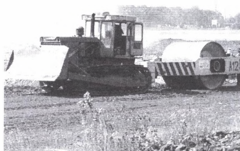
Fot. 5. Zagęszczanie materiału walcem Photo 5. Densification of waste material using roller
