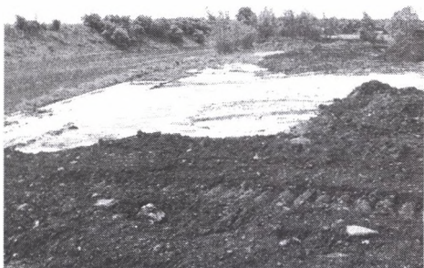
Fot. 6. Warstwa izolująca Photo 6. Isolating layer
