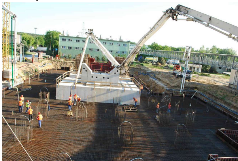
Rys. 14. Zabudowa betonu w konstrukcji fundamentu młynowni w Cementowni Góraździe 2011 r.
