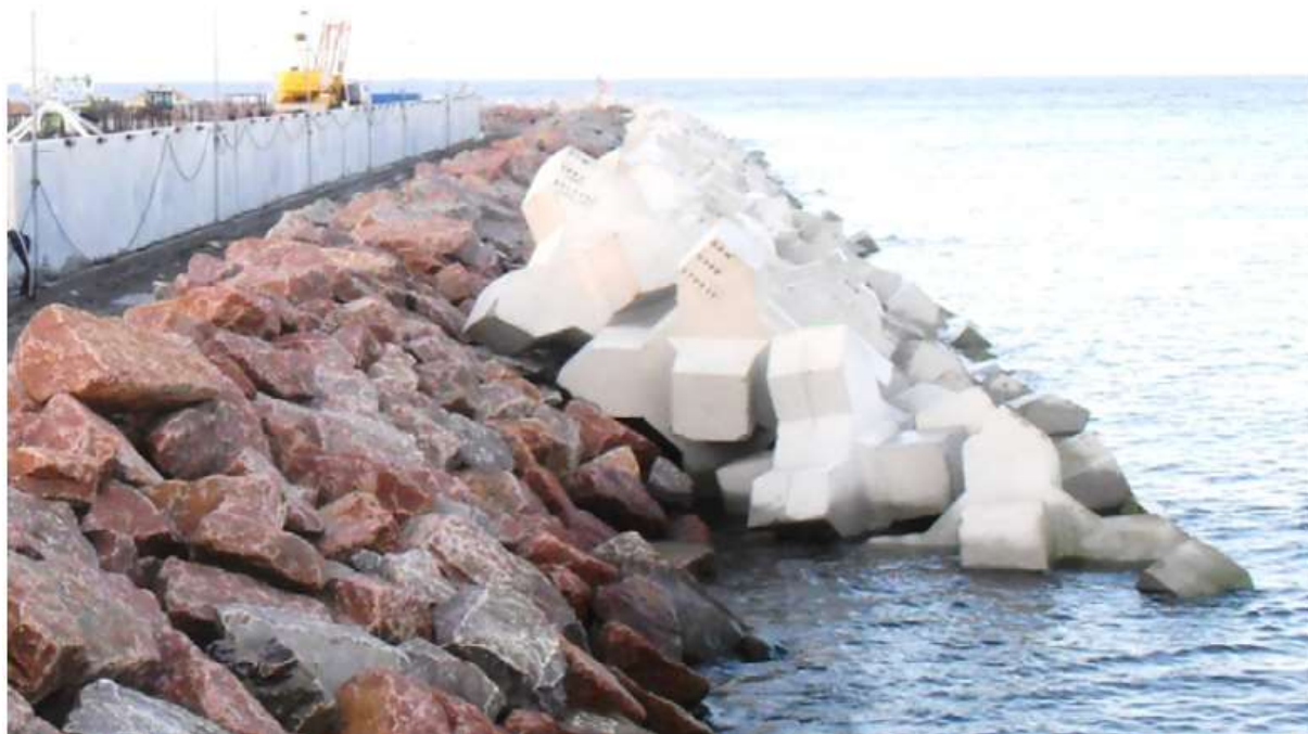
Rys. 10. Zabezpieczenie falochronu elementami prefabrykowanymi Xbloc w Świnoujściu [53]
