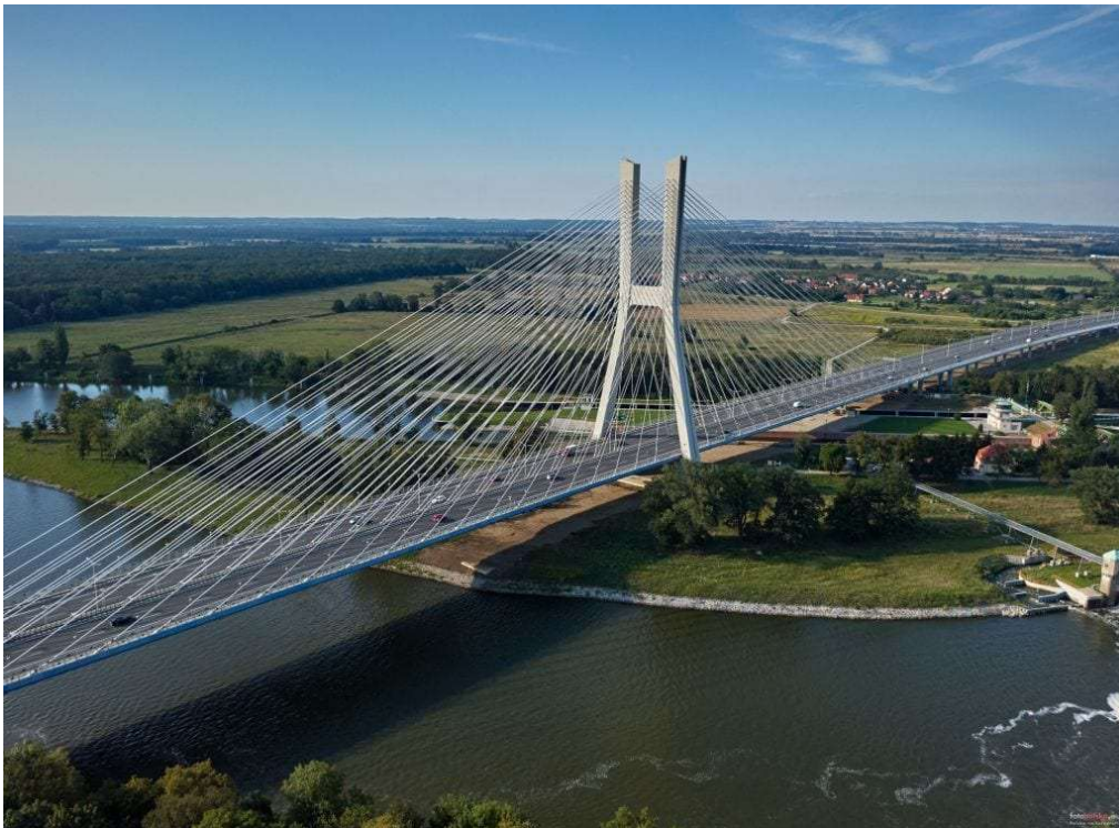
Rys. 8. Widok pylonu Mostu Rędzińskiego we Wrocławiu [20]
