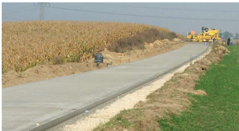
Rys. 9. Budowa drogi lokalnej Ujazd-Zimna Wódka [materiały własne]
