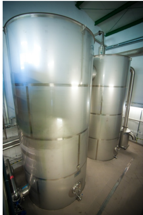
Rys. 8. Kolumny kontaktowe bloku ozonowania
