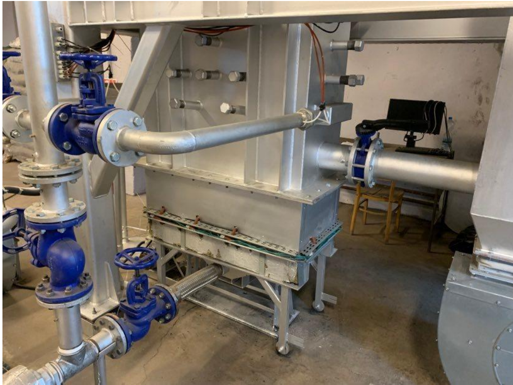
Rys. 8.16 Ruszt wibracyjny na stanowisku laboratoryjnym 0,5 MWt
