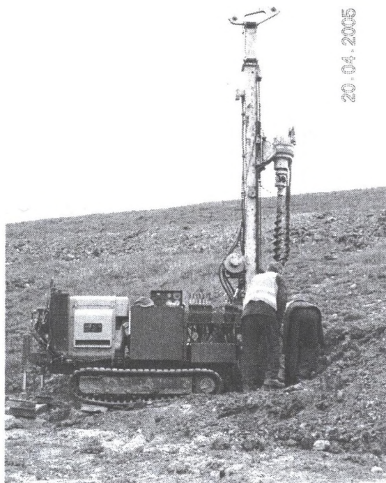
Rys. 6. Wiercenie otworów w bryle składowiska „Waleska” wiertnicą samojezdną Fig. 6. Selfpropelled drilling unit in operation on „Waleska” dump
