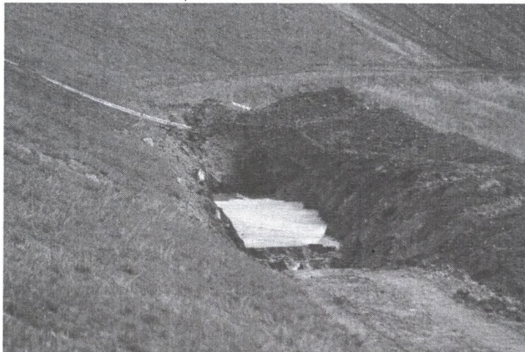
Rys. 5. Wykonywanie rowu chłonnego w skarpie składowiska „Waleska” (kwiecień 2005) Fig. 5. Receptive trench in „Waleska” dump hillside (april 2005)
