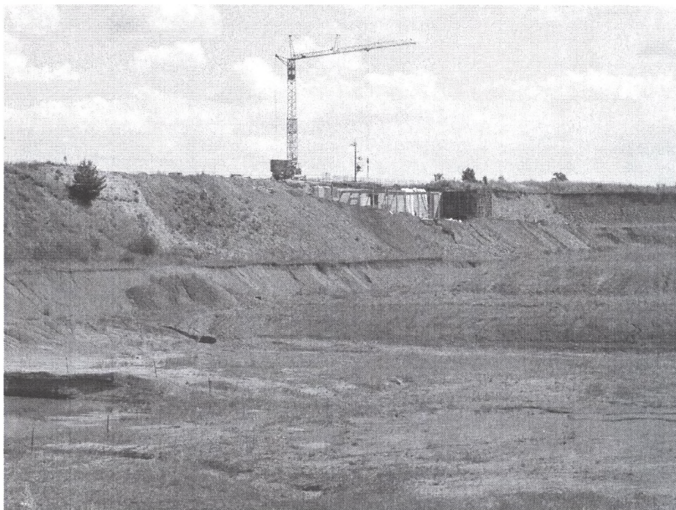
Rys. 3. Budowa pawilonu wystawienniczo – roboczego Fig. 3. The construction of the exhibition center
