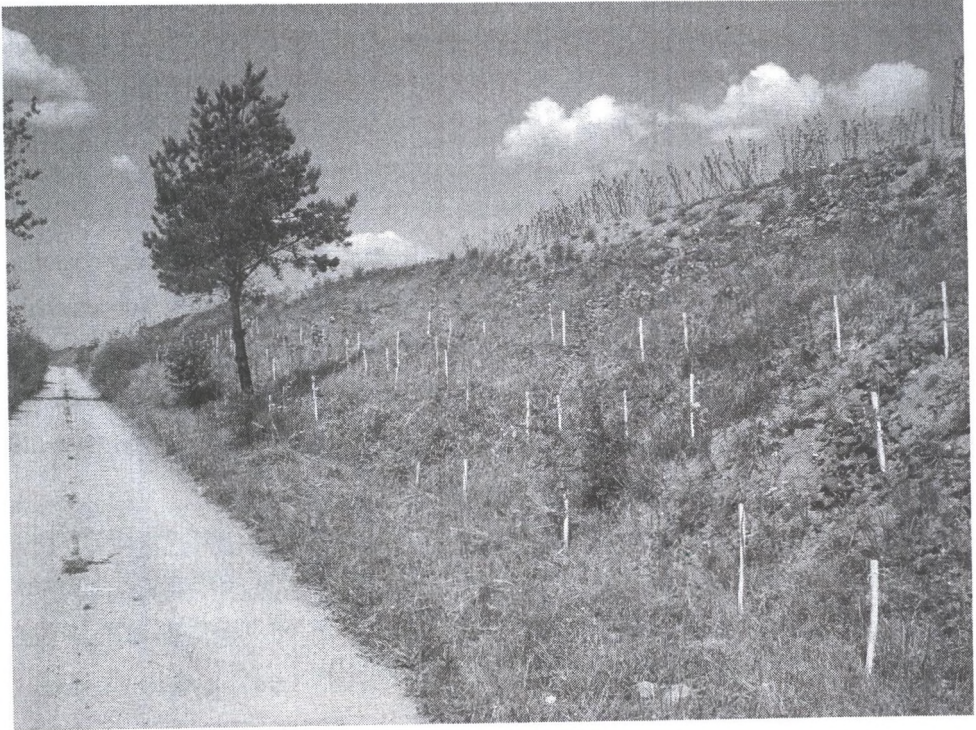
Rys. 1. Droga technologiczna przy zwałowisku północnym Fig. 1. Technological road by the northern dump
