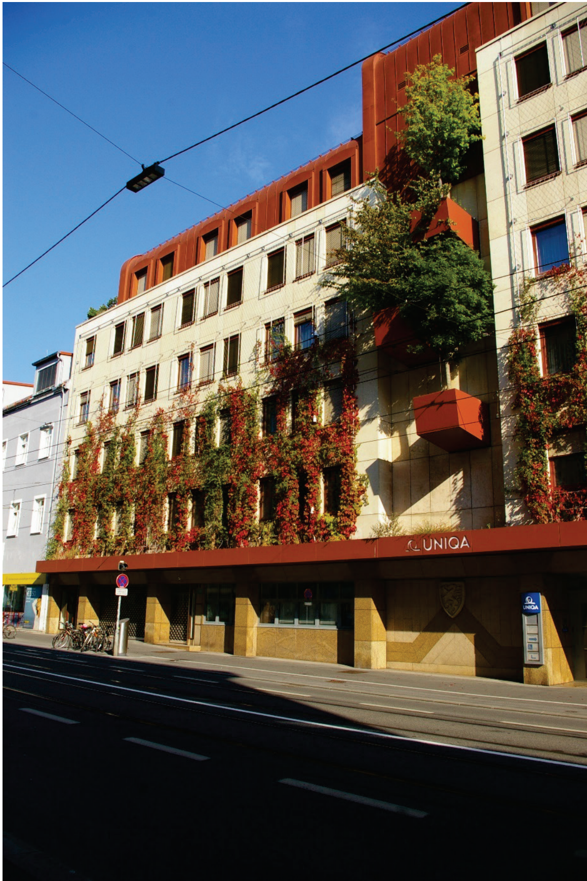
Fig. 8. UNIQA building in Graz, Austria (photo A. Kołodziejczyk-Kęsoń)
