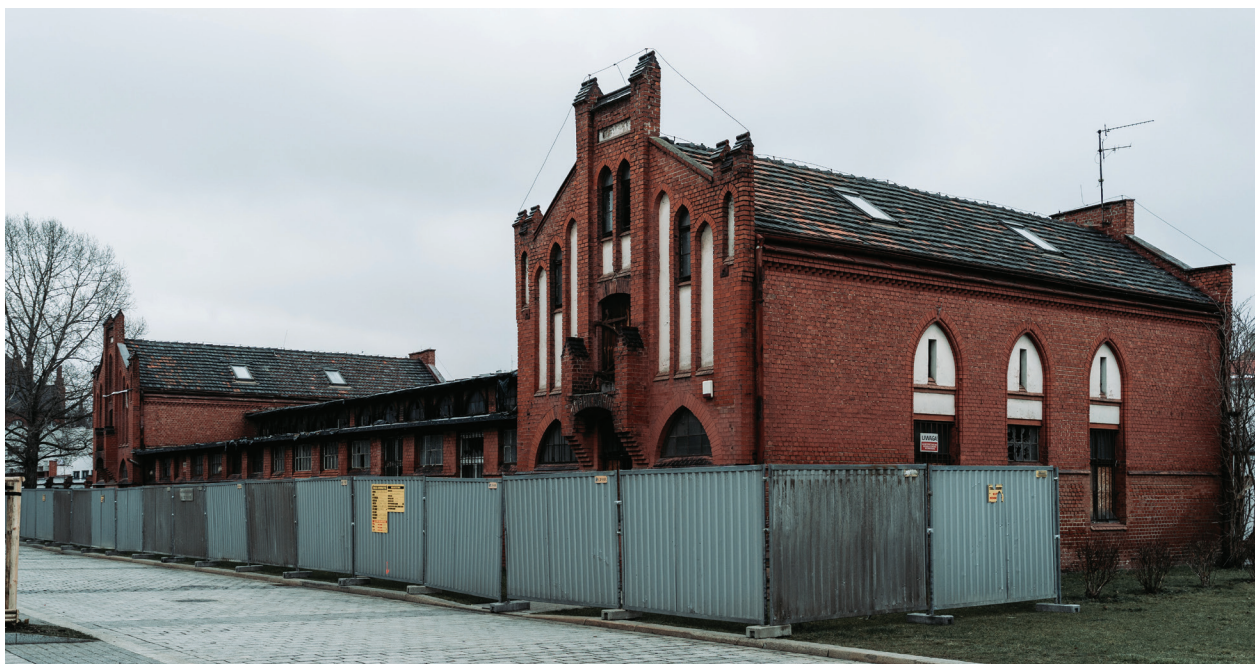
Rozpoczęcie prac przebudowy budynku dawnych stajni
