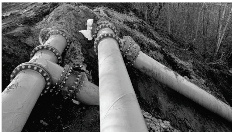
Rys. 2. Rurociągi stalowe z wykładkami kompozytowymi łączone poprzez skręcenie [opracowanie własne]
