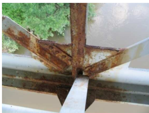
Rys. 3: Przykładowa ilustracja uszkodzenia węzła dźwigara kratownicy [8]
