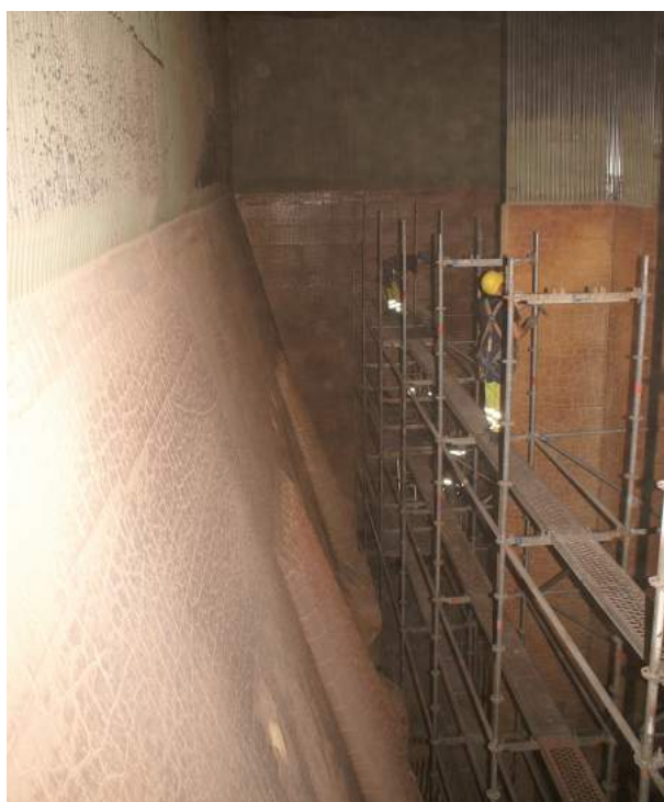
Rys. 1.10. Lej komory paleniskowej zabezpieczony obmurzem ogniotrwałym
