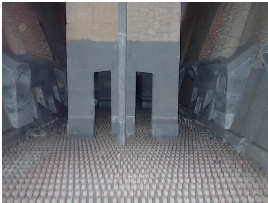
Rys. 1.2. Dno dyszowe analizowanego kotła. Widoczne od lewej: wlot paliwa, wlot materiału recyrkulowanego z zewnętrznego przegrzewacza pary (3 sztuki). Na wprost powierzchnia krzyżowa będąca częścią parownika. Widoczne od prawej: wlot paliwa, wlot materiału recyrkulowanego z zewnętrznego przegrzewacza pary (3 sztuki), wlot palnika rozpalającego. Na ruszcie widoczne zabudowane dysze powietrza pierwotnego
