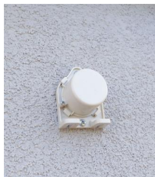
Rys. 2. Regulator pokojowy ST-2801 Wi-Fi z osprzętem: a) regulator i bezprzewodowy czujnik temperatury C-mini, b) czujnik temperatury zewnętrznej Termet WKC0567 współpracujący z kotłem. (źródło: www.techsterowniki.pl )
