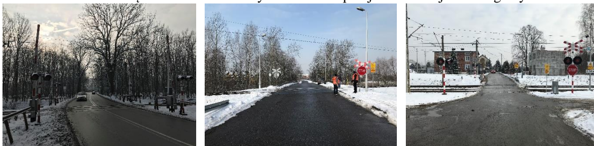
Fot. 2. Badane przejazdy kolejowo-drogowe
