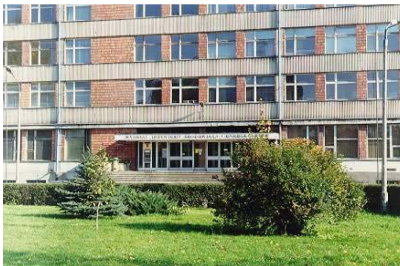
Główne wejście do budynku Wydziału Inżynierii Środowiska i Energetyki
