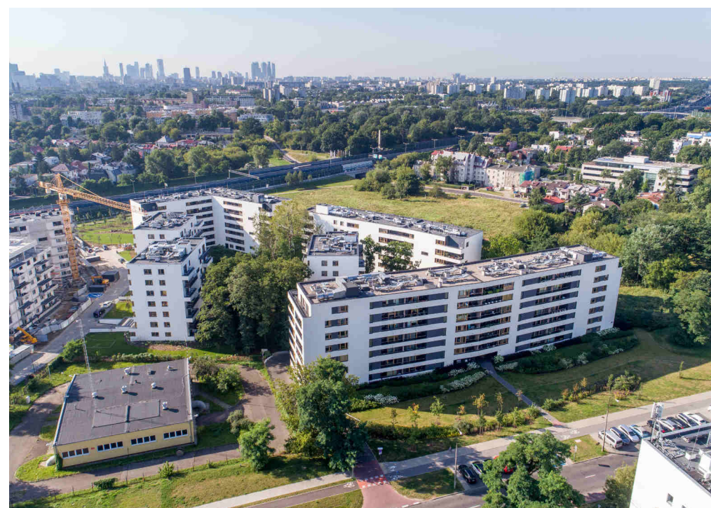
Il.31. Osiedle Mickiewicza w Warszawie, projekt HRA Architekci/The Mickiewicz estate in Warsaw, project HRA Architekci, autor zdjęć/author of the photos: Piotr Krajewski
