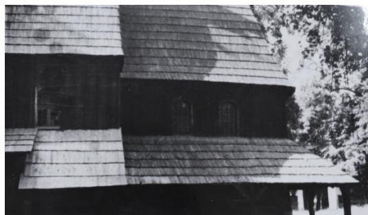
Widok fragmentu elewacji południowej. Źródło: WUOZ w Katowicach, delegatura w Bielsku-Białej
