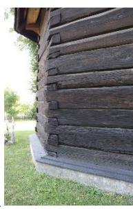
Widok fragmentu połączeń ścian w węglach: a. bez остатków, wschodnia ściana zamykająca prezbiterium, b. z ostatkami, zamknięcie prezbiterium od strony północno-wschodniej, c. fragment zrębu ścian kruchty bocznej. Fotografie własne, 2021 r.
