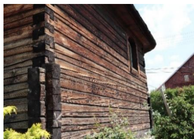
Widok fragmentu zrębu ścian. Fotografia własna, 2019 r.
