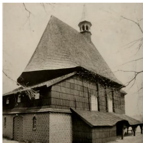
Widok kościoła pw. św. Barbary w Kolanowicach [239]
