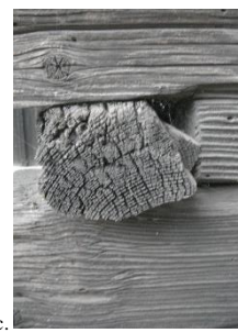
Widok fragmentu połączeń ścian w węglach: a. bez остатków, wschodnia ściana zamykająca prezbiterium, b. z ostatkami, zamknięcie prezbiterium od strony północno-wschodniej, c. fragment zrębu ścian kruchty bocznej. Fotografie własne, 2021 r.
