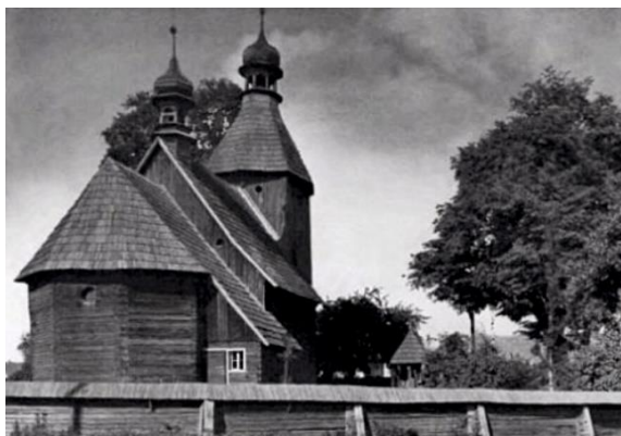
Widok kościoła od północnego wschodu, stan przed relokacją do Szczepanka [336]
