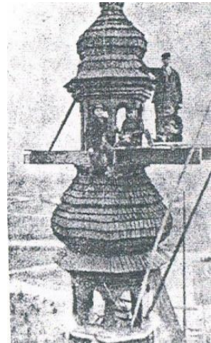
Widok budowy wieży na sygnaturkę [338]
