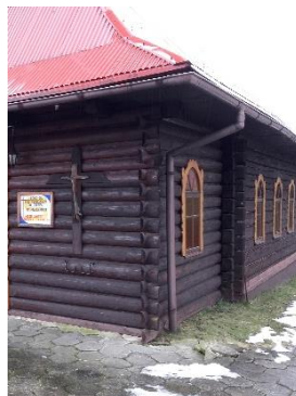
Widok fragmentu elewacji południowo-wschodniej. Fotografia własna, 2018 r.
