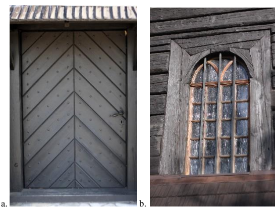
Widok stolarki okiennie-drzwiowej: a. widok głównych drzwi wejściowych, b. okno doświetlające świątynię. Fotografie własne, 2020 r.
