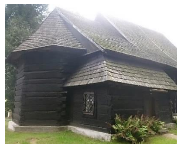
Fragment elewacji północno-wschodniej. Fotografia własna, 2014 r.
