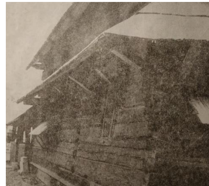
Fragment elewacji południowej z widokiem przydaszków osłaniających zrębową konstrukcję ścian [243]
