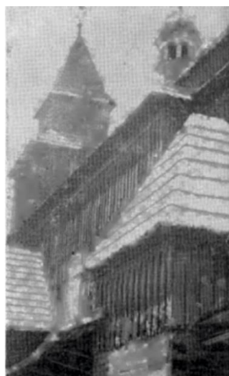
Widok fragmentu południowej elewacji [348]
