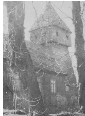
Widok kościoła pw. św. Barbary w Jedlniku, przed relokacją do Jastrzębia-Zdroju [208]
