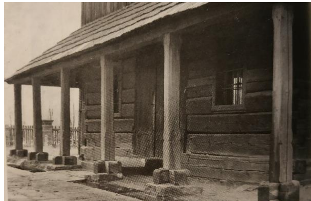
Widok fragmentu sobót ujętych w zachodniej elewacji kościoła [239]
