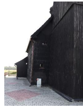
Fragment elewacji północnej. Fotografia własna, 2017 r.
