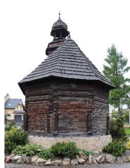
Widok kaplicy od wschodu. Fotografia własna, 2019 r.
