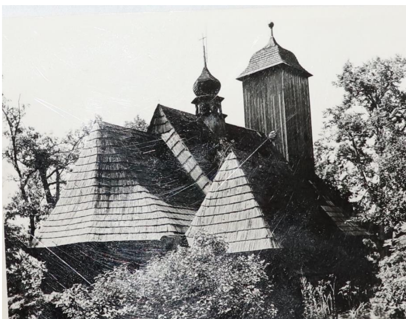
Widok kościoła od północnego wschodu. Źródło: WUOZ w Opolu, fotografia sprzed 1939 r.
