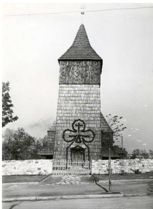
Widok kościoła po relokacji. Źródło: WUOZ w Katowicach, fotografia z lat 1936–1939 r.
