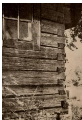
Widok fragmentu połączeń ścian w węglach [237]
