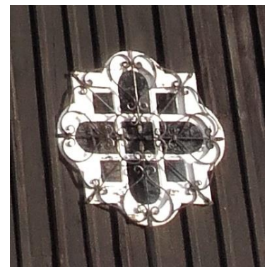
Okno w zachodniej elewacji kościoła. Fotografia własna, 2018 r.
