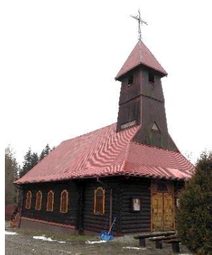
Widok od południowego zachodu. Fotografia własna, 2018 r.
