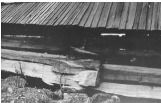
Widok fragmentu ogrodzenia o połączeniach bierwion na zakład [59]
