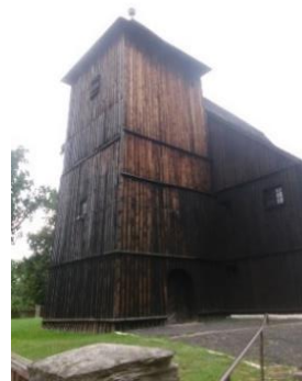
Wieża kościelna. Fotografia własna, 2014 r.
