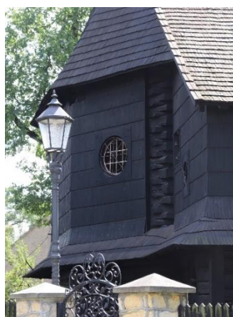
Widok fragmentu północnej ściany prezbiterium. Fotografia własna, 2019 r.
