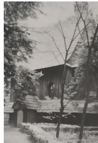
Widok fragmentu elewacji od południowego zachodu [208]
