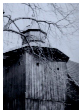
Widok wieży kościelnej. Źródło: WUOZ w Opolu, fotografia sprzed 1939 r.
