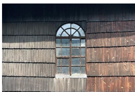
Widok fragmentu południowej ściany prezbiterium. Fotografia własna, 2021 r.
