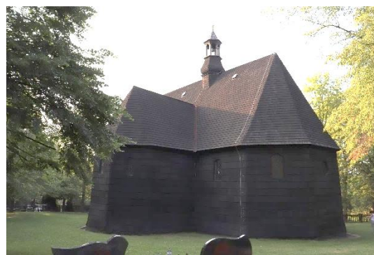
Elewacja południowo wschodnia. Fotografia własna, 2019 r.
