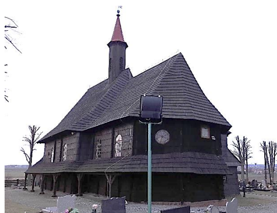
Elewacja południowo-wschodnia. Fotografia własna, 2018 r.
