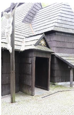
Wejście do zakrystii. Fotografia własna, 2019 r.
