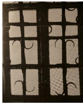
Widok okna doświetlającego zakrystię przy ewangelickim kościele w Kostowie [237]
