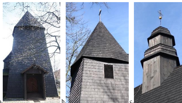
Widoki wieży: a. wieża poprzedzająca nawę, b. hełm zwieńczający wieżę, c. sygnaturna. Fotografie własne, 2020 r.
