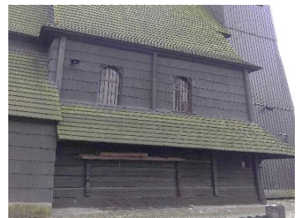
Fragment elewacji północnej. Fotografia własna, 2018 r.
