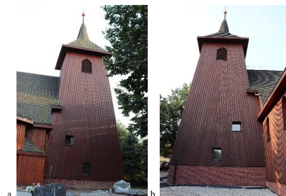
Widok wieży kościelnej: a. widok od północy, b. widok od południa. Fotografie własne, 2017 r.
