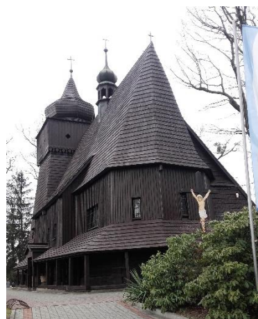
Widok elewacji południowo-wschodniej. Fotografia własna, 2018 r.
