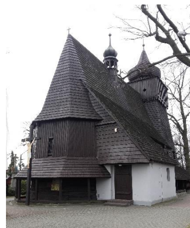
Widok elewacji północno-wschodniej. Fotografia własna, 2018 r.
