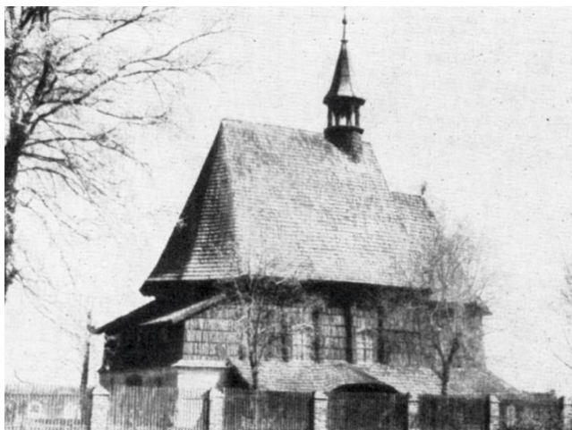
Widok kościoła pw. św. Barbary w Kolanowicach [56]
