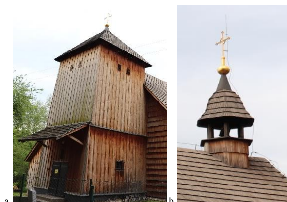
Wieże kościoła w Szalszy: a. wieża z 1571 r., b. sygnaturka nadbudowana w kalenicę dachu nad nawą. Fotografie własne, 2019 r.
