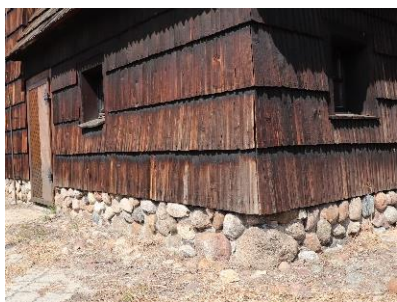
Widok fragmentu kamiennej podmurówki. Fotografia własna, 2019 r.
