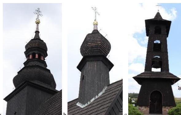
Widok hełmów wież i wolnostojącej dzwonnicy: a. hełm wieży, b. hełm wieży na sygnaturę, c. dzwonnica. Fotografie własne, 2019 r.
