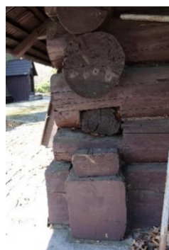
Widok zrębu ścian: a. połączenia ścian w węglach w południowym narożniku prezbiterium, b. połączenia ścian w węglach w północno-zachodnim narożniku nawy. Fotografie własne, 2019 r.
