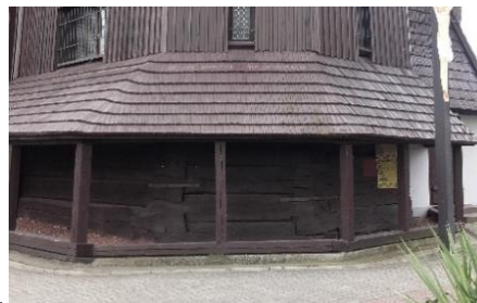
Widok sobót i przydaszków: a. elewacja południowa, b. elewacja wschodnia, c. elewacja północna. Fotografie własne, 2018 r.
