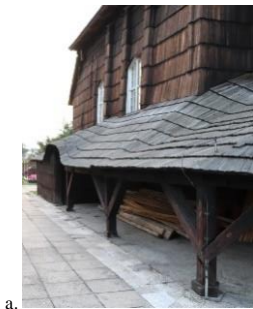
Widok kościoła w Kolanowicach: a. widok sobót przylegających do południowej ściany nawy, b. widok fragmentu południowej ściany nawy z lisicami, c. widok północnej ściany zakrystii, d. widok zadaszenia galerii nad kruchtą oraz wysuniętego zadaszenia nad nawą, e. widok dwukalenicowego dachu z sygnaturką wbudowaną w kalenicę dachu nad nawą. Fotografie własne, 2019 r.
