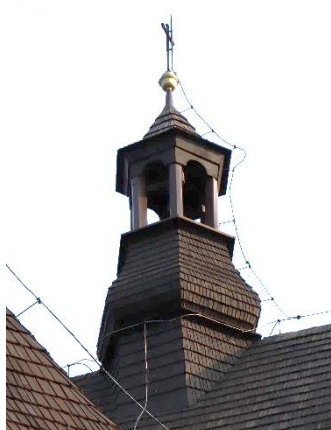
Widok wieży na sygnaturkę. Fotografia własna, 2019 r.
