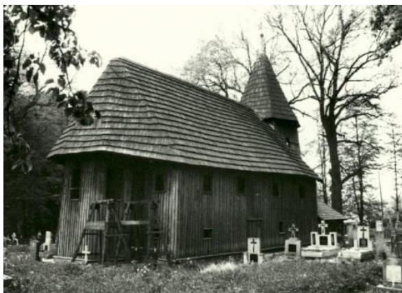
Widok kościoła od północnego wschodu. Źródło: WUOZ w Opolu, fotografia z 1982 r.
