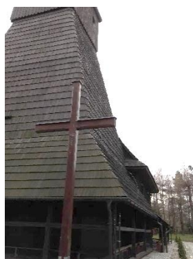
Widok fragmentu wieży kościelnej. Fotografia własna, 2018 r.
