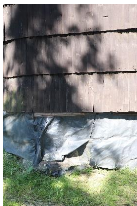
Widok fragmentu ścian. Fotografia własna, 2018 r.
