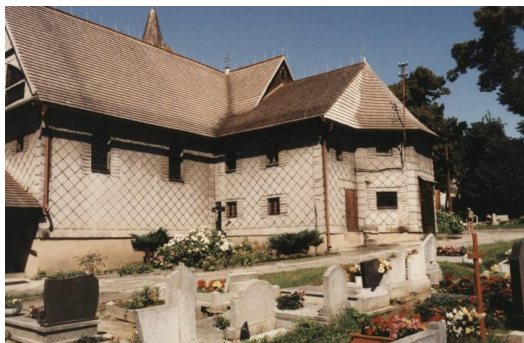
Widok kościoła od południowego wschodu, stan przed remontem elewacji [KE_084]
