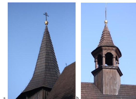
Helmy wież: a. hełm wieży poprzedzającej nawę, b. sygnaturka. Fotografie własne, 2020 r.
