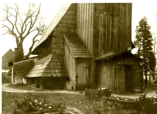
Widok fragmentu kościoła od północnego zachodu, fotografia z 1936 r. Źródło: http://www.fototekaslaska.pl/zdjecie.php?zd=1373&dz=116 , dostęp: 04.09.2018 r.
