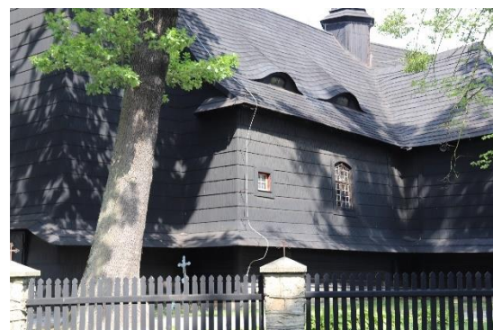
Widok fragmentu południowo zachodniej ściany nawy. Fotografia własna, 2019 r.
