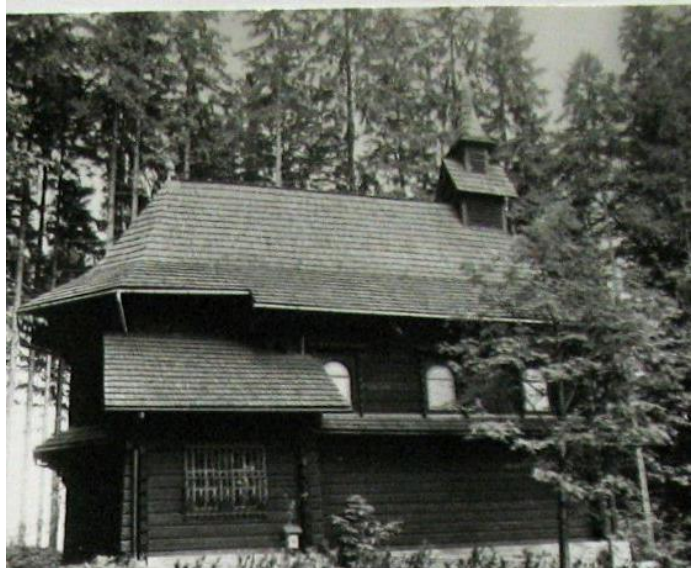
Widok kaplicy od wschodu [KE_106]
