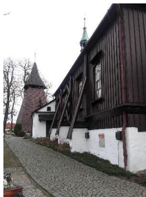
Fragment elewacji północnej. Fotografia własna, 2018 r.
