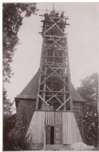
Widok wieży podczas remontu na przełomie 1985/1986 r. Źródło: WUOZ w Katowicach
