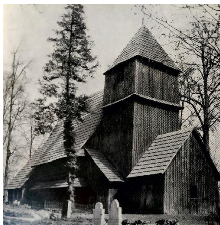
Widok kościoła od północnego zachodu [115]
