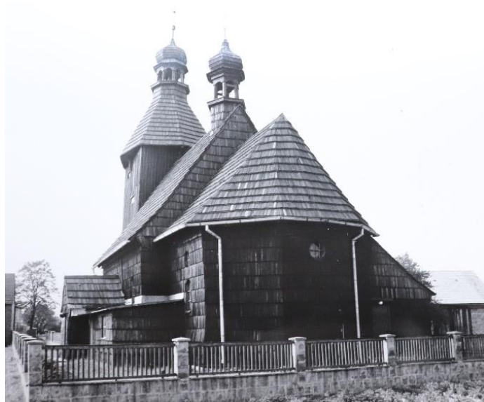
Widok kościoła od południowego wschodu. Widok po relokacji. Źródło: WUOZ w Opolu, fotografia sprzed 1939 r.
