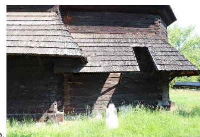
Widok przydaszek: a. przydaszki przylegające do północnej części nawy, b. przydaszki przylegające do południowej części prezbiterium i fragmentu nawy. Fotografie własne, 2019 r.
