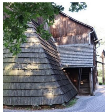
Fragment elewacji południowej z widokiem fartucha osłaniającego słupową konstrukcję wieży. Fotografia własna, 2019 r.
