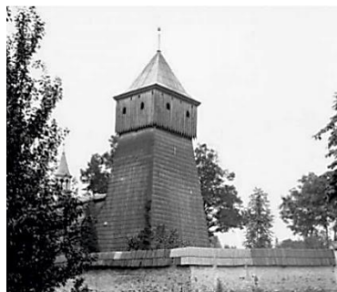
Widok wieży kościelnej od północnego zachodu [239]
