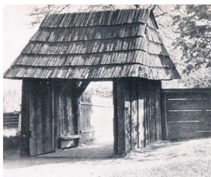
Widok bramy w ogrodzeniu cmentarnym [239]
