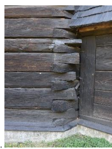
Widok fragmentu połączeń ścian w węglach: a. bez остатków, wschodnia ściana zamykająca prezbiterium, b. z ostatkami, zamknięcie prezbiterium od strony północno-wschodniej, c. fragment zrębu ścian kruchty bocznej. Fotografie własne, 2021 r.
