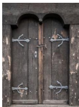
Drzwi do kaplicy z oryginalnie zachowanym portalem. Fotografia własna, 2019 r.
