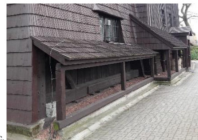
Widok sobót i przydaszków: a. elewacja południowa, b. elewacja wschodnia, c. elewacja północna. Fotografie własne, 2018 r.
