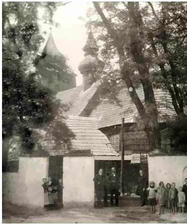
Widok kościoła w Przyszowicach [110]
