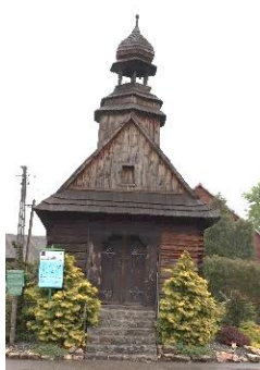
Widok kaplicy od zachodu. Fotografia własna, 2019 r.
