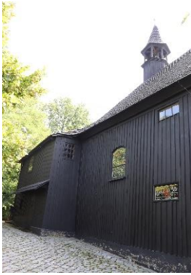
Fragment elewacji północnej. Fotografia własna, 2019 r.
