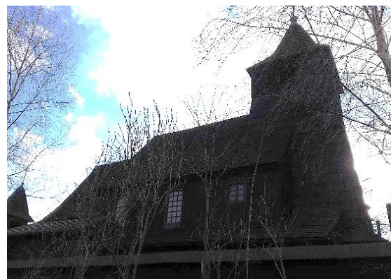
Elewacja północna. Fotografia własna, 2018 r.
