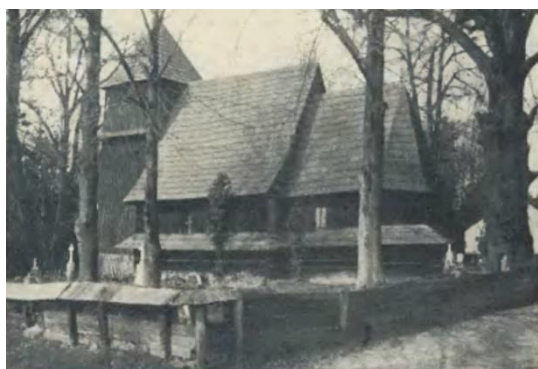
Widok kościoła od południowego wschodu [373]
