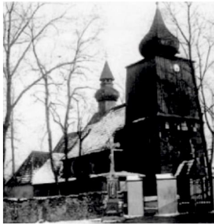
Widok kościoła w Przyszowicach [283]
