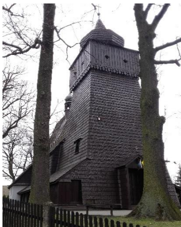
Widok elewacji zachodnio-północnej. Fotografia własna, 2018 r.
