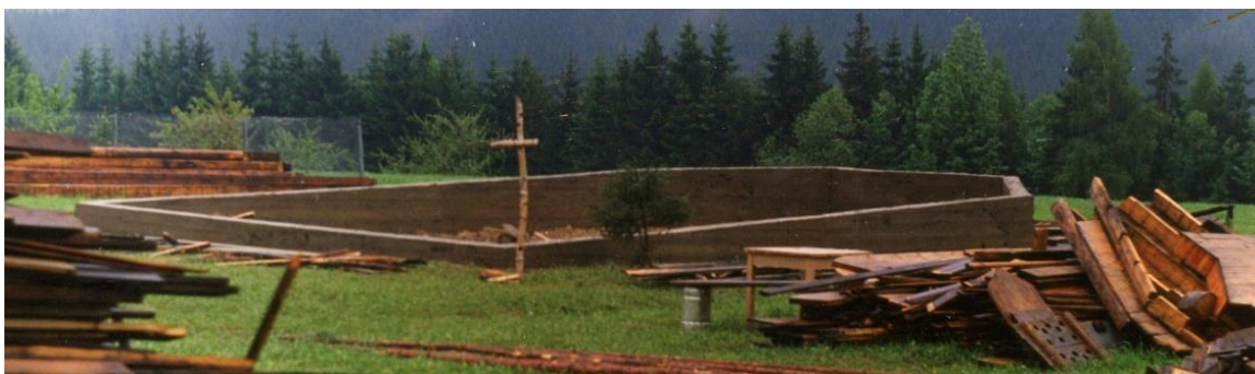
Fotografia z budowy kościoła. Źródło: zdjęcia z kroniki parafialnej prowadzonej przez Teresę Kukuczkę, mieszkankę Istebnej
