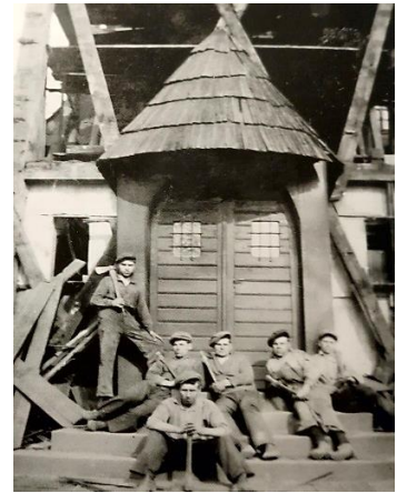
Widok prac demontażowych kościoła w Przyszowicach [110]
