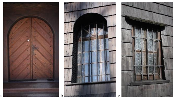
Widoki stolarki okiennie-drzwiowej: a. drzwi zewnętrzne w północnej kruchcie, b. okno zamknięte lukowo doświetlające nawę, c. okno doświetlające przyziemie wieży. Fotografie własne 2020 r.
