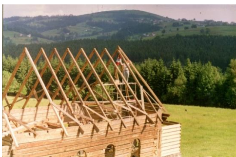
Fotografia z budowy kościoła. Źródło: zdjęcia z kroniki parafialnej prowadzonej przez Teresę Kukuczkę, mieszkankę Istebnej
