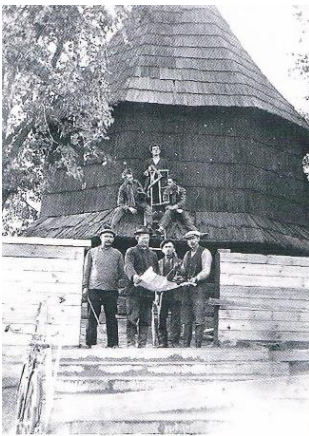
Widok kościoła w Przyszowicach [110]
