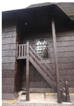
Widok zewnętrznych schodów prowadzących na lożę kolatorską. Fotografia własna, 2020 r.
