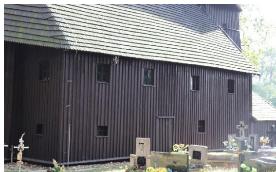
Fragment elewacji północnej. Fotografia własna, 2019 r.
