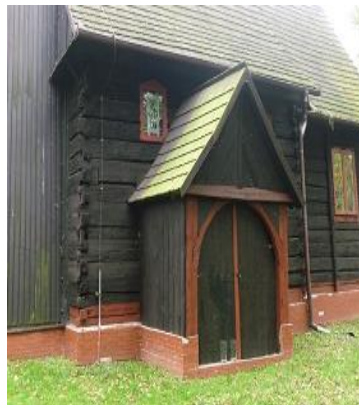
Widok południowej kruchty mieszczącej wejście do wnętrza kościoła. Fotografia własna, 2014 r.
