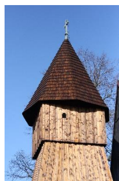
Helm wieży kościelnej. Fotografia własna, 2020 r.
