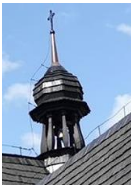
Widok wieży na sygnaturkę Fotografia własna, 2018 r.
