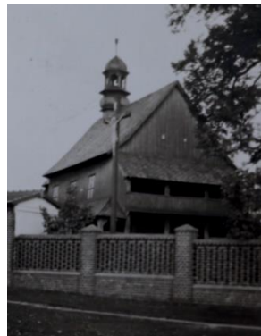
Widok kościoła od północnego wschodu [KE_024].
