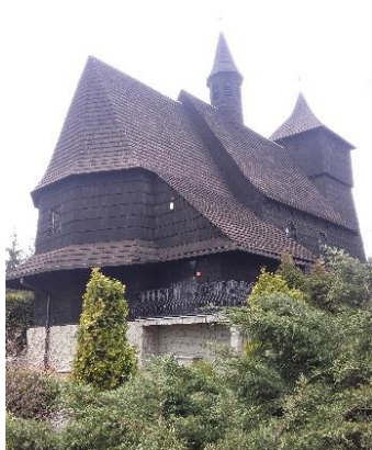
Fragment elewacji południowo-wschodniej. Fotografia własna, 2018 r.
