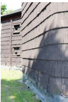
Widok fragmentu ścian. Fotografia własna, 2018 r.
