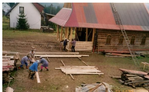
Fotografia z budowy kościoła. Źródło: zdjęcia z kroniki parafialnej prowadzonej przez Teresę Kukuczkę, mieszkankę Istebnej
