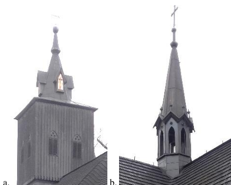
Widok hełmów wież: a. hełm wieży kościelnej, b. hełm wieży na sygnaturkę. Fotografie własne 2019 r.
