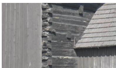
Widok zrębu ścian. Fotografia własna, 2014 r.
