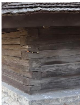
Widok połączeń belek na jaskółczy ogon – narożnik północno-wschodni zamknięcia prezbiterium. Fotografia własna, 2019 r.
