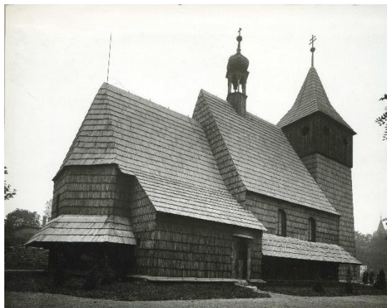
Widok kościoła po relokacji od północnego wschodu. Źródło: WUOZ w Katowicach, fotografia z lat 1936–1939 r.
