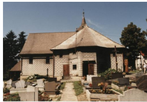
Widok kościoła od wschodu, stan przed remontem elewacji [KE_084]
