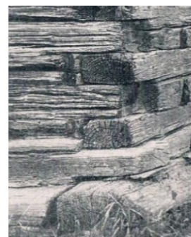
Połączenie ścian w węglach [237]
