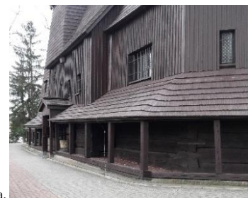
Widok sobót i przydaszków: a. elewacja południowa, b. elewacja wschodnia, c. elewacja północna. Fotografie własne, 2018 r.
