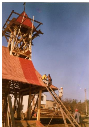
Fotografia z budowy kościoła. Źródło: zdjęcia z kroniki parafialnej prowadzonej przez Teresę Kukuczkę, mieszkankę Istebnej
