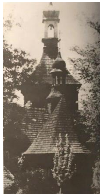
Widok kościoła od wschodu, przed relokacją z Boguszowic [208]
