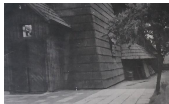
Widok fragmentu elewacji południowo-zachodniej [208]
