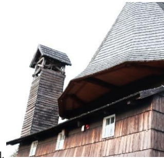
Widok kościoła w Kolanowicach: a. widok sobót przylegających do południowej ściany nawy, b. widok fragmentu południowej ściany nawy z lisicami, c. widok północnej ściany zakrystii, d. widok zadaszenia galerii nad kruchtą oraz wysuniętego zadaszenia nad nawą, e. widok dwukalenicowego dachu z sygnaturką wbudowaną w kalenicę dachu nad nawą. Fotografie własne, 2019 r.
