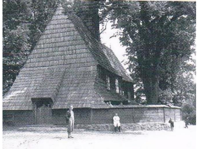
Widok kościoła w Przyszowicach [110]
