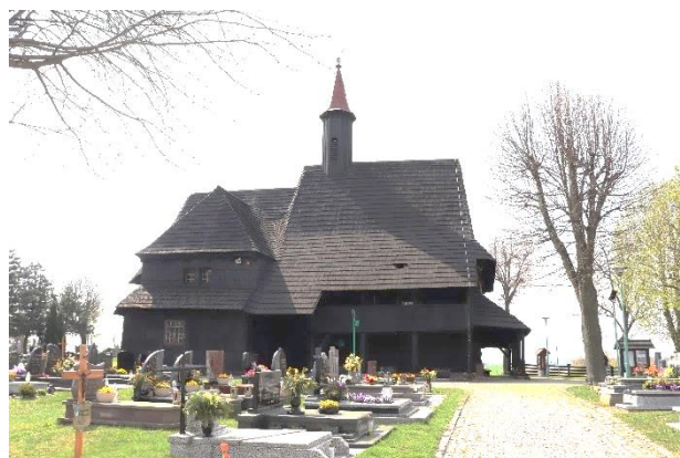
Elewacja północna. Fotografia własna, 2022 r.
