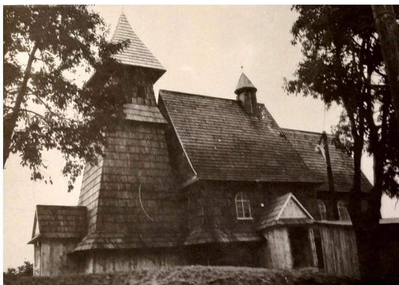
Widok zachodniej elewacji, budowa kościoła w Palowicach [208]
