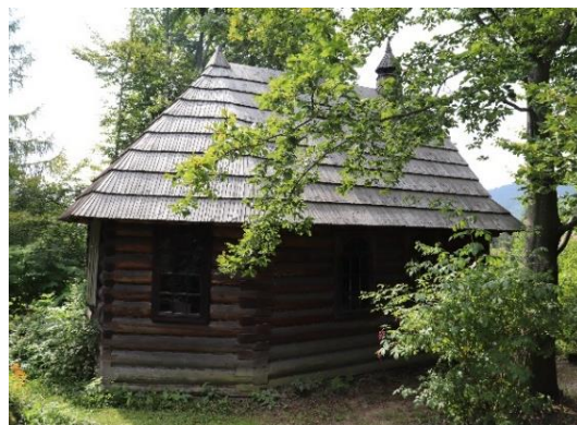
Widok kaplicy od północnego wschodu. Fotografia własna, 2019 r.
