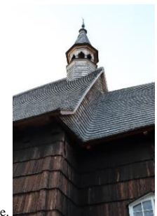
Widok kościoła w Kolanowicach: a. widok sobót przylegających do południowej ściany nawy, b. widok fragmentu południowej ściany nawy z lisicami, c. widok północnej ściany zakrystii, d. widok zadaszenia galerii nad kruchtą oraz wysuniętego zadaszenia nad nawą, e. widok dwukalenicowego dachu z sygnaturką wbudowaną w kalenicę dachu nad nawą. Fotografie własne, 2019 r.
