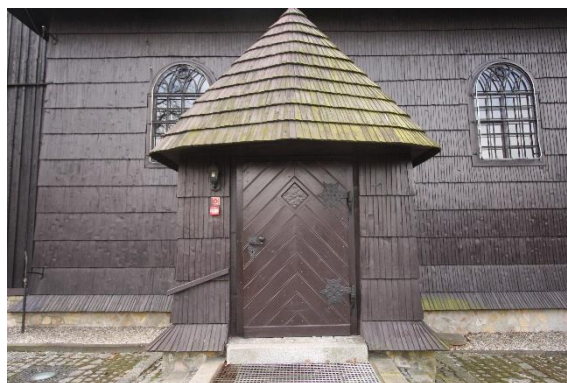
Widok kruchty ujętej w północno-wschodniej elewacji kościoła. Fotografia własna, 2020 r.
