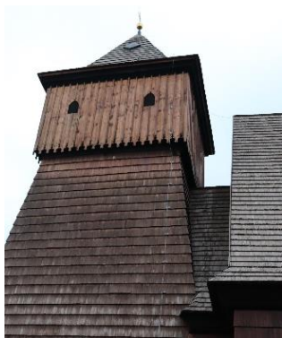
Widok połączenia wieży ze ścianą szczytową nawy. Fotografia własna, 2019 r.
