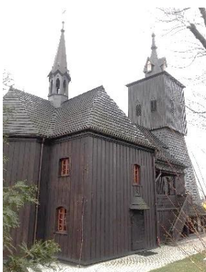
Fragment elewacji północnej. Fotografia własna, 2019 r.
