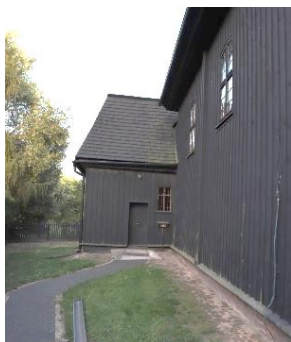
Fragment elewacji północnej. Fotografia własna, 2019 r.
