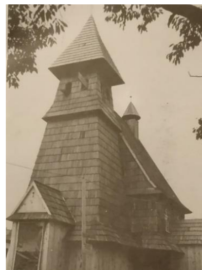
Widok zachodniej elewacji, budowa kościoła w Palowicach [208]
