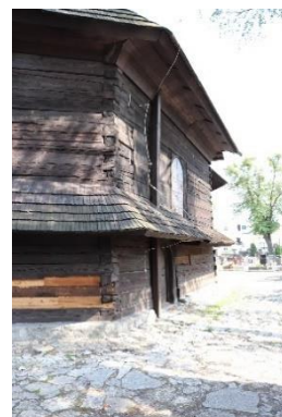
Fragment elewacji północnej. Fotografia własna, 2017 r.
