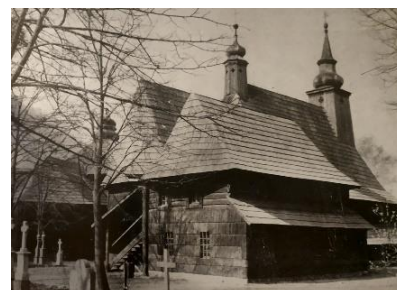
Widok fragmentu północno-wschodniej elewacji [239]
