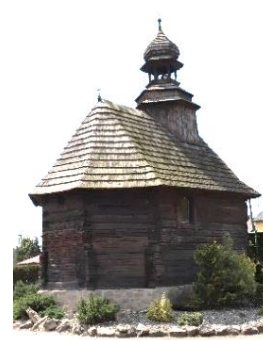
Widok kaplicy od północnego wschodu. Fotografia własna, 2019 r.
