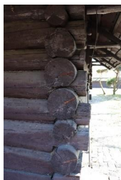
Widok zrębu ścian: a. połączenia ścian w węglach w południowym narożniku prezbiterium, b. połączenia ścian w węglach w północno-zachodnim narożniku nawy. Fotografie własne, 2019 r.
