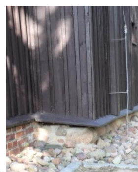
Widok fragmentu podmurówki: a. podmurówka w południowo-zachodnim narożniku wieży, b. podmurówka przy południowej ścianie nawy. Fotografie własne, 2019 r.
