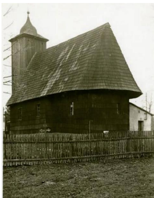
Widok kościoła od południowego wschodu, fotografia z 1936 r. Źródło: http://www.fototekaslaska.pl/zdjecie.php?zd=1373&dz=116 , dostęp: 04.09.2018 r.
