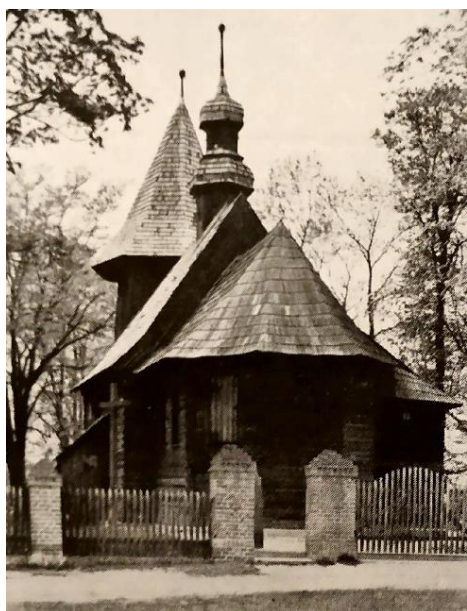
Widok kościoła od południowego wschodu [221]
