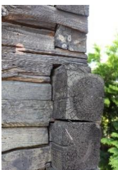
Widok fragmentu zrębu ścian. Fotografia własna, 2019 r.
