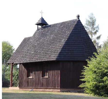
Kaplica zlokalizowana w północnej części działki. Fotografia własna, 2017 r.
