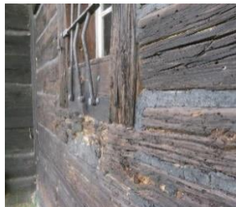
Widok fragmentu południowej ściany prezbiterium. Fotografia własna, 2014 r.
