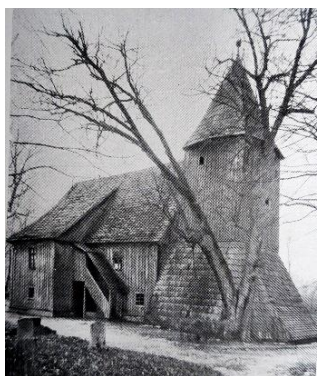
Widok kościoła od północnego zachodu [55]
