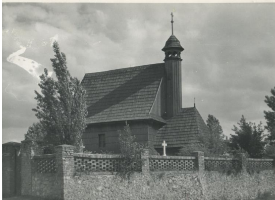
Widok kościoła od północnego zachodu. Źródło: WUOZ w Katowicach, delegatura w Częstochowie, fotografia z 1958 r.
