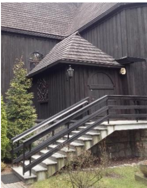
Widok południowej kruszty. Fotografia własna, 2018 r.
