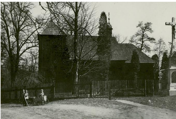
Widok kościoła od południa. Źródła: WUOZ w Katowicach
