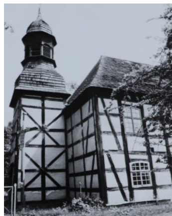
Widok fragmentu kościoła od południa. Źródło: WUOZ w Opolu, fotografia z 1982 r.
