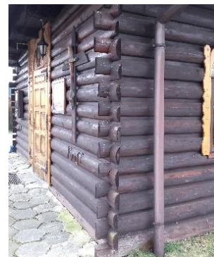
Widok połączenia ścian bez ostateków. Fotografia własna, 2018 r.
