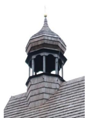
Widok hełmu wieży na sygnaturkę. Fotografia własna, 2019 r.
