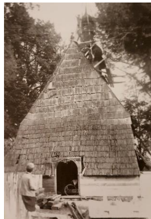
Widok kościoła w Przyszowicach [110]
