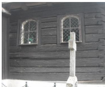
Widok południowej ściany prezbiterium. Fotografia własna, 2014 r.
