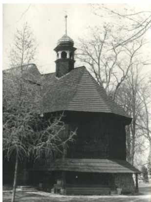
Widok fragmentu południowo-wschodniej elewacji kościoła [KE_051]
