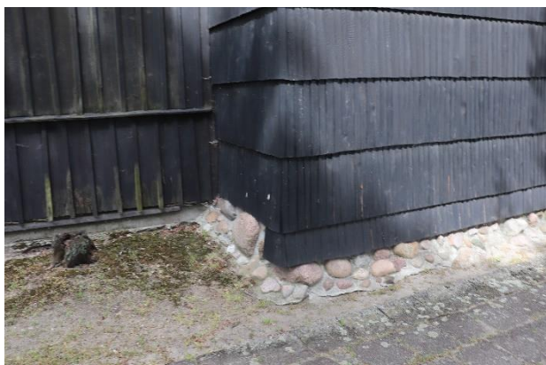
Widok fragmentu posadowienia kościoła. Fotografia własna, 2021 r.
