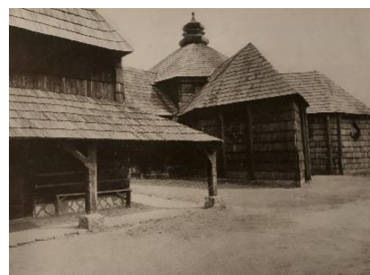
Widok fragmentu elewacji zachodniej wraz z widokiem bocznych kaplic [239]
