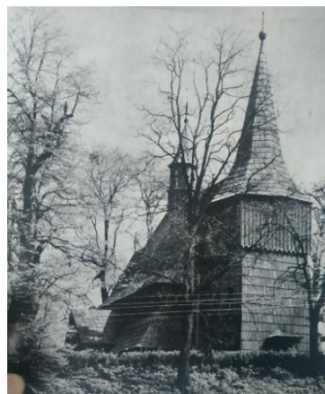
Widok kościoła od północnego zachodu [239]
