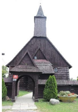
Widok elewacji frontowej, zachodniej. Fotografia własna, 2021 r.
