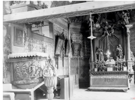
Wnętrze kościoła z widokiem na prezbiterium przed przebudową w 1929 r. [336]
