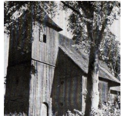
Widok fragmentu kościoła od południowego zachodu [243]
