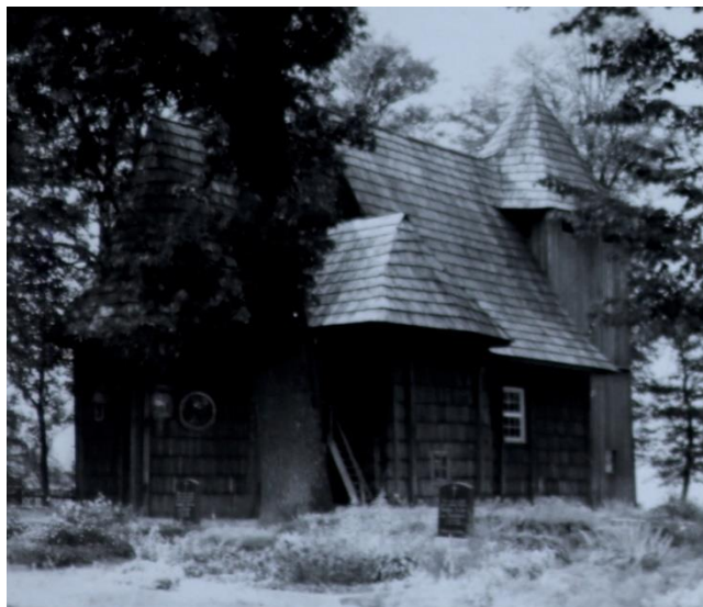
Widok kościoła od północnego wschodu. Źródło: WUOZ w Opolu, fotografia sprzed 1939 r.
