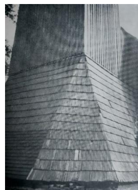
Widok fragmentu fartucha osłaniającego słupową konstrukcję wieży [237]
