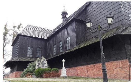
Fragment elewacji północnej. Fotografia własna, 2018 r.
