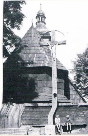
Widok kościoła w Przyszowicach [110]
