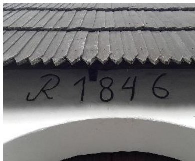
Widok fragmentu bramy z datą jego budowy. Fotografia własna, 2018 r.
