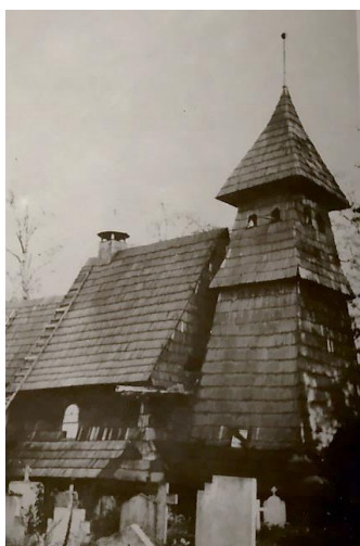
Widok północnej elewacji kościoła przed relokacją do Palowic [219]
