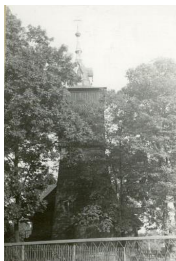
Widok fragmentu elewacji zachodniej [KE_031]
