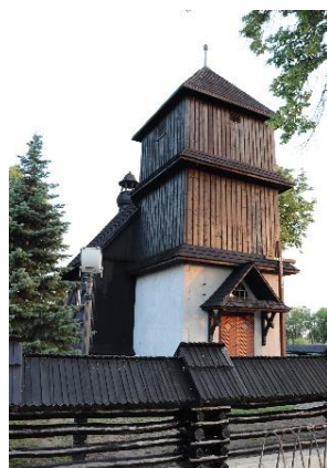
Fragment elewacji północno-wschodniej. Fotografia własna, 2019 r.
