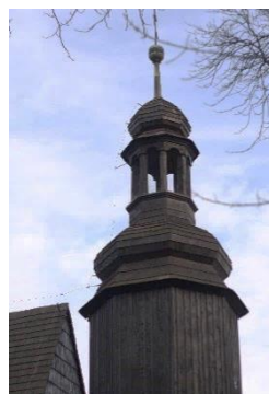
Widok hełmu wieży. Fotografia własna, 2020 r.
