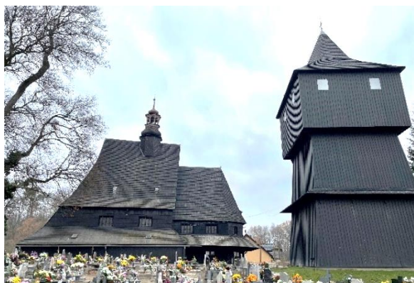
Widok kościoła oraz wolno stojącej dzwonnicy. Fotografia własna, 2020 r.
