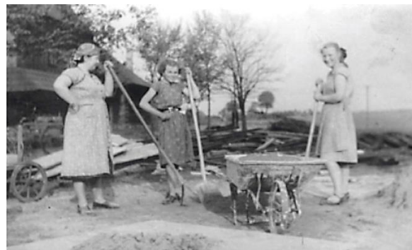
Widok montażu kościoła w Mikołowie-Borowej Wsi [283]
