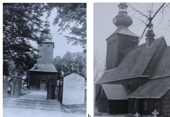
Widok kościoła: a. widok od zachodu, b. fragment elewacji południowo-wschodniej. Źródło: WUOZ w Katowicach, delegatura w Bielsku-Białej
