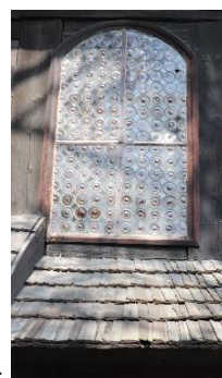
Widok stolarki okiennie-drzwiowej: a. drzwi zewnętrzne wpisane w zachodnią ścianę nawy, b. drzwi zewnętrzne w południowej ścianie nawy, c. gomółkowe okno w północnej ścianie nawy, d. zakratowane okno doświetlające zakrystię. Fotografie własne, 2019 r.
