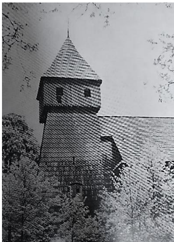
Widok kościoła pw. św. Barbary w Jedlniku, przed relokacją do Jastrzębia-Zdroju [239]
