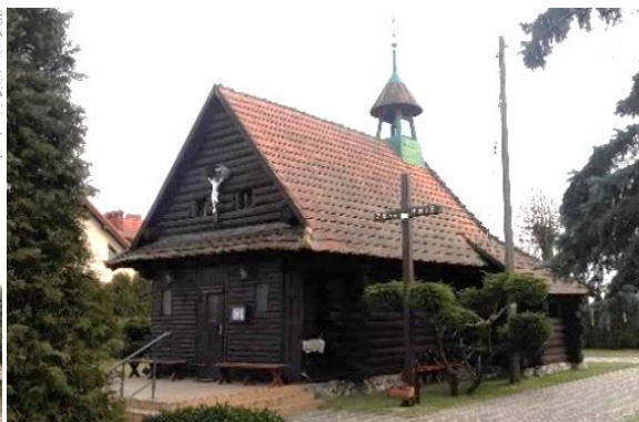
Widok elewacji północno-wschodniej. Fotografia własna, 2018 r.
