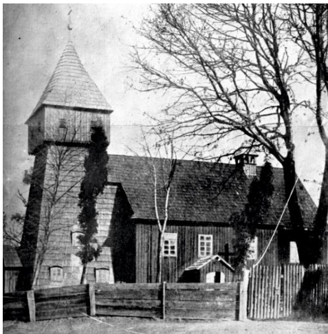
Widok kościoła pw. św. Barbary w Jedlniku, przed relokacją do Jastrzębia-Zdroju [208]
