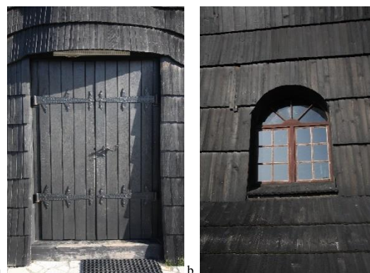
Widoki stolarki okiennie-drzwiowej: a. drzwi w zachodniej ścianie wieży, b. okno w południowej ścianie nawy. Fotografie własne, 2020 r.
