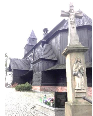
Fragment elewacji południowo-wschodniej. Fotografia własna, 2018 r.
