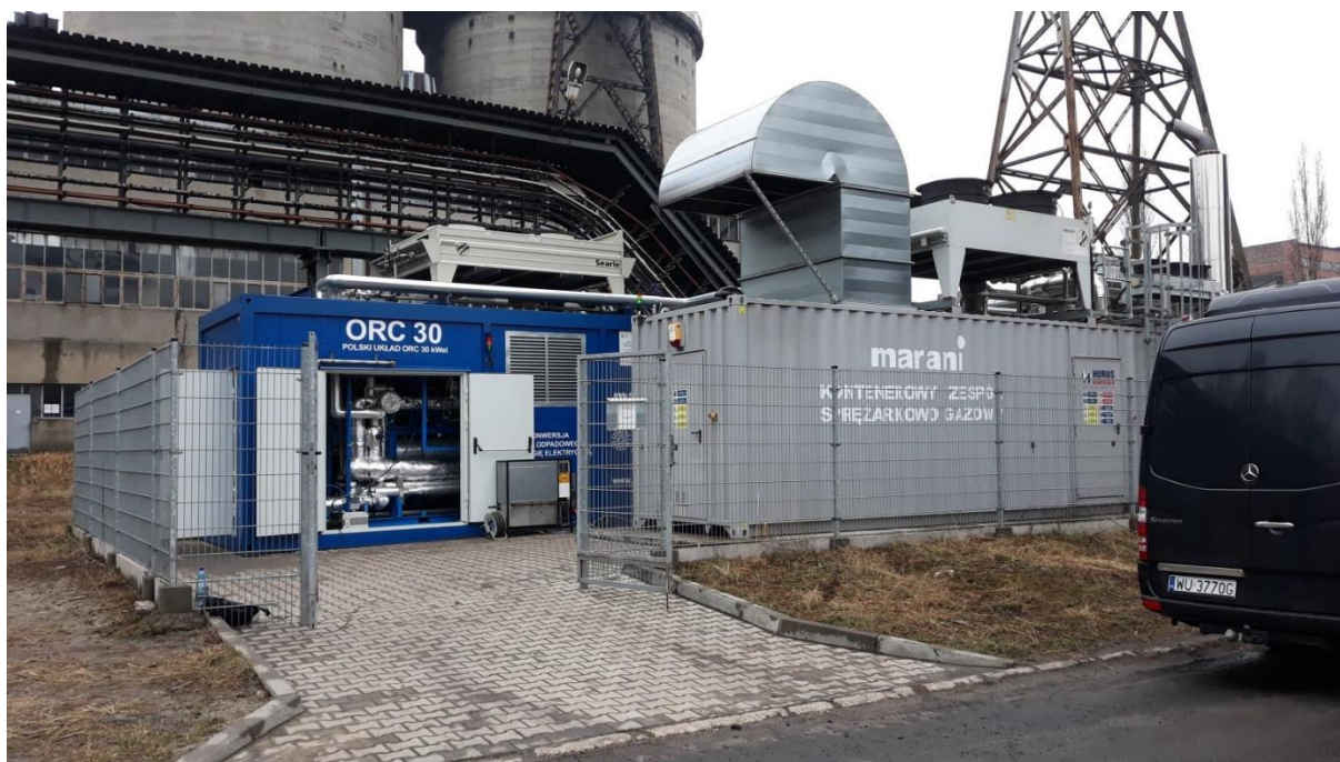
Rysunek 5.12. Prototyp Marani ORC30 w docelowej lokalizacji pracy. Aplikacja dla silnika o mocy mechanicznej 393 kW.
