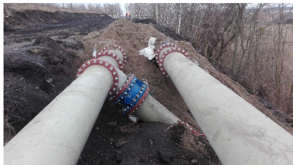
Rys. 1. Łączone przez skręcenie stalowe rury z wykładkami kompozytowymi Fig. 1. Steel pipes with composite liner joined by twisting Źródło: opracowanie własne
