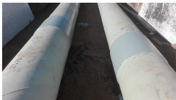
Rys. 2. Rurociągi stalowe z wykładkami kompozytowymi łączone przez spawanie pośrednich tulei i pierścieni Fig. 2. Steel pipes with composite liners joined by welding of intermediate sleeves and rings Źródło: opracowanie własne
