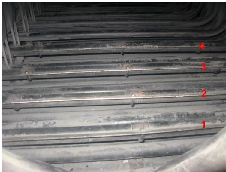
Rys. 2.19. Pierwszy rząd rur pęczka bezpośrednio po zamontowaniu nakładek żebrowych Fig. 2.19. The first row of tubes of a bundle immediately after the installation of fin overlays
