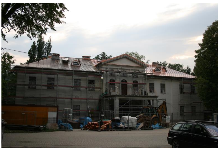
Obiekt w lokalizacji (w trakcie odbudowy po pożarze w roku 2010).
