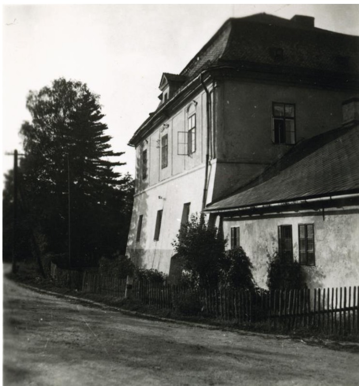
Widok części skrzydła południowego. Lata międzywojenne (do 1945 roku). Ze zbiorów Mariusza Makowskiego
