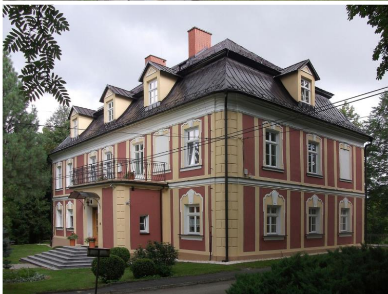
Elewacja główna po remoncie (rok 2017).
