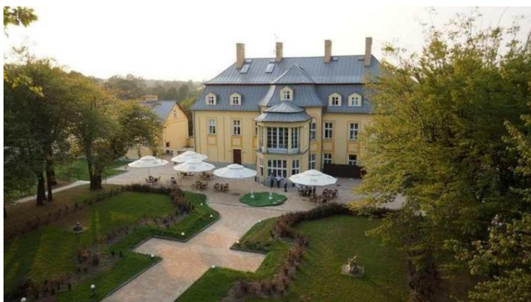
Pałac z lotu ptaka. Elewacja ogrodowa. https://www.proinvestdata.pl/palackotulinski/
