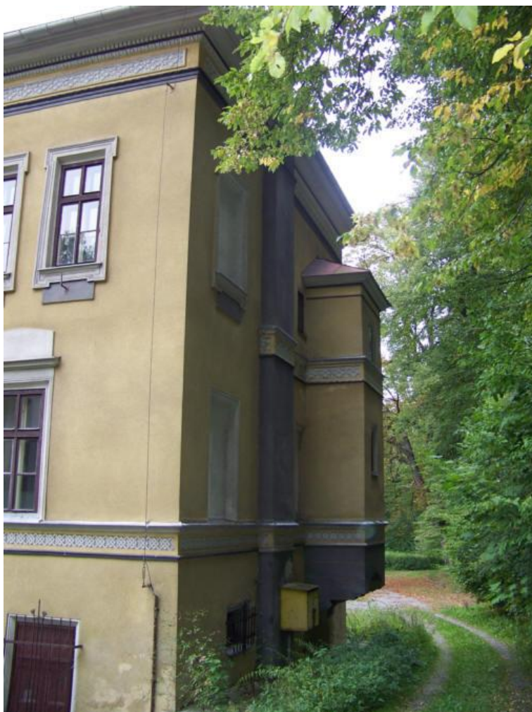
Elewacja północna skrzydła wschodniego.
