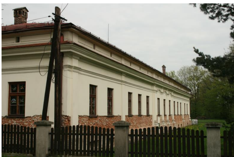
Elewacja południowa skrzydła południowego. Dokumentacja własna
