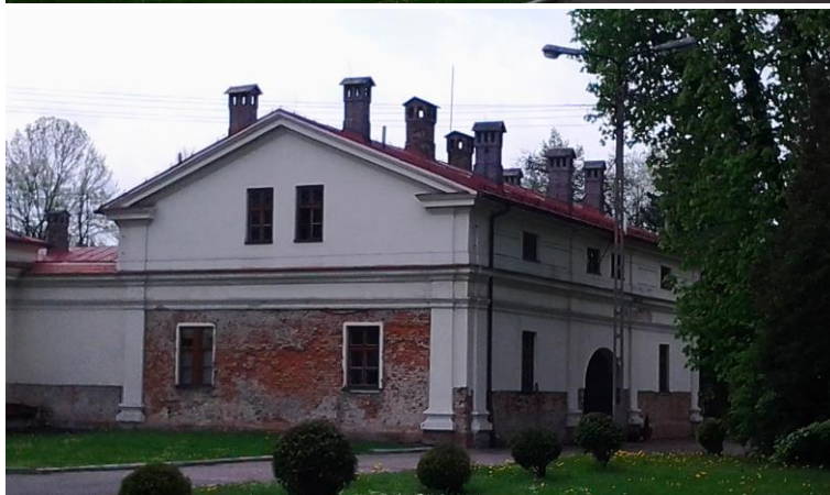
Budynek bramny. Elewacja wschodnia i północna. Dokumentacja własna
