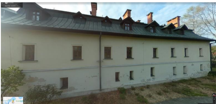
Skrzydło południowe od strony wjazdu.
