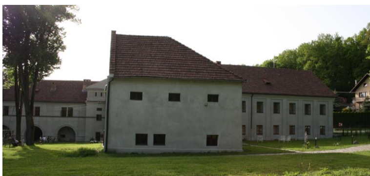
Widok od północy. Dokumentacja własna
