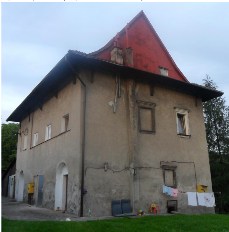
Elewacja północna i elewacja zachodnia. Dokumentacja własna
