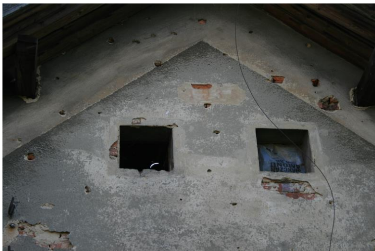
Otwory strychowe elewacji północnej. Dokumentacja własna
