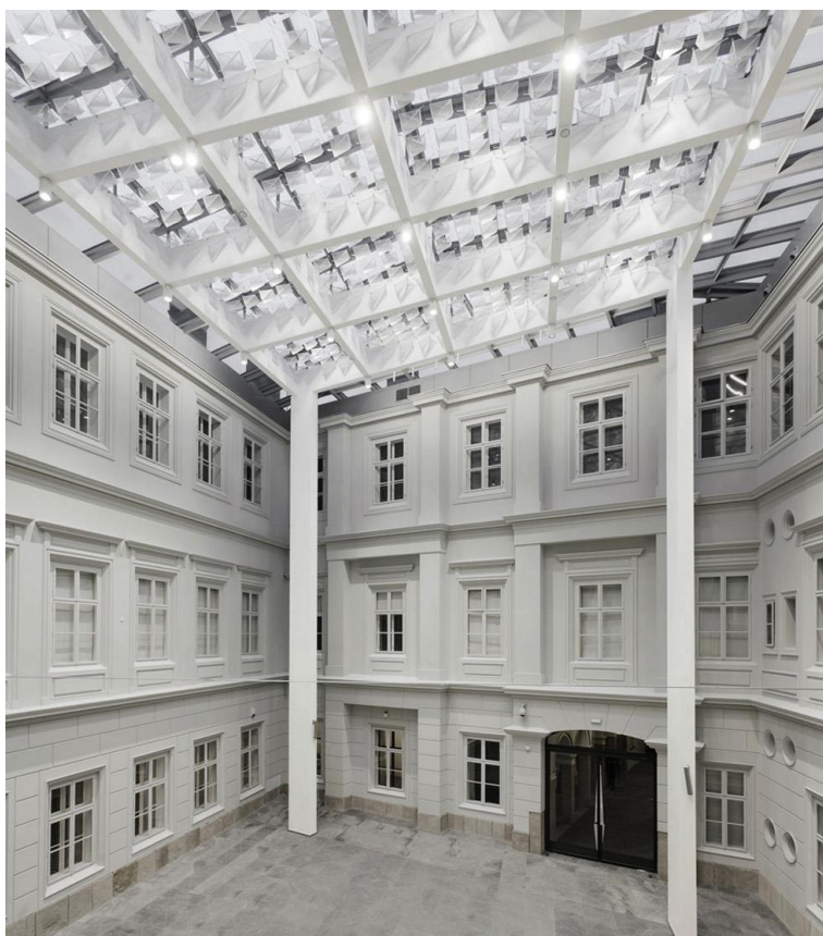
Dziedziniec. Skrzydło zachodnie i północne. Zadaszenie projektu pracowni Projekt Praga. https://architektura.muratorplus.pl/zycie-w-architekturze/2015/dziedziniec-zamku-sulkowskich-w-bielsku-bialej/1409/
