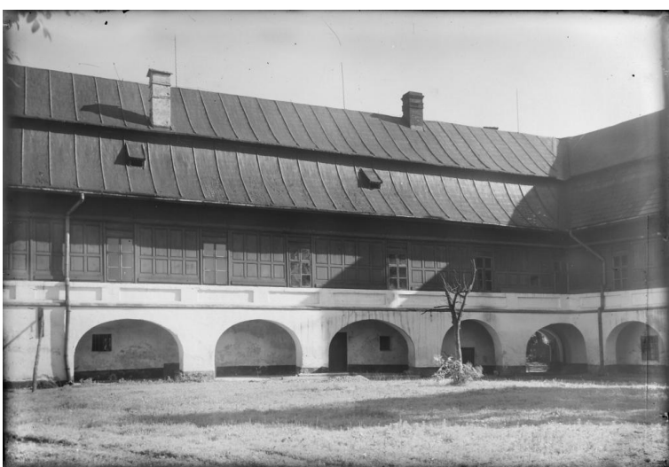
Skrzydło południowe od dziedzińca. Widoczna zabudowa podcieni panelami drewnianymi. http://zamek.konczyce.pl/o-goscincu/
