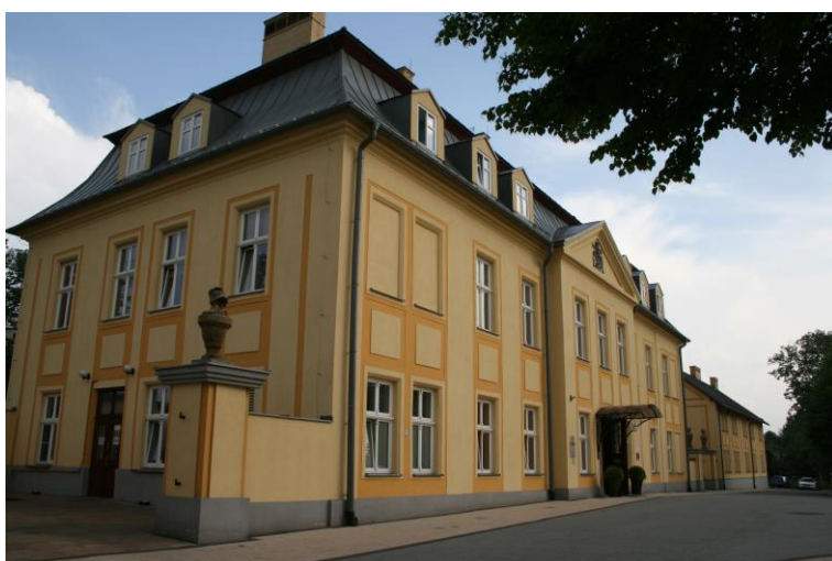
Elewacja północna i zachodnia. Dokumentacja własna
