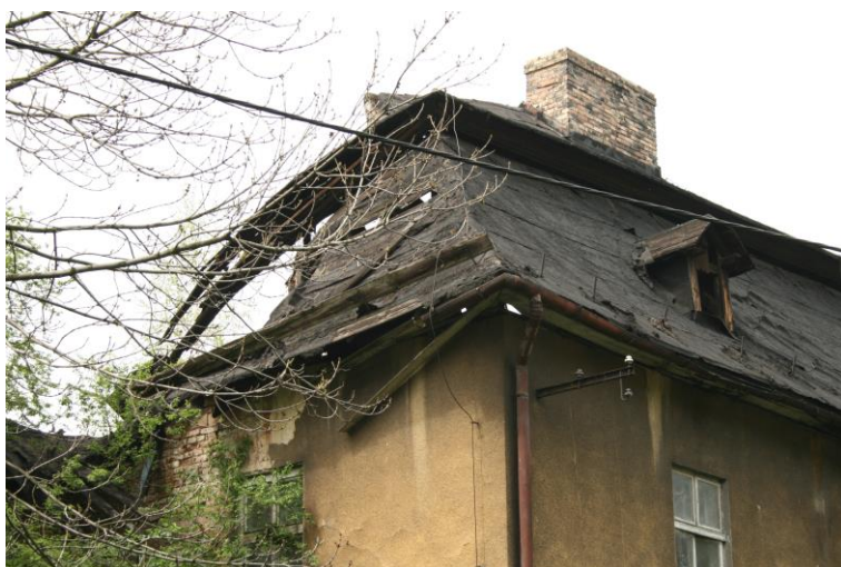
Szczegóły dachu. Dokumentacja własna
