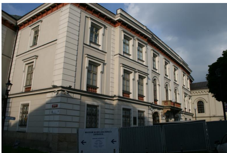
Pozostała część elewacji zachodniej i elewacja południowa. Dokumentacja własna
