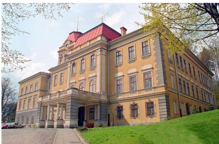
Widok pałacu w roku 2005 (widoczna elewacja wschodnia). http://www.polskiezabytki.pl/m/obiekt/5324/Konczyce_Wielkie/
