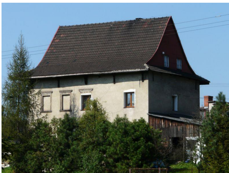
Obiekt w lokalizacji. Elewacja południowa i wschodnia.
