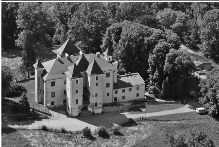
Elewacja ogrodowa i widok z lotu ptaka (lata 60-te XX wieku) Ze zbiorów Mariusza Makowskiego
