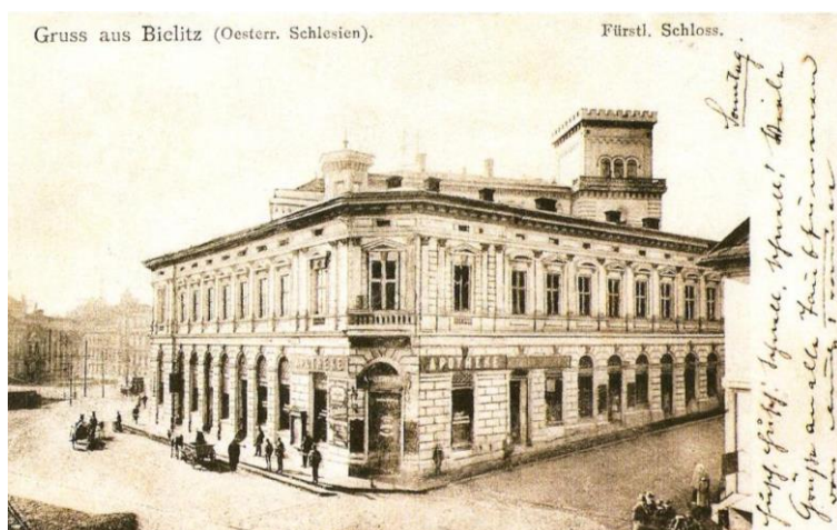
Bazary Zamkowe (kamienica narożna) widoczne z "Patrii" w 1905 r. Nad dachami widoczny fragment zamku. Kamienicę zbudowano na miejscu książęcej gorzelnii. https://bielskobiala.fotopolska.eu/7973,foto.html?o=b424&p=1
