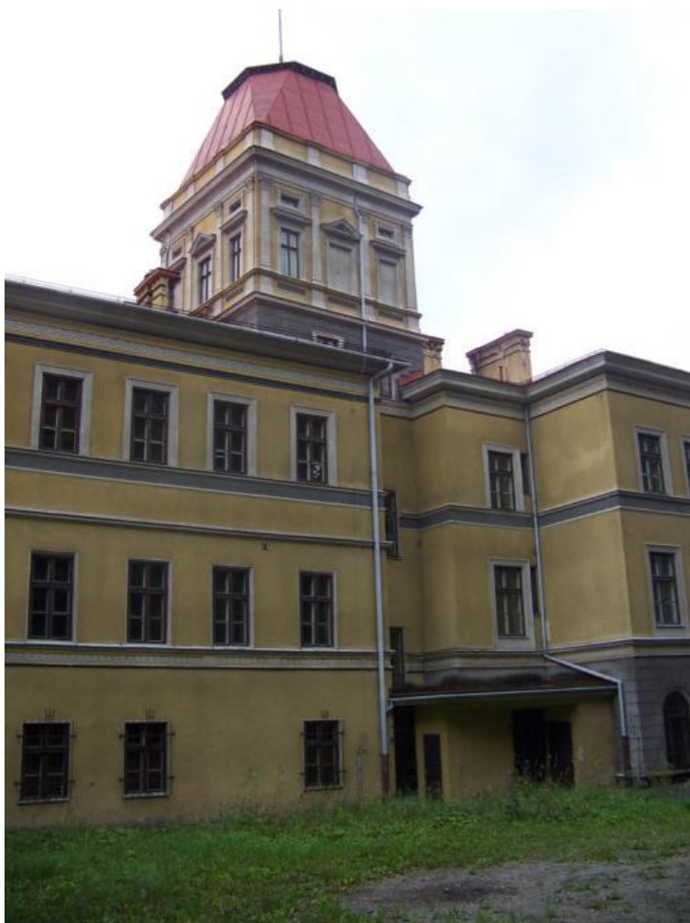
Elewacja północna skrzydła zachodniego (części dobudowanej).
