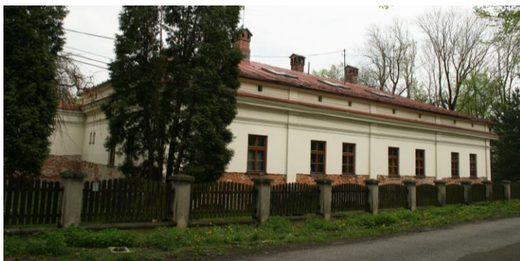
Elewacja północna i zachodnia skrzydła zachodniego. Dokumentacja własna
