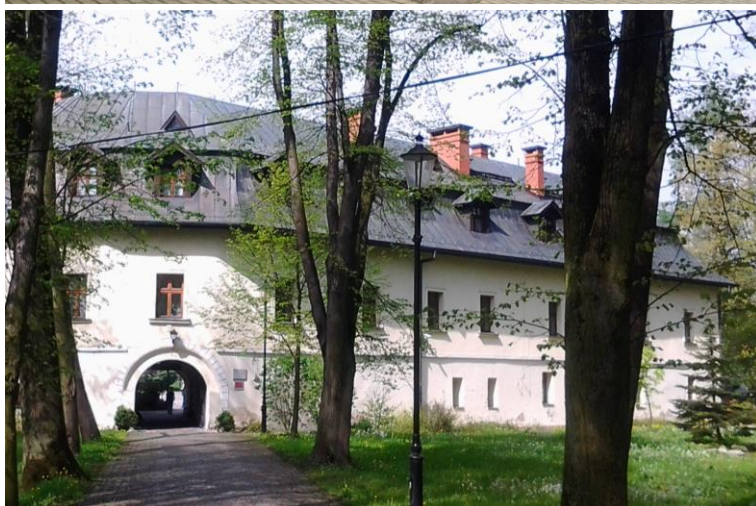
Skrzydło południowe od strony dziedzińca i wjazdu. Dokumentacja własna
