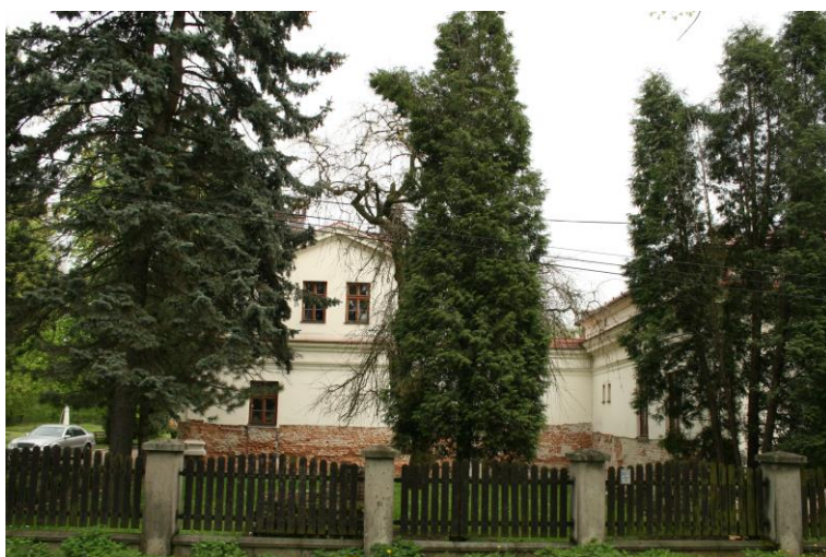
Budynek bramny. Elewacja zachodnia. Dokumentacja własna
