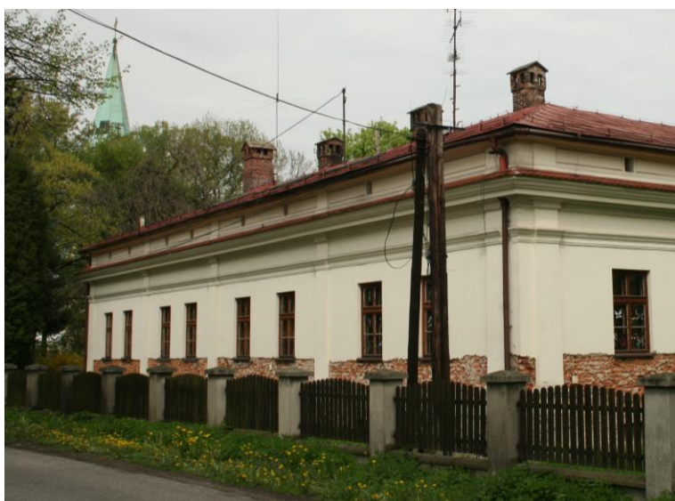
Elewacja zachodnia skrzydła zachodniego. Dokumentacja własna
