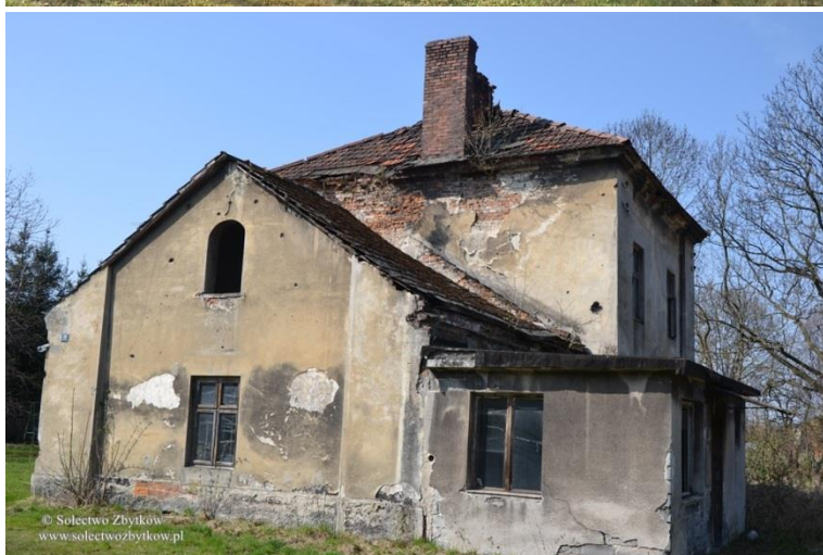
Elewacja wschodnia w roku 2012
