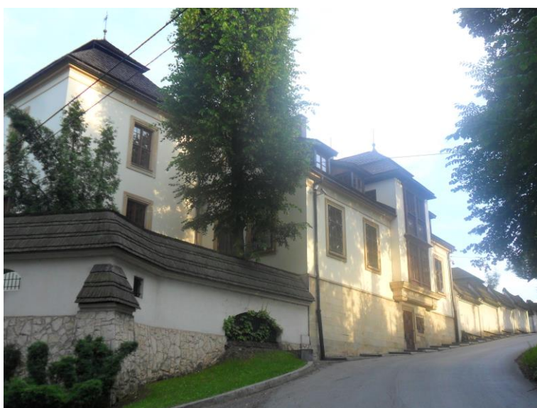
Elewacja północna i zachodnia. Dokumentacja własna
