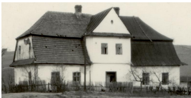
Rys.IV.25. Pięcioosiowy, parterowy dwór z dachem naczółkowym łamanym w Szobiszowicach Dolnych (Z.II t.4 cz.3)
