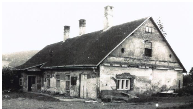
Rys.IV.24. Siedmioosiowy, parterowy dwór z dachem 2-spadowym w Wędrynie (Z.II t.5 cz.2)
