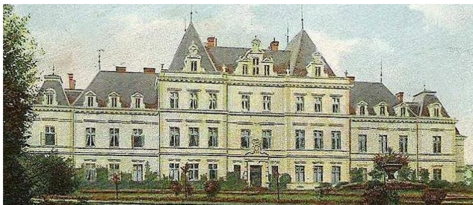
Rys.IV.28. Widok pałacu ziemiańskiego (16-osiowego) w Solcy z dachem 4-spadowym (Z.II t.4 cz.3)
