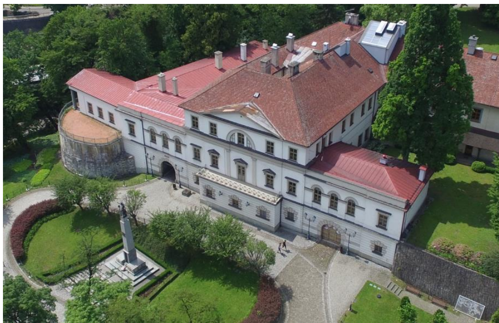
Rys.V.31. Elewacja Pałacu Myśliwskiego
