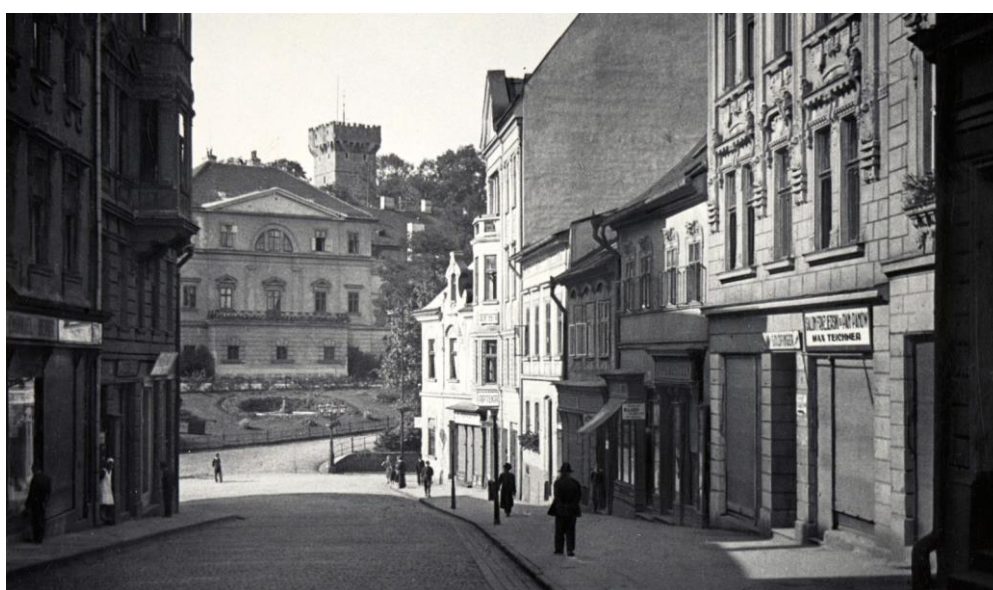
Rys.V.36. Wylot ulicy Głębokiej: u góry około lat 1895-1898, u dołu 1930-1932
