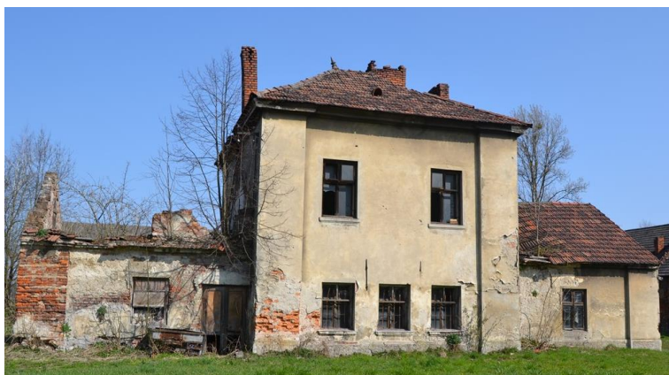
Rys.V.45. Widok dworu w Zbytkowie
