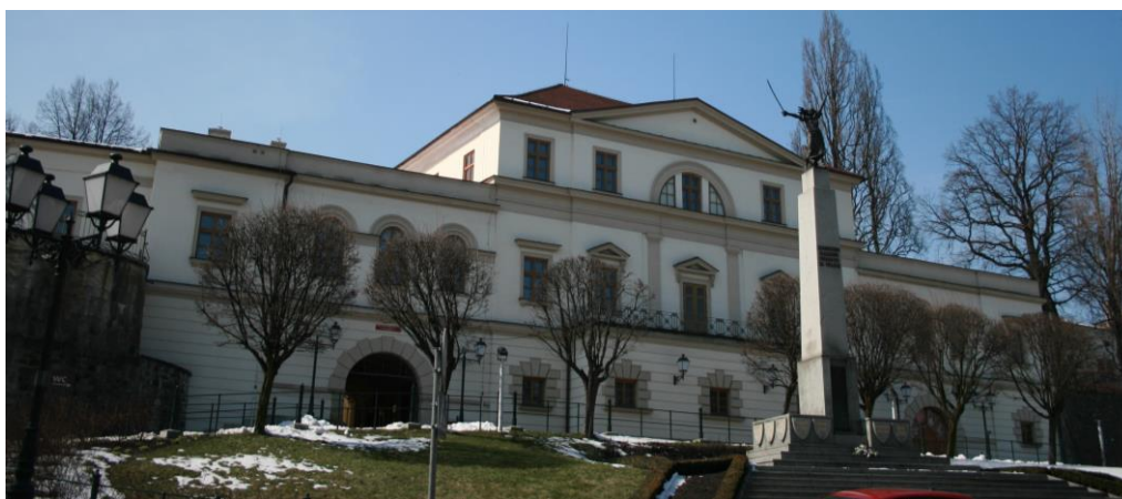
Rys.V.30. Widok fasady Pałacu Myśliwskiego z roku 2015
