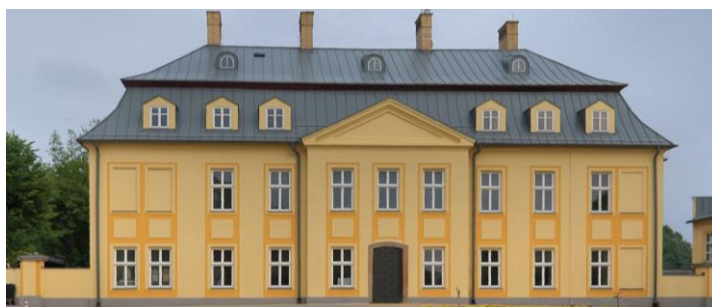
Rys.IV.27. Widok pałacu ziemiańskiego (11-osiowego, 1 oś ślepa) Kotulińskich w Czechowicach z dachem mansardowym w typie francuskim (Z.II t.1 cz.3)
