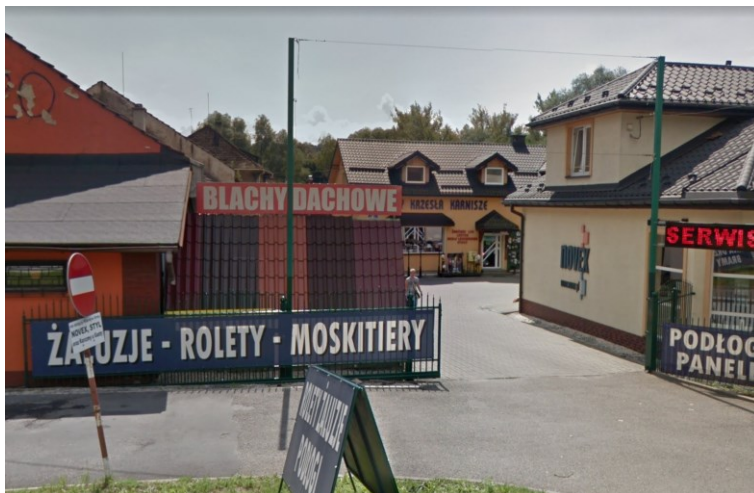
Obecny budynek w lokalizacji (w głębi, pomarańczowy). Google Maps
