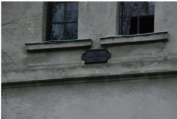
Detal (okna strychu) i tabliczka E.H. ALBRECHT. 1894.
