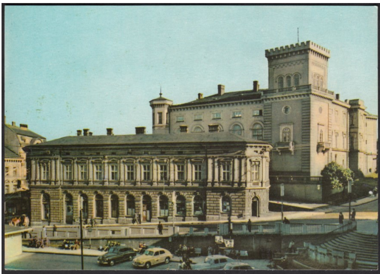
Widok od strony kamienicy narożnej (lata 60-te).
