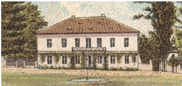
Dwór w Błudowicach Dolnych w roku 1899 od strony podwórza https://havirov.wgz.cz/rubriky/dolni-bludovice/fotogalerie/zamek-v-dolnich-bludovicich-1899
