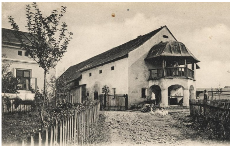
Cześć budynku mieszkalnego i spichlerz (1904)
