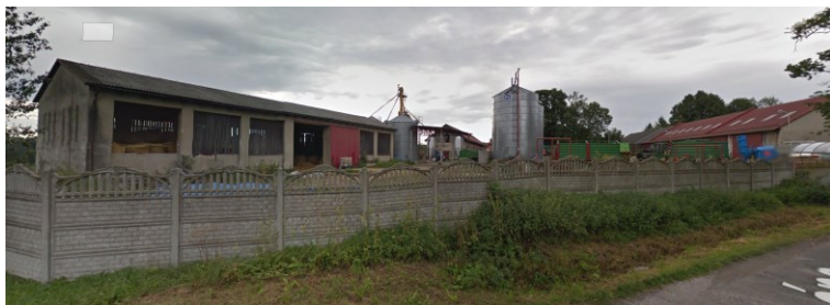
Budynki gospodarcze Google Maps
