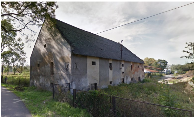
Jeden z nieistniejących obecnie budynków gospodarczych Google Maps
