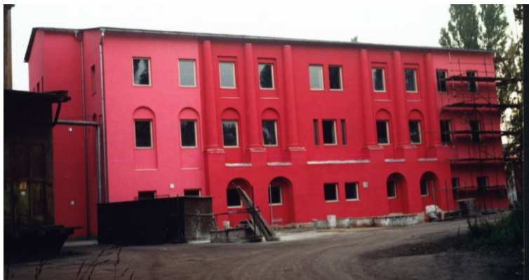
Pałac Końska w latach 90-tych XX wieku. Elewacja północna i część wschodniej. Po remoncie Ze zbiorów Mariusza Makowskiego
