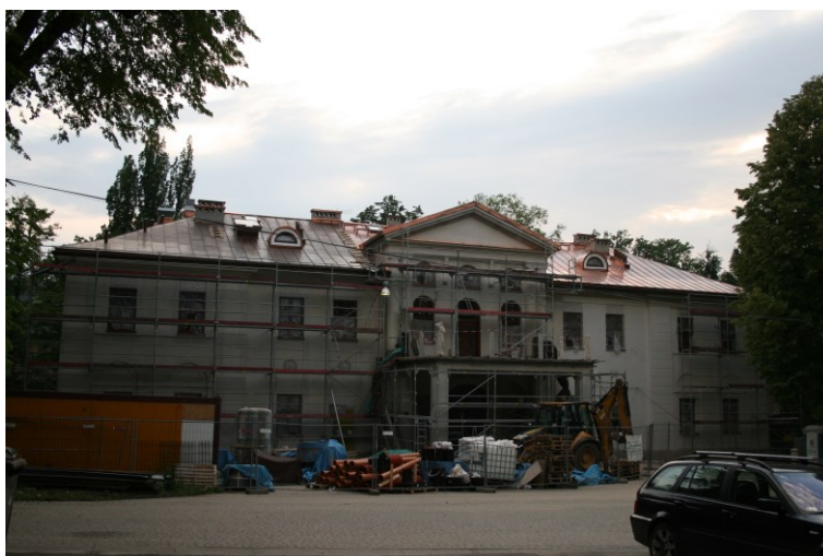
Obiekt w lokalizacji (w trakcie odbudowy po pożarze w roku 2010). Opracowanie własne
