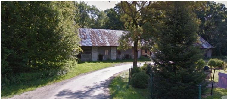
Jedyny pozostały budynek gospodarczy. Google Maps
