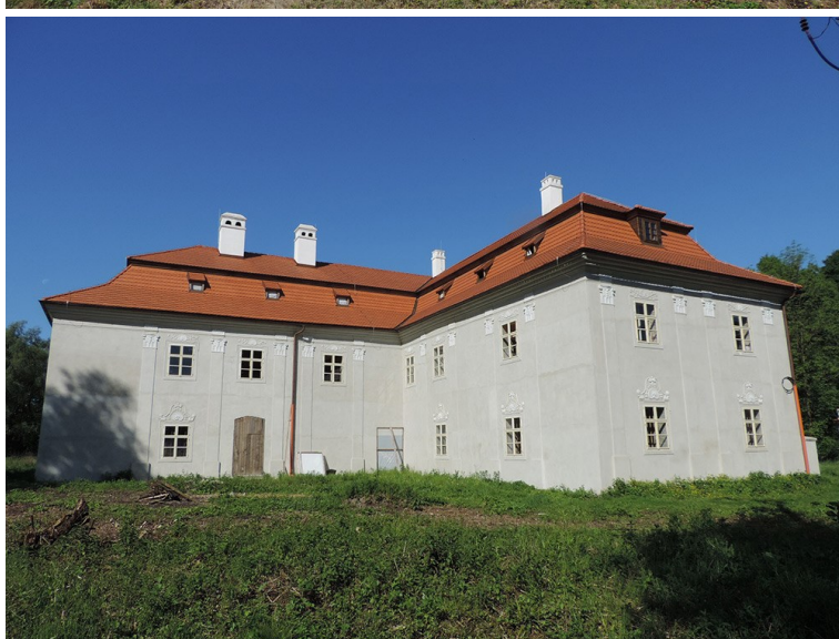
Pałac Ropica po renowacji (około 2016 roku). https://www.smira-print.cz/stavebni-cinnosti/74-ropice-zamek
