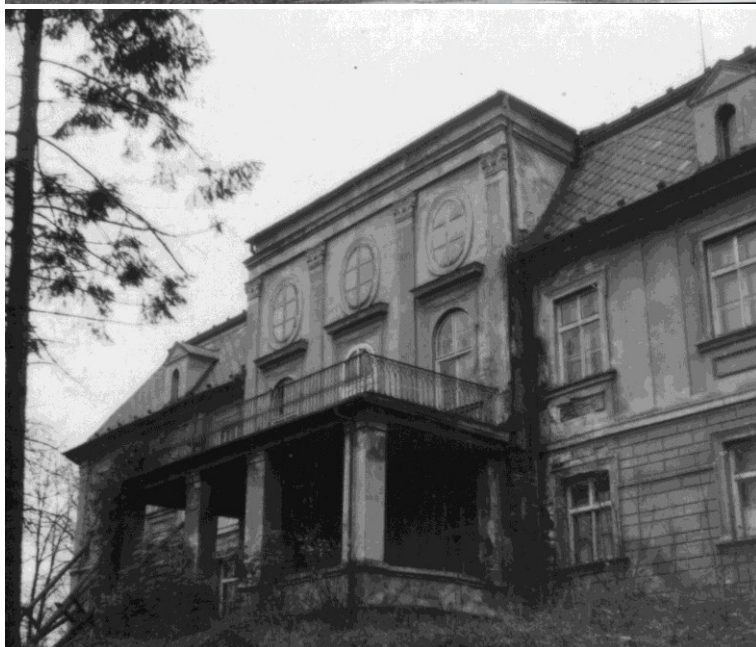
Widoki pałacu po opuszczeniu budynku przez szpital w roku 1968 (około 1971 roku). Ze zbiorów Mariusza Makowskiego
