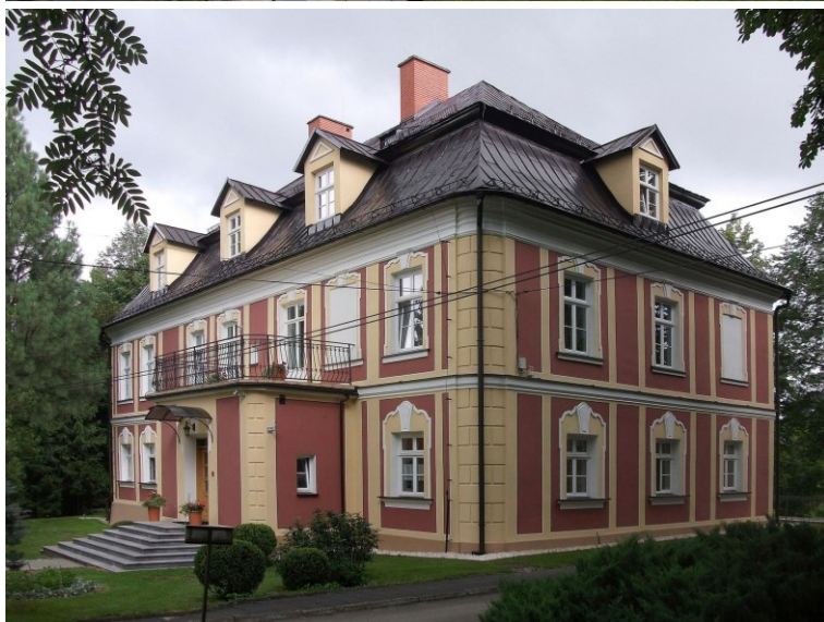
Elewacja główna po remoncie (rok 2017).
