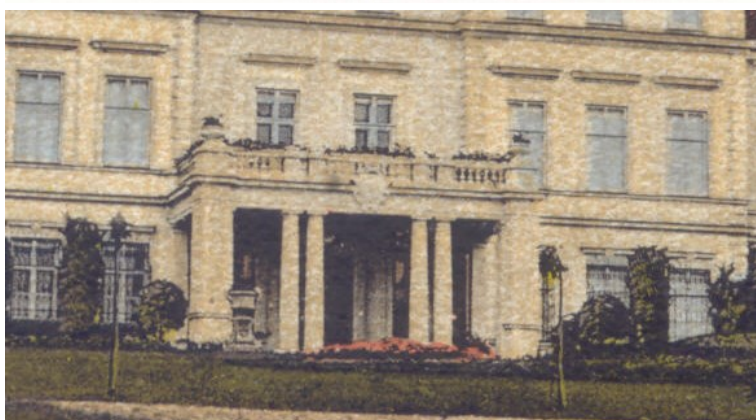
Elewacja północna (fasada) po 1905 roku (widoczny balkon z portykiem)
