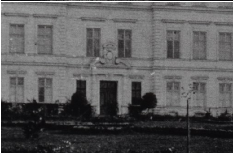
Elewacja północna (fasada) w roku 1890 (brak portyku i balkonu)
