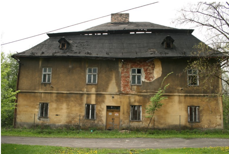
Fasada budynku (elewacja wschodnia)
