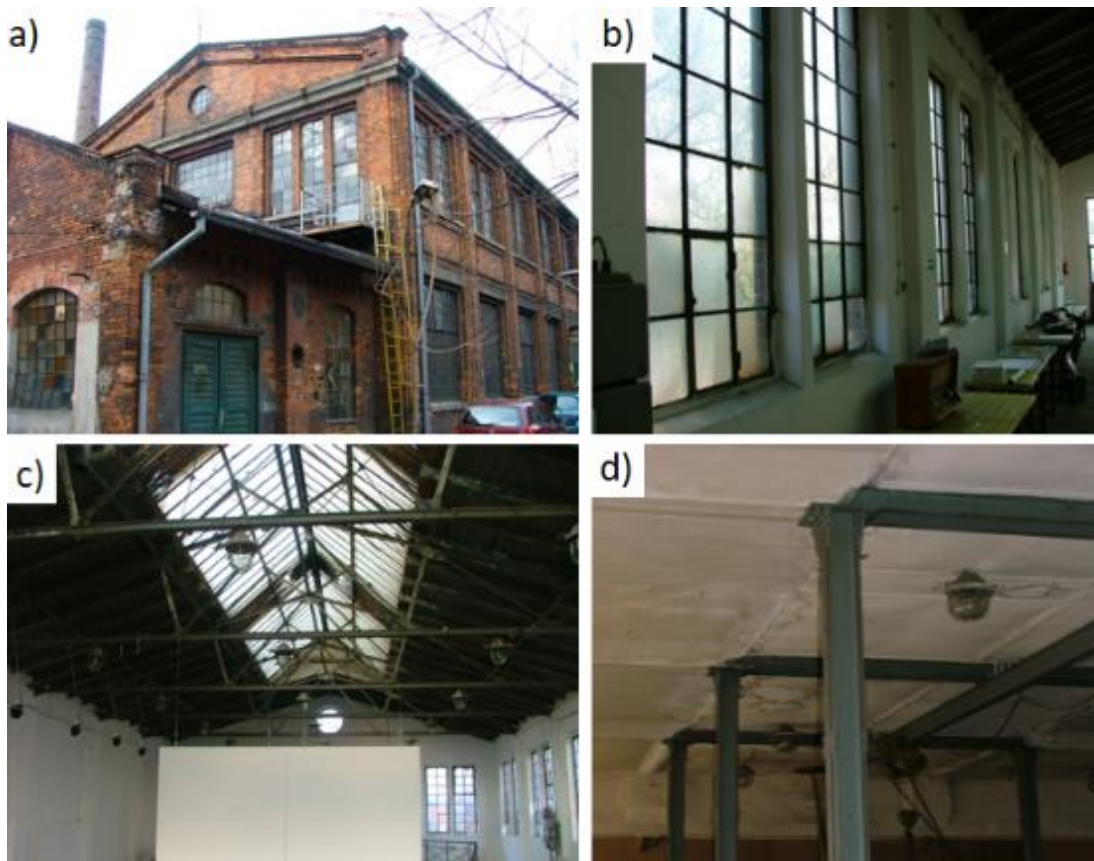
Fig. 19.8. Wire manufacture Gliwice: a) façade, b) interior, c) roof structure, d) ceiling structure Rys. 19.8. Fabryka Drutu Gliwice: a) fasada, b) wnętrze, c) konstrukcja dachu, d) konstrukcja stropu
