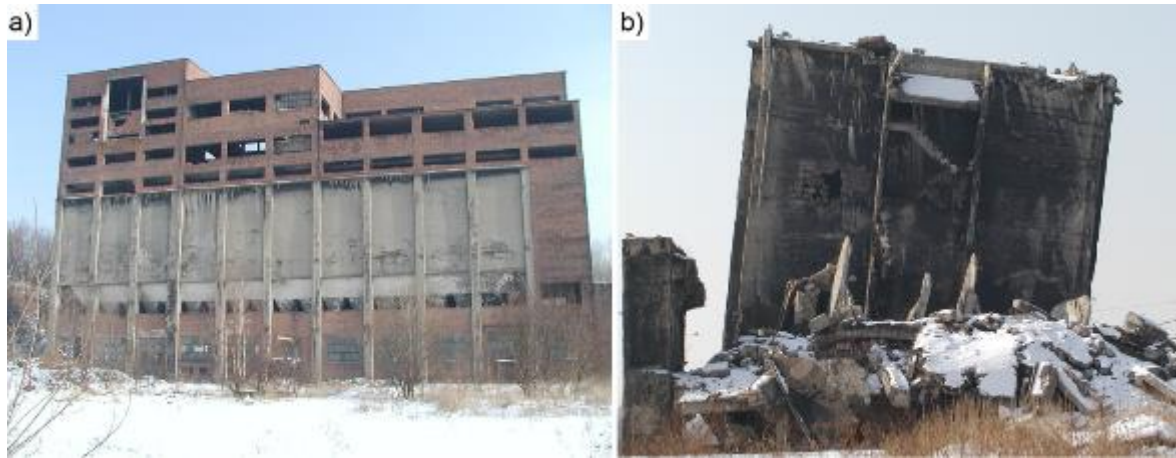
Fig. 19.6. Facilities of the Gliwice coking plant before demolition Rys. 19.6. Budynki koksowni Gliwice przed wyburzeniem
