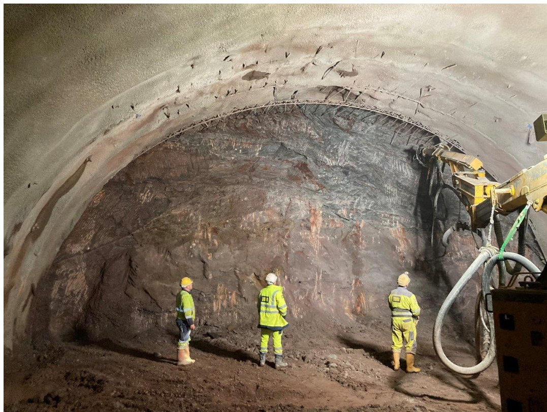
Rys. 7.1. Wiercenie otworów w tunelu na trasie S3 [źródło: mat. pras. GDDKiA] Fig. 7.1. Drilling of tunnel holes on the S3 route [source: press materials GDDKiA]
