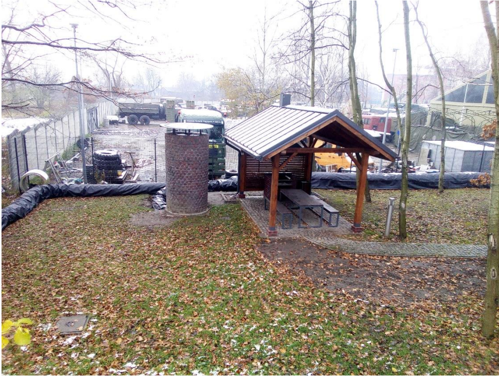
Rys. 14.4. Lutniociąg zainstalowany na powierzchni łączący otwór W(2015) z otworem W(2016) i W(2015a) – rekuperacja – otwór W(2016) [zdjęcie autorskie]
