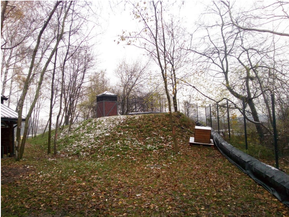
Rys. 14.5. Lutniociąg zainstalowany na powierzchni dla rekuperacji – otwór W(2015a) [zdjęcie autorskie]
