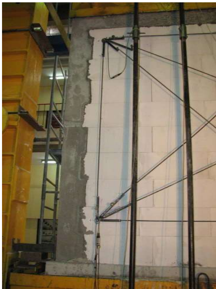
Rys.Z2. 42. Wtórne zarysowania ściany na styku muru i rdzeni
