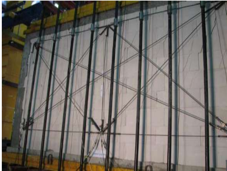
Rys.Z2. 43. Pionowe zarysowania ściany
