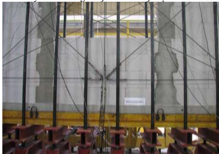
Rys. Z2.211. Zarysowania część pasa podokiennego
