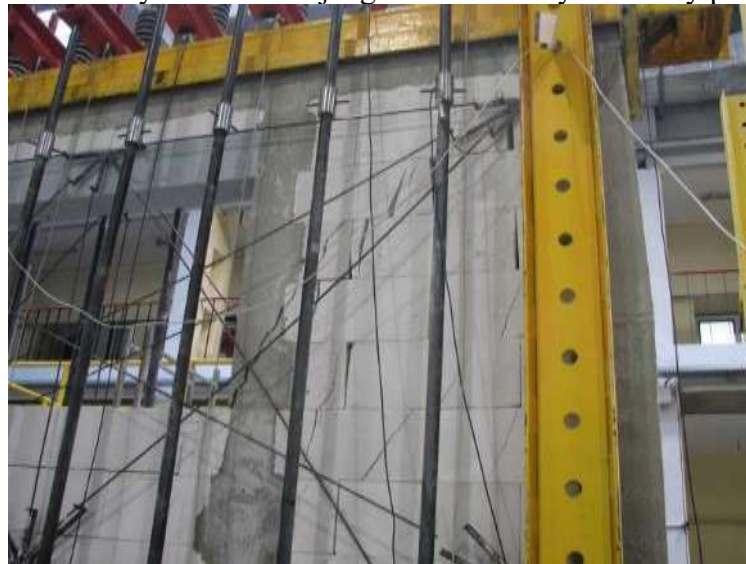
Rys. Z2.194. Zarysowania skrajnego filarka ściany od strony podpory A
