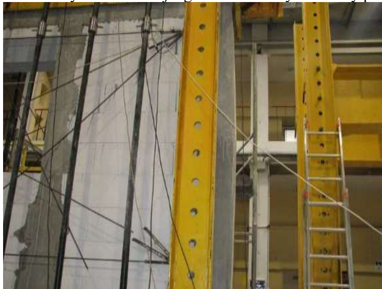
Rys. Z2.174. Zarysowania skrajnego filarka ściany od strony podpory A
