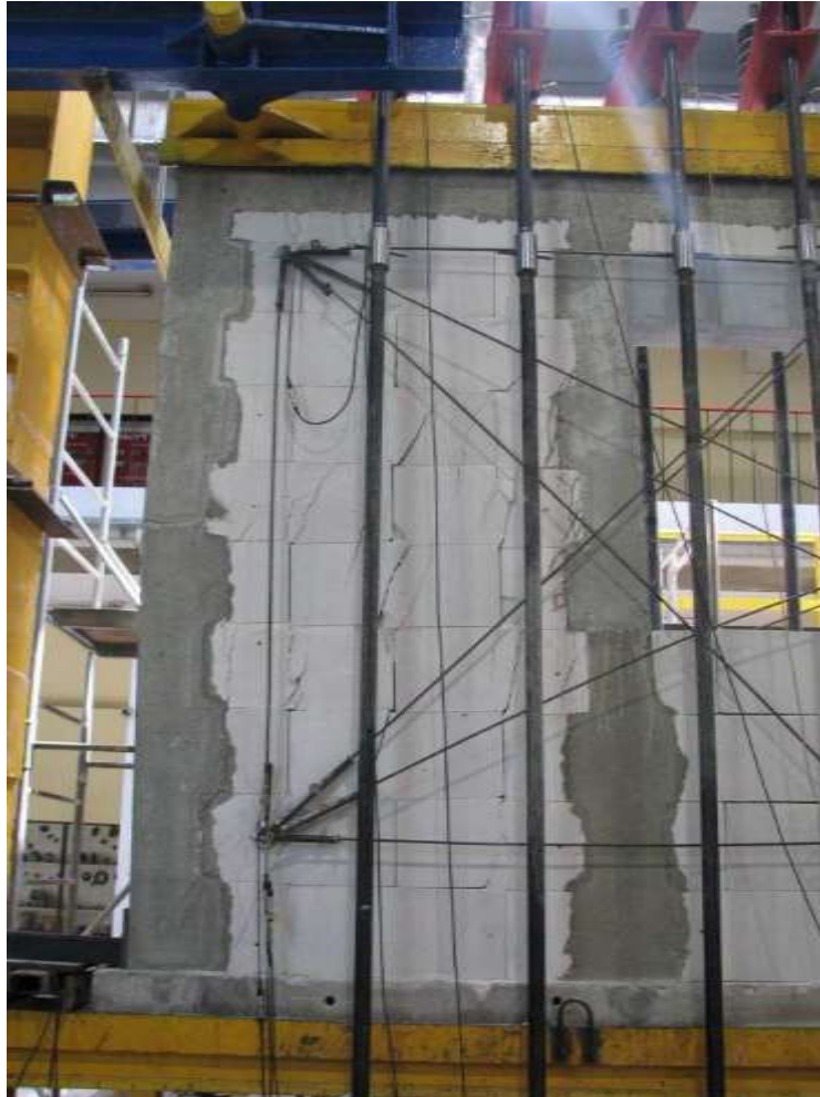
Rys. Z2.247. Zarysowania skrajnego filarka ściany od strony podpory B
