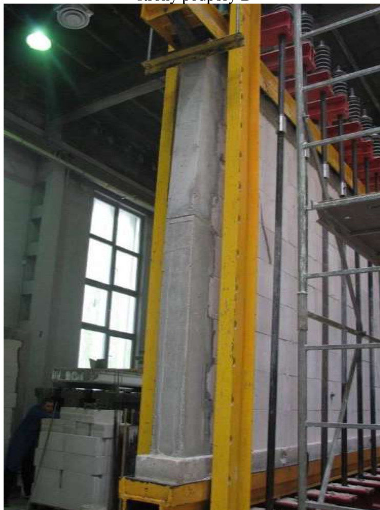
Rys.Z2.19. Zarysowania rdzenia od strony podpory A
