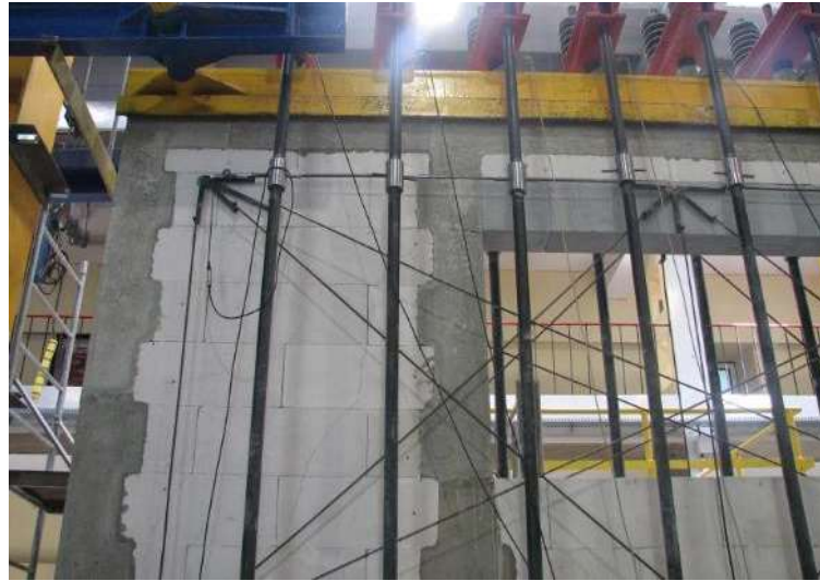
Rys. Z2.209. Wtórne zarysowania środkowej i górnej części filarka od strony podpory B
