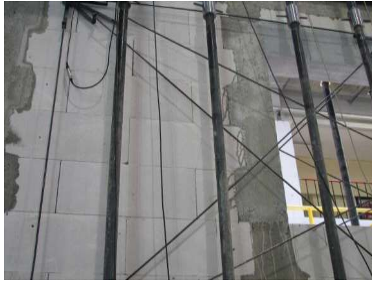
Rys. Z2.242. Pierwsze zarysowania ściany w dolnej części filarka od strony podpory B
