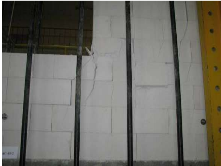
Rys. Z2.160. Zmiażdżenie muru w dolnym narożu otworu okiennego od strony podpory A
