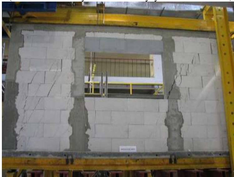
Rys. Z2.201. Widok modelu badawczego HAS-C2-AAC-010/2 w chwili zniszczenia od strony N-N
