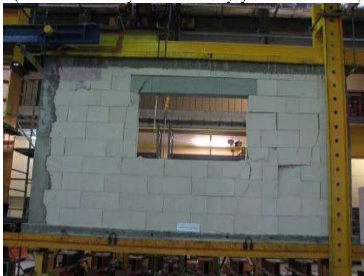
Rys. Z2.163. Widok modelu badawczego HAS-C1-AAC-10/2 w chwili zniszczenia od strony N-N
