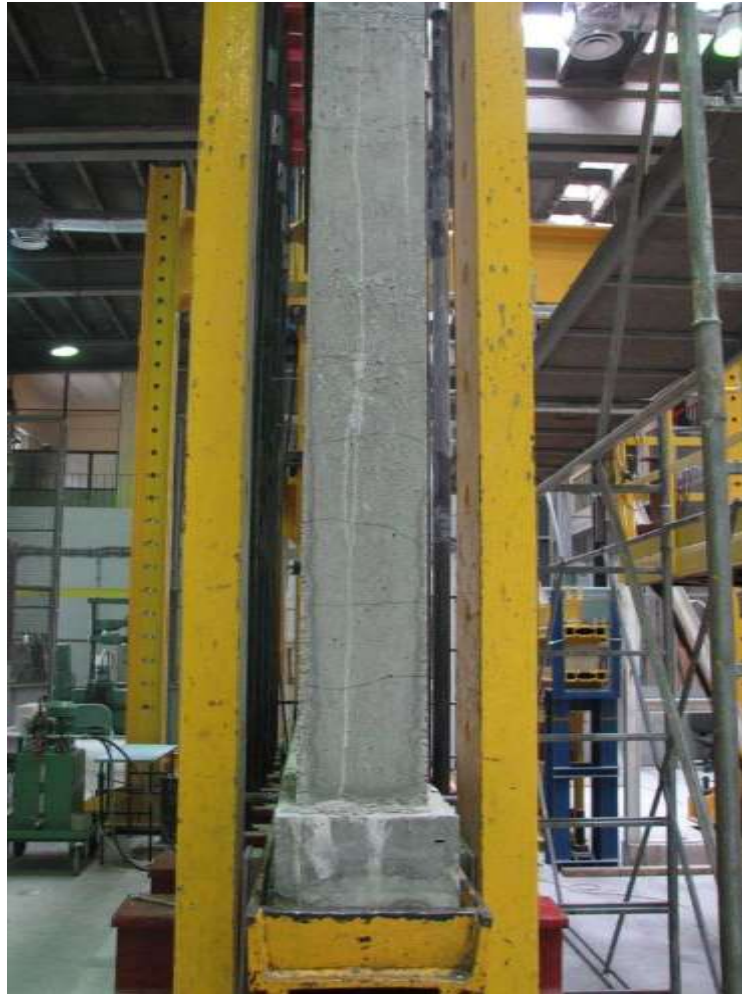
Rys. Z2. 59. Zarysowania dolnej części rdzenia od strony podpory A
