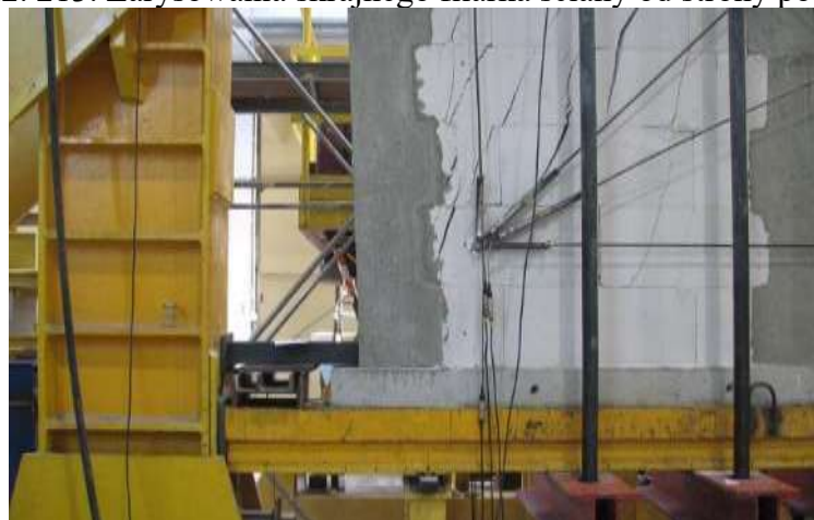
Rys. Z2.214. Zarysowania dolnego połączenia rdzenia i rygla od strony podpory B
