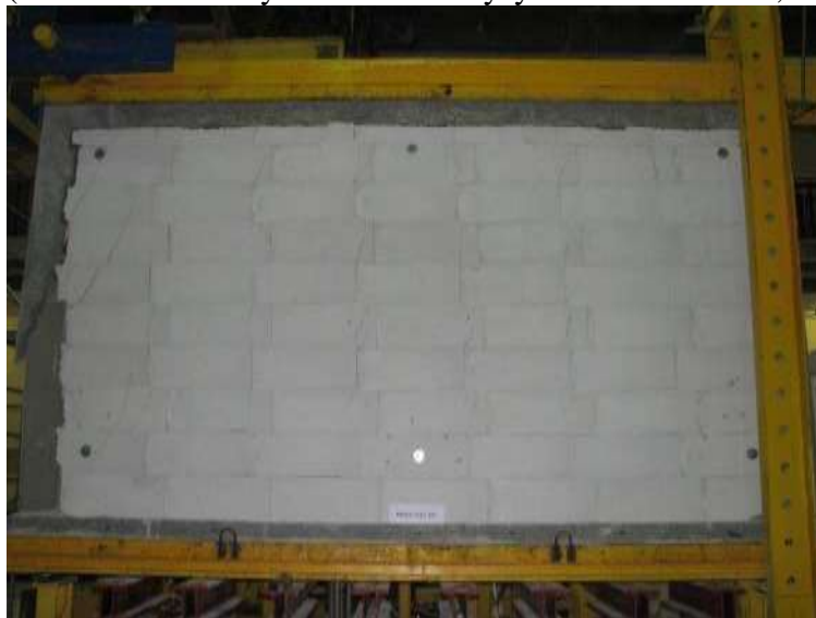
Rys. Z2. 61. Widok modelu badawczego HOS-C-AAC-10/1 w chwili zniszczenia od strony N-N
