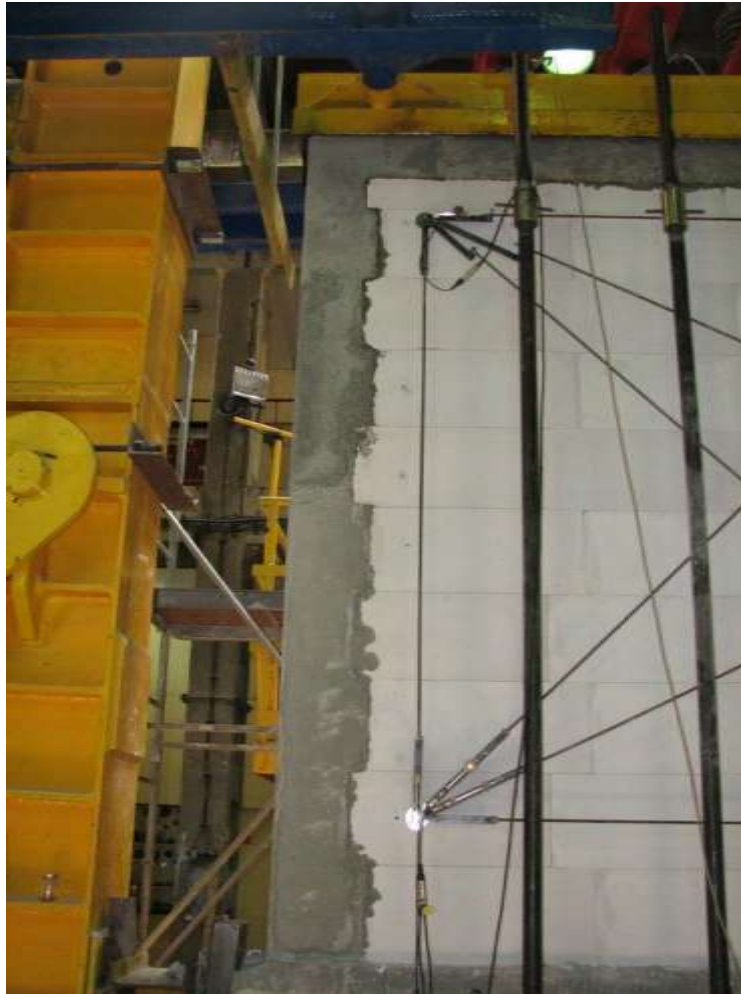
Rys. Z2.69. Wtórne zarysowania ściany na styku muru i rdzeni
