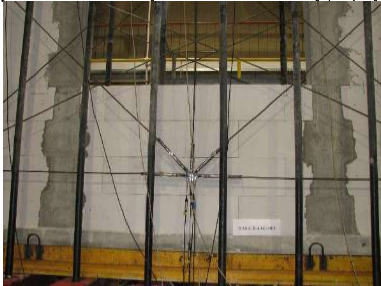
Rys. Z2.264. Zarysowania pasa podokiennego
