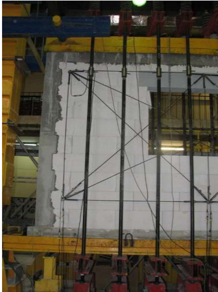
Rys. Z2.143. Zarysowania filarka od strony podpory B
