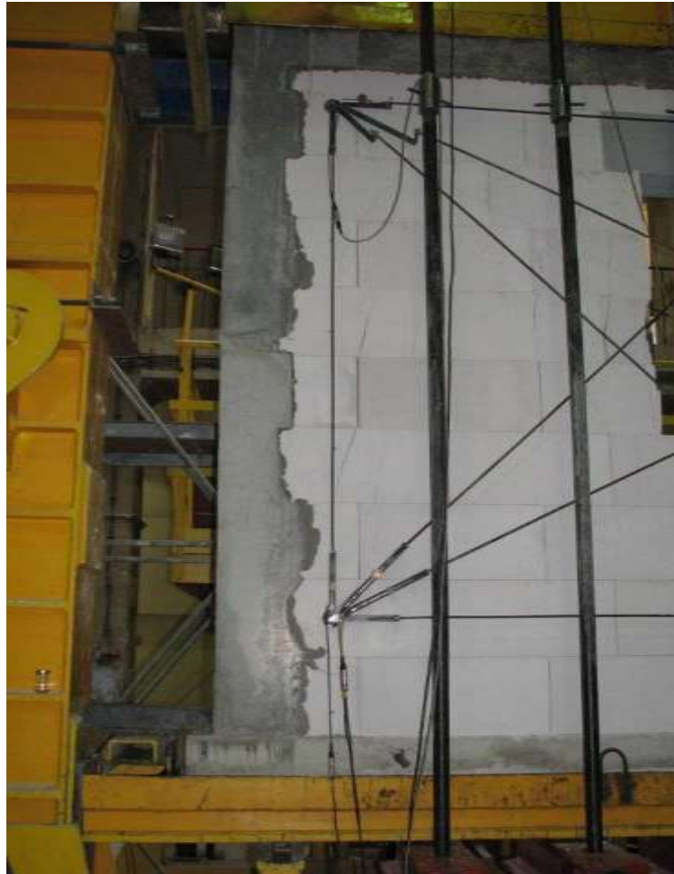
Rys. Z2.115. Zarysowania filarka od strony podpory B
