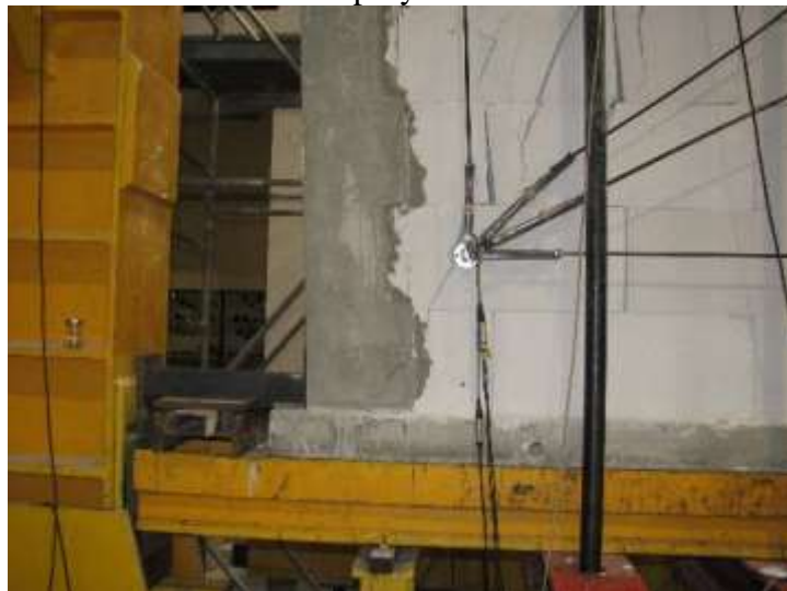
Rys. Z2.269. Zarysowania dolnej strefy rdzenia od strony podpory B
