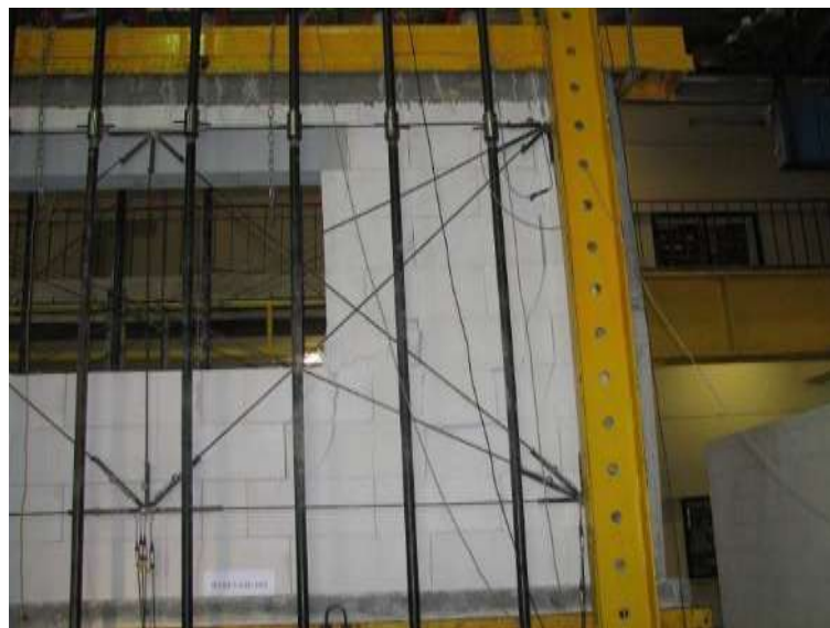
Rys. Z2.157. Zarysowania filarka od strony podpory A
