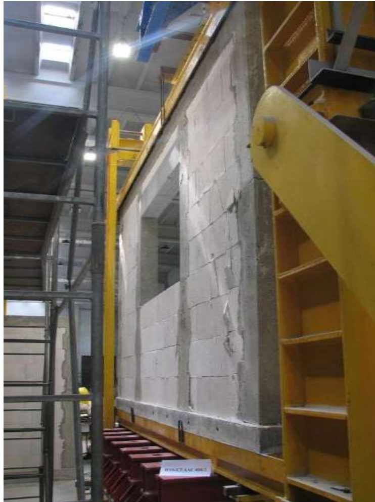
Rys. Z2.202. Widok modelu badawczego HAS-C2-AAC-010/2 w chwili zniszczenia od strony S-S
