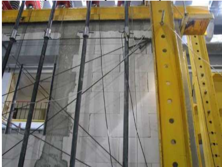
Rys. Z2.189. Pierwsze zarysowania w środkowej części filarka od strony podpory A
