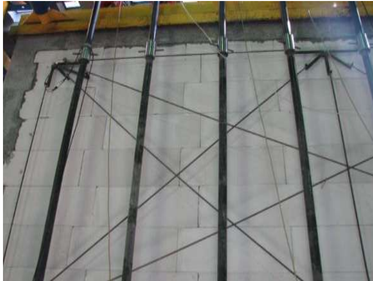
Rys. Z2.67. Pierwsze zarysowania ściany
