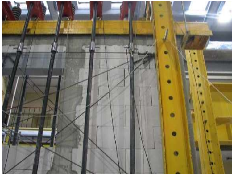
Rys. Z2.191. Wtórne zarysowania w górnej i środkowej części filarka od strony podpory A
