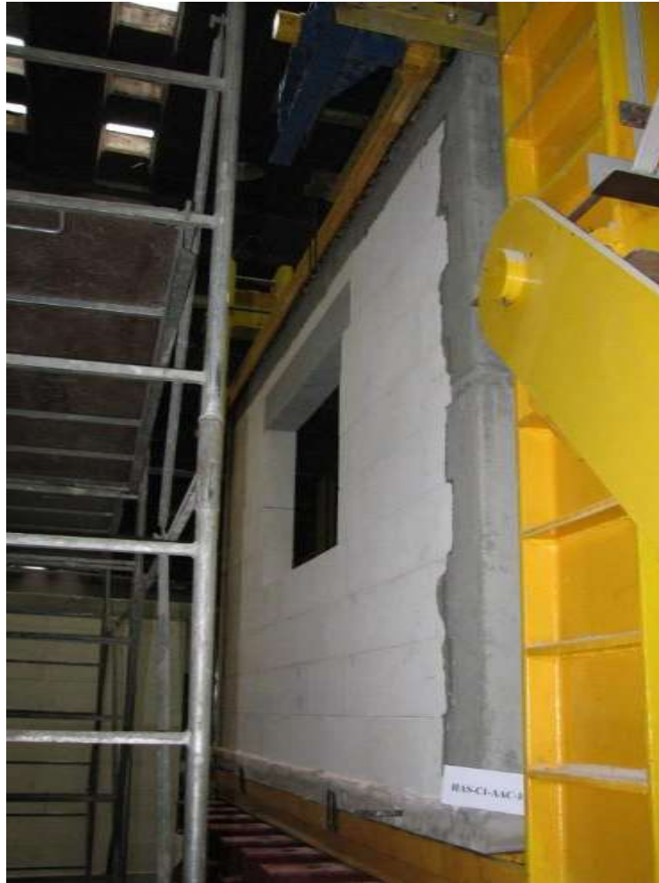
Rys. Z2.90. Widok modelu badawczego HAS-C1-AAC-010/1 w chwili zniszczenia od strony S-S
