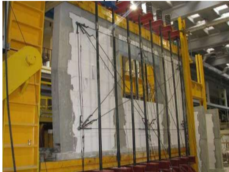
Rys. Z2.176. Poziome zarysowanie żelbetowego rdzenia w połowie wysokości od strony podpory B
