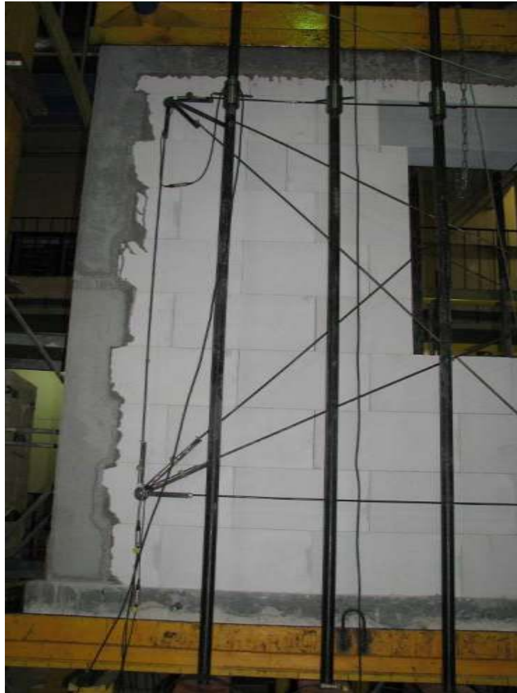
Rys. Z2.128. Wtórne zarysowania ściany w filarku nad podporą B
