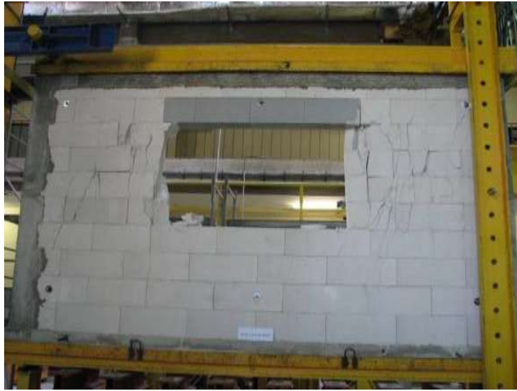
Rys. Z2.119. Widok modelu badawczego HAS-C1-AAC-075/1 w chwili zniszczenia od strony N-N
