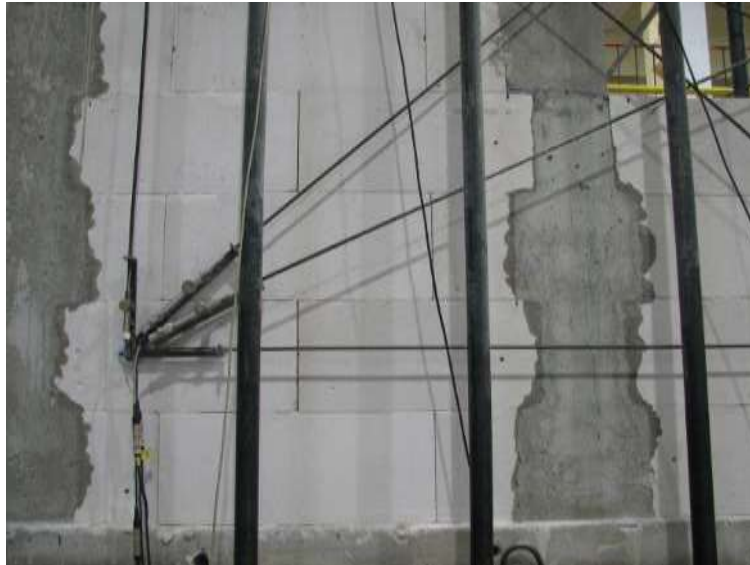
Rys. Z2.259. Pierwsze zarysowania ściany w dolnej części filarka od strony podpory B
