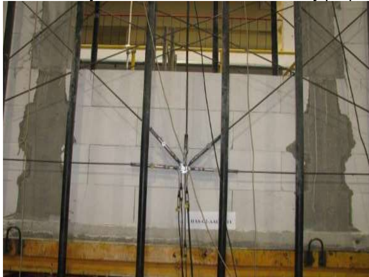
Rys. Z2.172. Wtórne zarysowania pasa podokiennego
