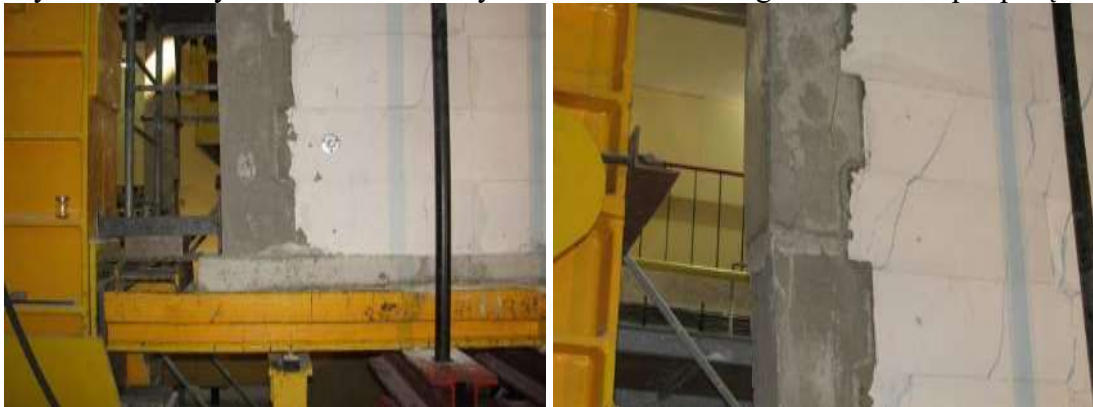
Rys.Z2. 45. Zarysowania dolnej i górnej części rdzenia od strony podpory B
