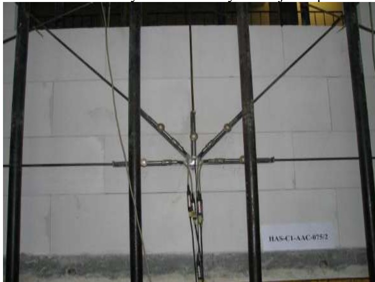
Rys. Z2.126. Pionowe zarysowania w pasie podokiennym
