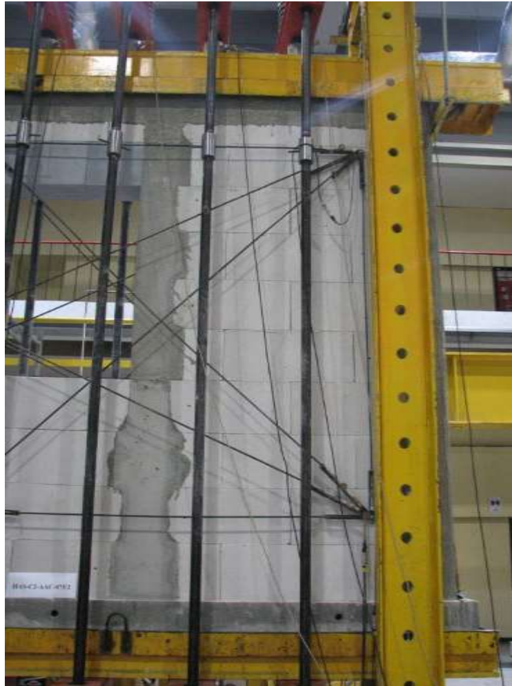
Rys. Z2.228. Wtórne zarysowania filarka od strony podpory A
