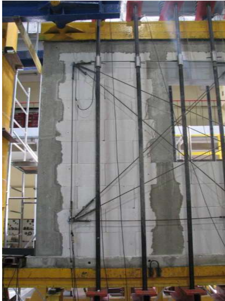
Rys. Z2.244. Wtórne zarysowania filarka od strony podpory B
