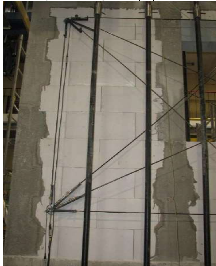
Rys. Z2.170. Wtórne zarysowania w górnej części filarka od strony podpory B
