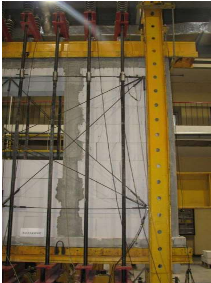
Rys. Z2.266. Zarysowania skrajnego filarka ściany od strony podpory A
