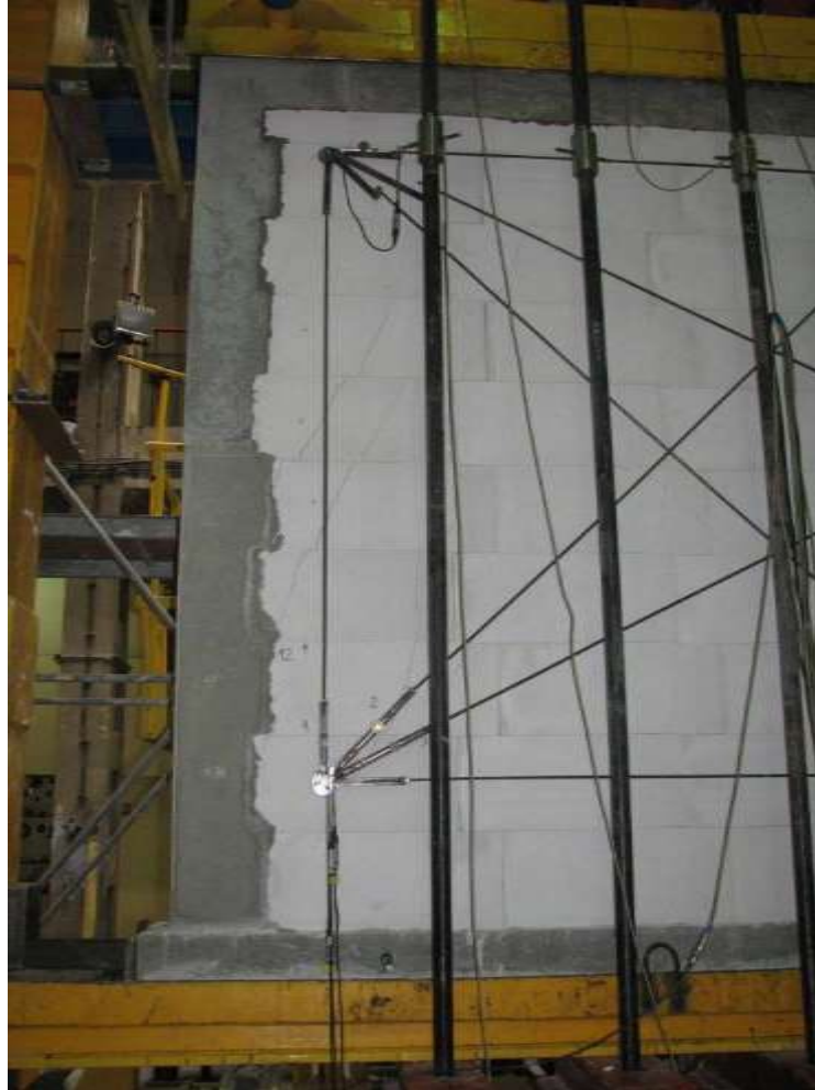
Rys. Z2. 56. Wtórne zarysowania ściany na styku muru i rdzeni
