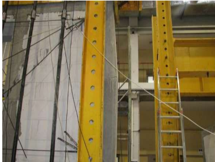
Rys. Z2.175. Poziome zarysowanie żelbetowego rdzenia w połowie wysokości od strony podpory A
