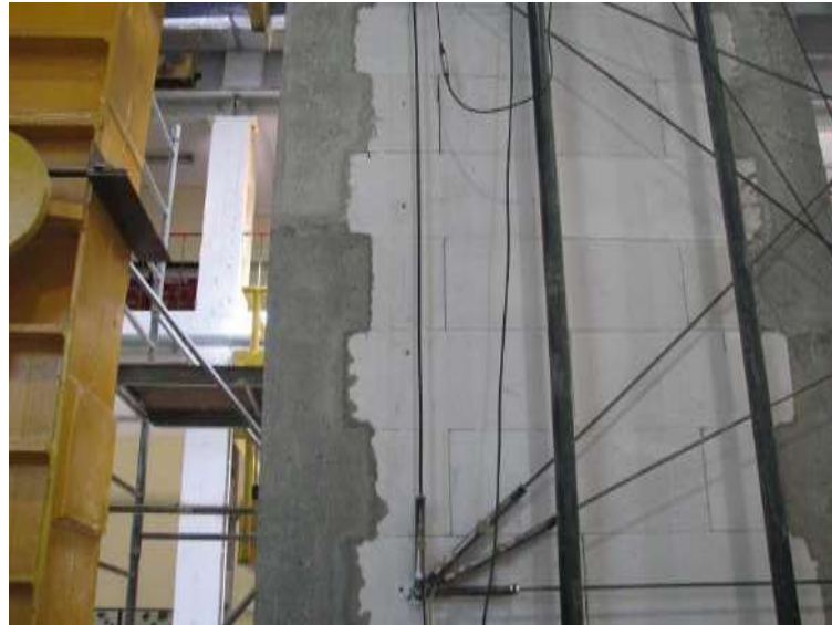
Rys. Z2.207. Pierwsze zarysowania ściany w dolnej części filarka od strony podpory B
