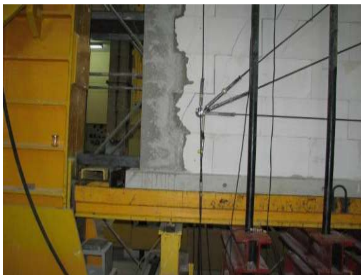
Rys. Z2.98. Wtórne zarysowania ściany w filarku nad podporą B
