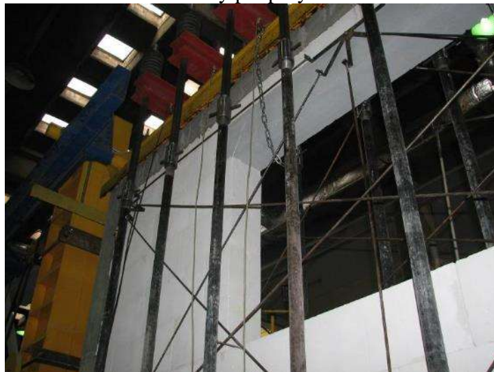
Rys. Z2.154. Pionowe zarysowania w miejscu oparcia nadproża od strony podpory B
