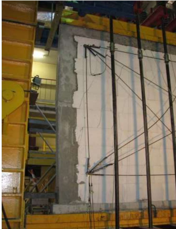
Rys.Z2. 44. Zarysowania muru na styku muru i żelbetowego rdzenia nad podporą B
