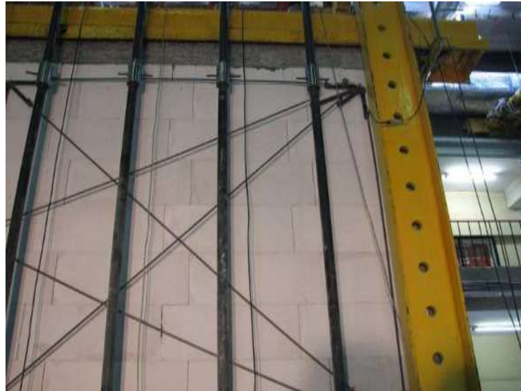
Rys.Z2. 41. Wtórne zarysowania ściany od strony podpory A Wzrost obciążenia spowodował powstanie pionowych i ukośnych zarysowań od strony podpory – rys. Z2. 42 na styku muru i betonu rdzeni.
