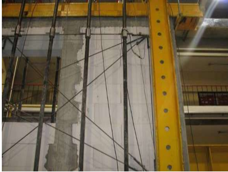
Rys. Z2.263. Wtórne zarysowania filarka od strony podpory A
