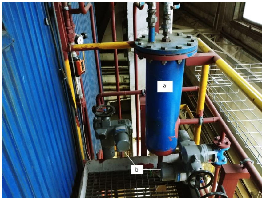
Rys. 5.11 (a) Mieszalnik reagenta i (b) zawory reagenta wraz z napędami elektrycznymi
