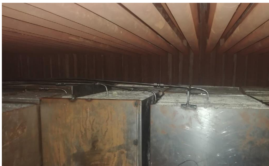
Rys. 5.21 Wkłady katalityczne z układem pomiarowym w kanale spalin
