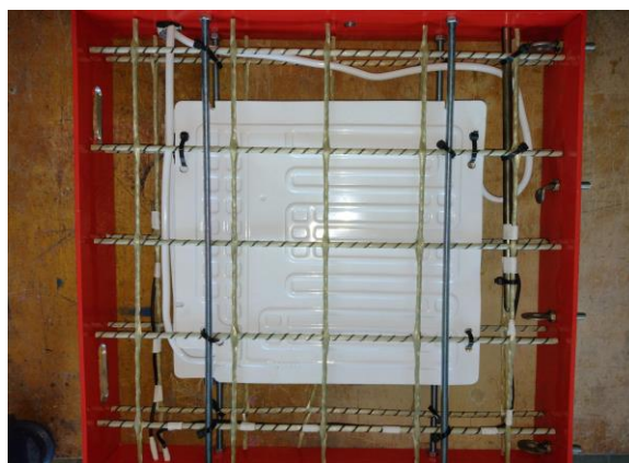
Rys. 5-17. Szalunek środkowej betonowej płyty z płytą chłodzącą
