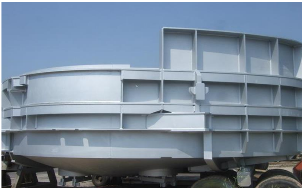
Rys. 2. Pancerz pieca w drodze do miejsca montażu [4]
