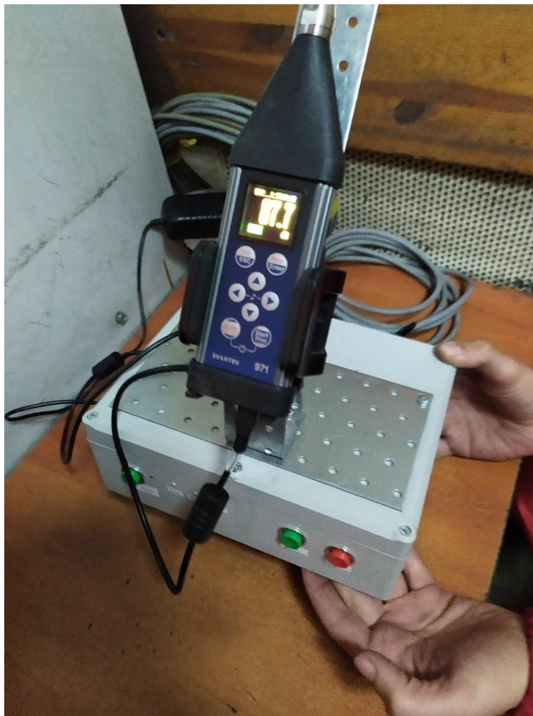
Rys. 41. Kontroler w sterowni elektrycznego pieca łukowego
