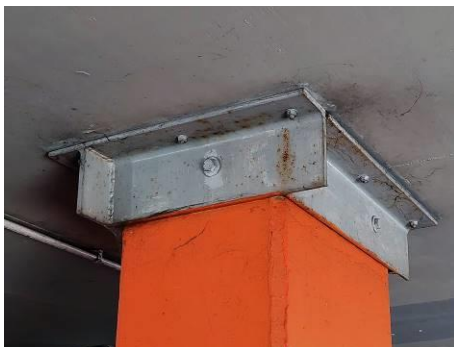
Rys. 9. Naprawy konstrukcji: a) zabezpieczenie dylatacji po rozcięciu płyty, b) wzmocnienie belek krawędziowych na ścinanie, c) wzmocnienie na przebiecie, d) naprawa belek krawędziowych i słupów matami z włókien węglowych
