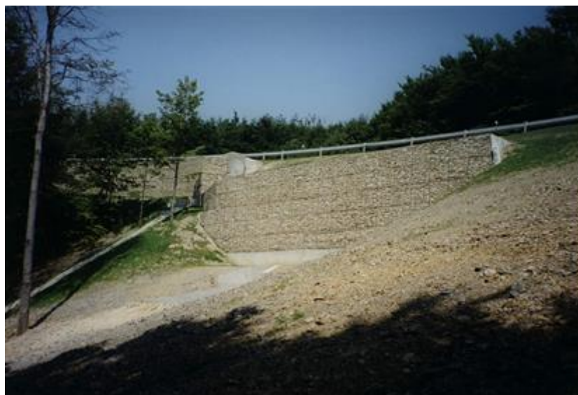
Rys. 8. Oblicowanie gabionowe Fig. 8. Gabion facing
