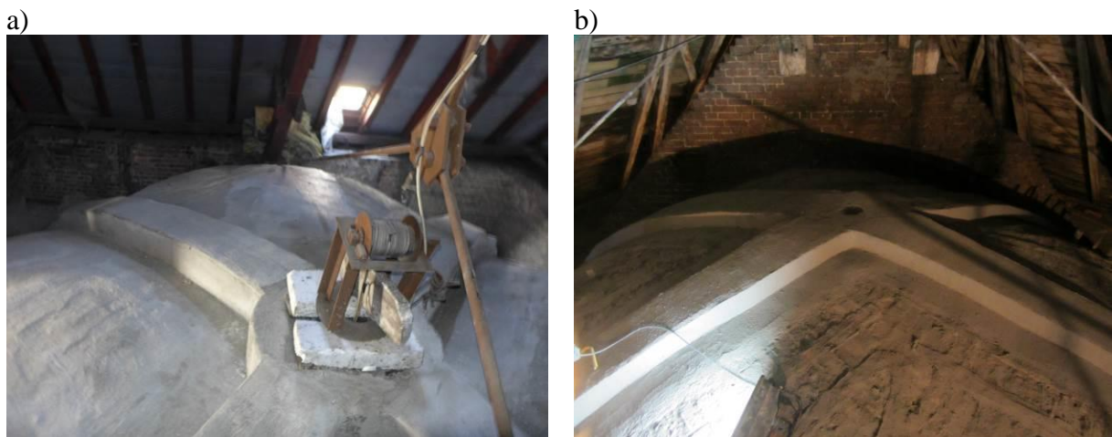
Rys. 6. Wykonywanie wzmocnień systemem FRCM sklepień: a) w kościele pw. Św. Wawrzyńca w Rudzie Śląskiej - Wirku, b) w kościele pw. Matki Ewy w Bytomiu - Miechowicach
