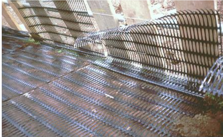
Rys. 9. Oblicowanie wywijane Fig. 9. Wraparound facing
