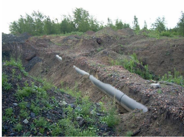
Rys. 1. Widok rurociągu tłocznego biegnącego przez składowisko
