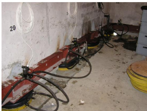
Rys. 8. Siłowniki membranowe
