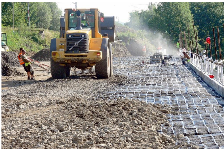
Rys. 15. Ostrokrawędziste kruszywo grubej frakcji w kontakcie z geosyntetykiem pod obciążeniem ruchem budowlanym
