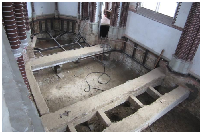
Rys. 8. Widok żelbetowych ściągów poprzecznych w kościele pw. Matki Ewy w Bytomiu - Miechowicach. Ściągi odkopano w celu wykonania widocznych na ścianach stalowych wzmocnień koniecznych do przeprowadzenia procesu prostowania budynku kościoła
