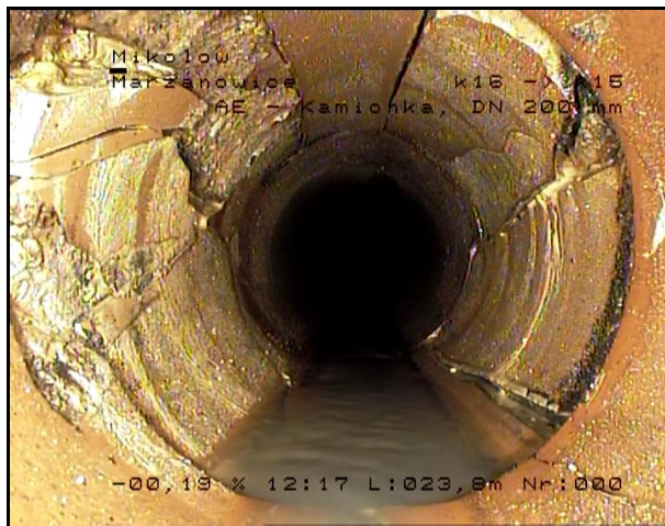
Rys. 4. Obwodowe i wzdłużne pęknięcia kamionkowej rury kanalizacyjnej Fig. 4. Circumferential and longitudinal cracks in a stoneware sewer pipe
