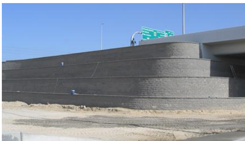
Rys. 12. Oblicowanie z drobnowymiarowych bloczków betonowych Fig. 12. Block facing
