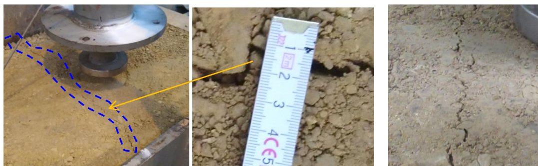
Rys. 12. Uszkodzenia w formie spękań warstwy mieszanki kruszywa po rozluźnienia w podłożu ( \epsilon=6 mm/m) [15]
