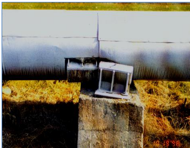
Rys. 10. Uszkodzenie płóz i płaszcza stalowego ciepłociągu Fig. 10. Damage to the skids and the steel cover of the heat pipeline
