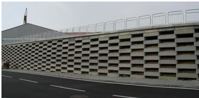
Rys. 11. Oblicowanie kaszycowe Fig. 11. Caission panel facing
