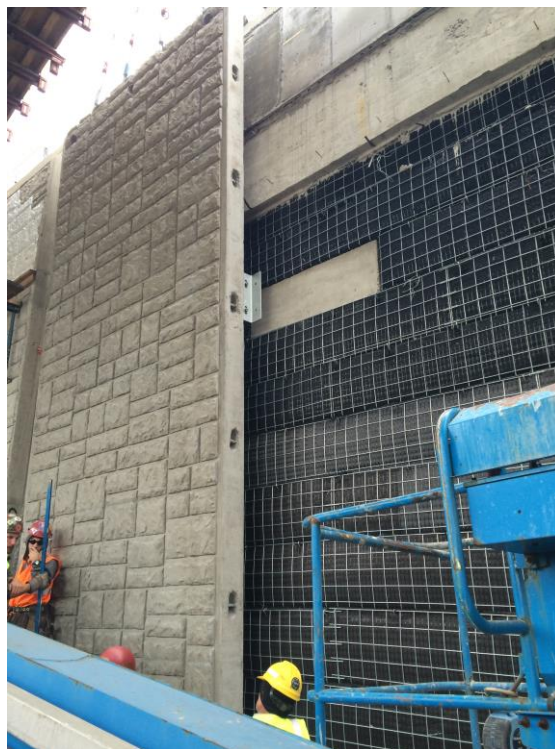
Rys. 13. Montaż oblicowania dodatkowego
