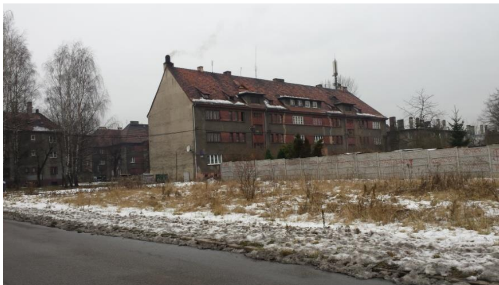
Rys. 1. Widok ogólny elewacji południowej analizowanego budynku
