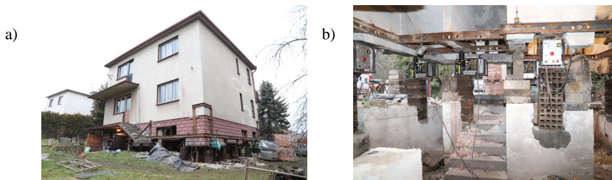
Rys. 10. Budynek podczas rektyfikacji: a) widok, b) siłowniki zabudowane w ścianach wewnętrznych Fig. 10. The building during rectification: a) view, b) jacks built into the internal walls
