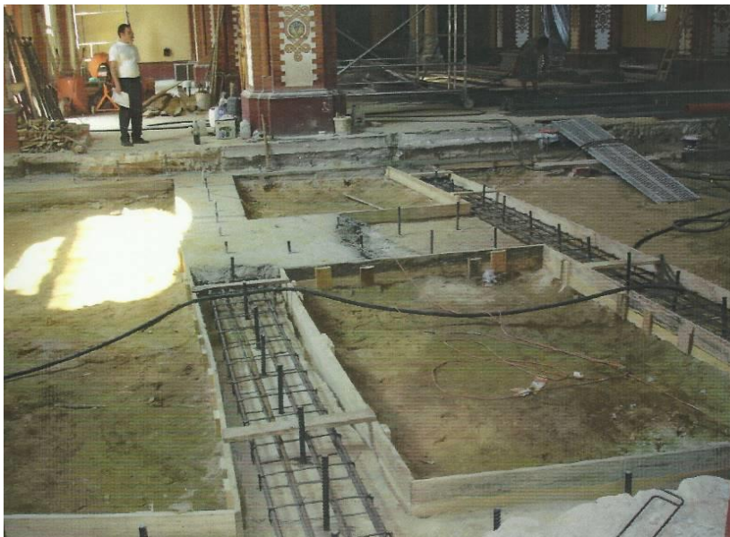
Rys. 9. Konstrukcja ukrytych ściągów pośrednich w kościele pw. Trójcy Przenajświętszej w Rudzie Śląskiej - Kochłowicach
