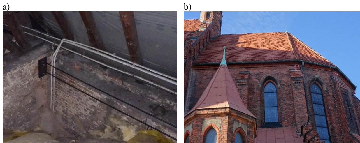
Rys. 4. Ściąg stosowane w kościele pw. Św. Wawrzyńca w Rudzie Śląskiej: a) ściąg wewnętrzne, b) ściąg zewnętrzne pod dachem wokół ścian prezbiterium
