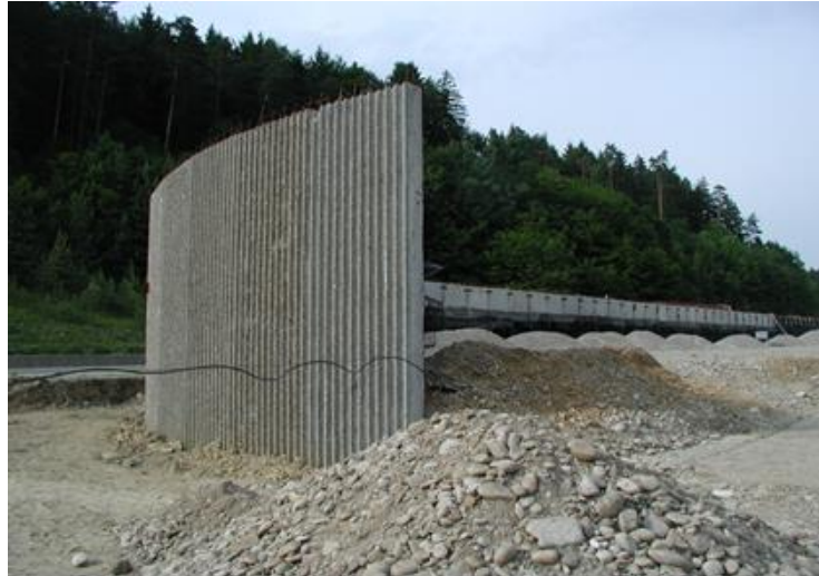
Rys. 6. Panele na pełną wysokość Fig. 6. Full heigh panels
