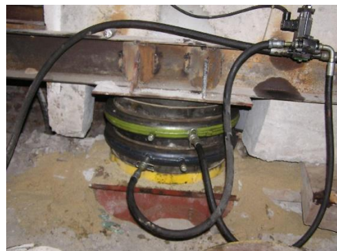
Rys. 7. Rektyfikacja budynku za pomocą siłowników membranowych
