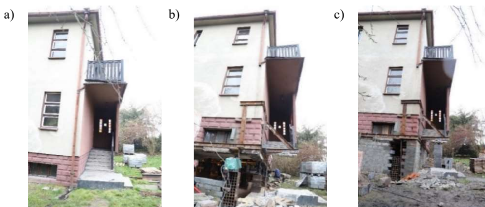
Rys. 2. Naroże budynku dwukondygnacyjnego: a) przed rektyfikacją, b) w trakcie rektyfikacji, c) po przeprowadzonej rektyfikacji z widocznym przemieszczeniem u_{obj} = 1312 mm
