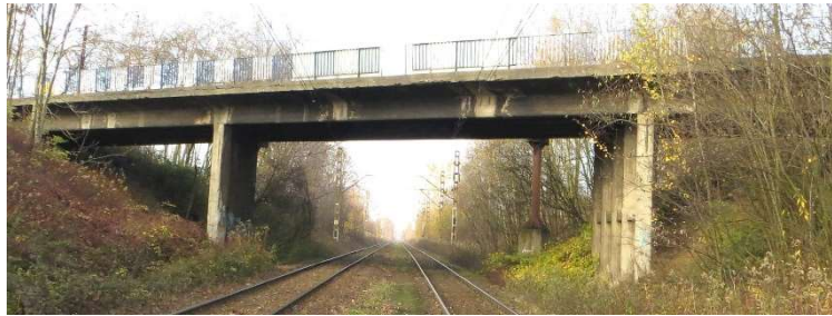
Rys. 1. Widok od strony południowej na wiadukt (rok 2013)
