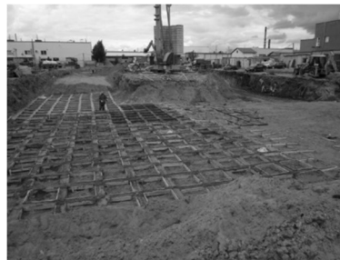
Rys.1. Wzmocnienie podłoża budynku przemysłowego: a) zaprojektowany rzut wykopu z elementami zbrojenia, b) proces wykonywania zbrojenia, c) widok prętów zbrojenia
