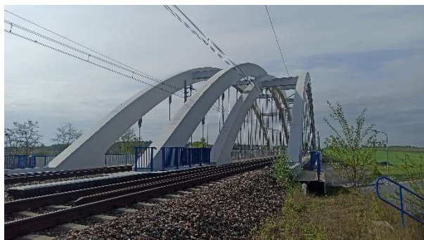
Rys. 1. Analizowany wiadukt łukowy z jazdą dołem zlokalizowany w ciągu polskiej linii kolejowej dużych prędkości
