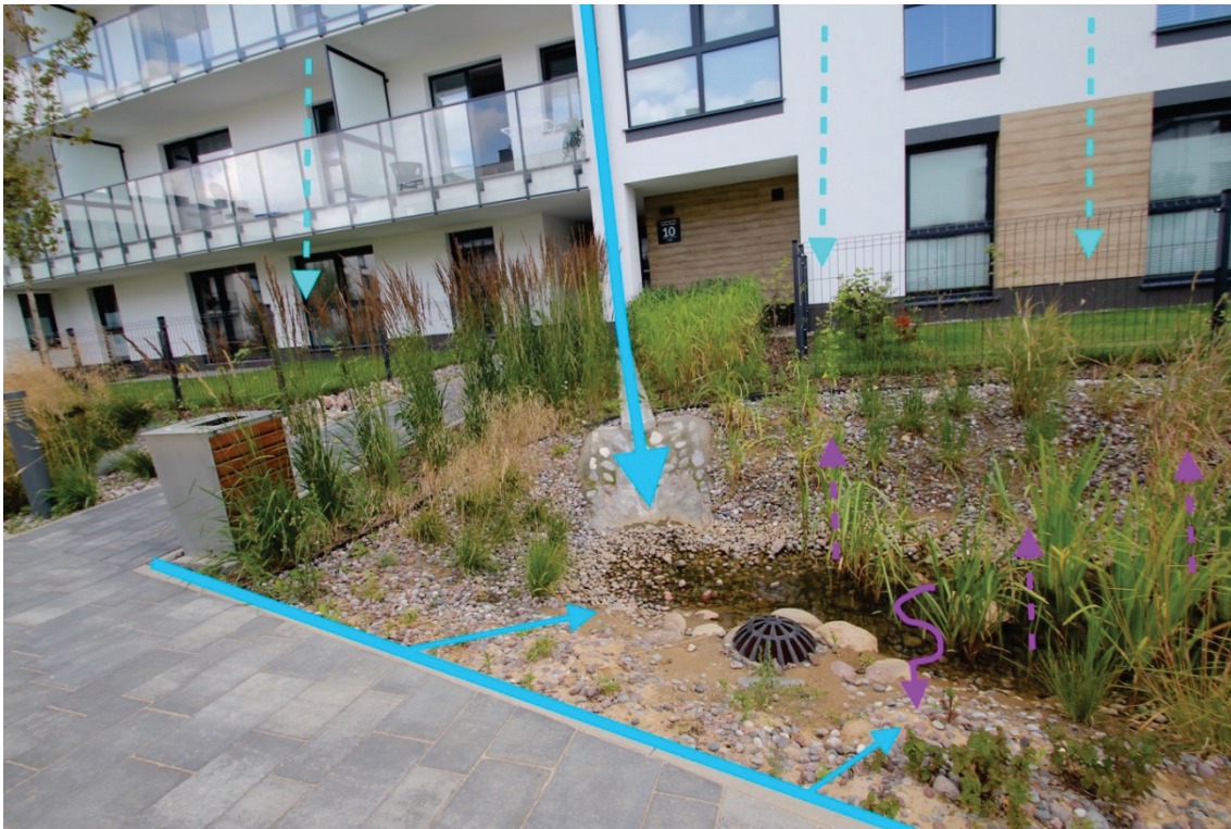
Fig. 6.8. Typical element of rainwater system at the Beaufort's housing estate – raingarden Rys. 6.8. Typowy element systemu gospodarowania wodą deszczową na osiedlu Beuforta – ogród deszczowy
