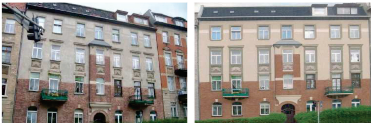
Fig. 5.2. Regeneration of a tenement in Jelenia Góra at Złotnicza 4, photo before and after and elevation improvement. Source: https://docplayer.pl/57963534-Renowacja-budynkow-przy-ul-zlotniczej-2-4-6-8-10-w-jeleniej-gorze.html [accessed: 08.05.2022]
