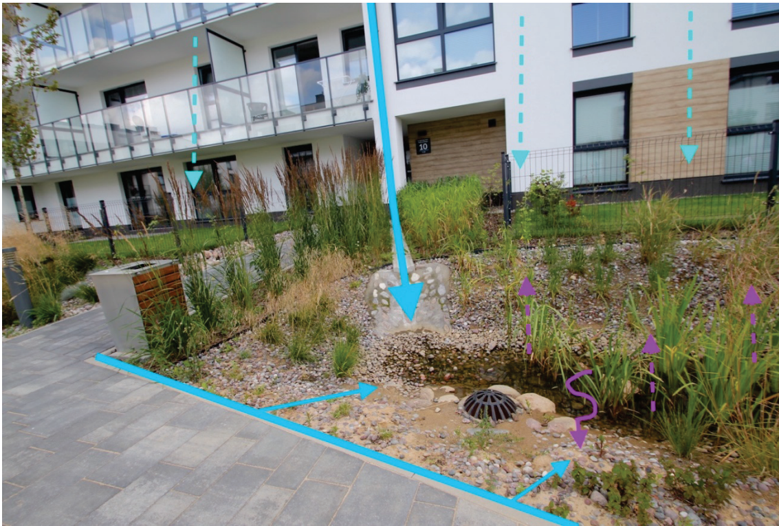
Fig. 6.8. Typical element of rainwater system at the Beaufort's housing estate – raingarden Rys. 6.8. Typowy element systemu gospodarowania wodą deszczową na osiedlu Beuforta – ogród deszczowy
