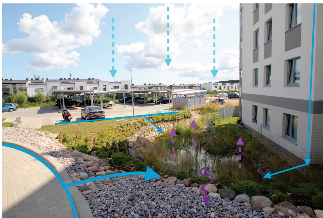
Fig. 6.4. Typical element of rainwater system at the Green Meridian housing estate – raingarden Rys. 6.4. Typowy element system gospodarowania wodą deszczową na osiedlu Zielony Południk – ogród deszczowy
