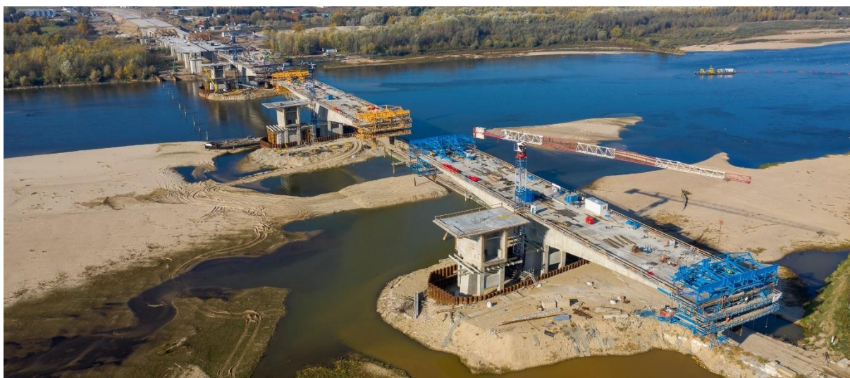
Rysunek 1. Budowa mostu przez Wisłę w ciągu drogi ekspresowej S2 o rozpiętości przęsła 176 m [203]
