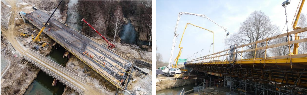
Rysunek 46. Obiekt MD-1 w trakcie budowy [202]
