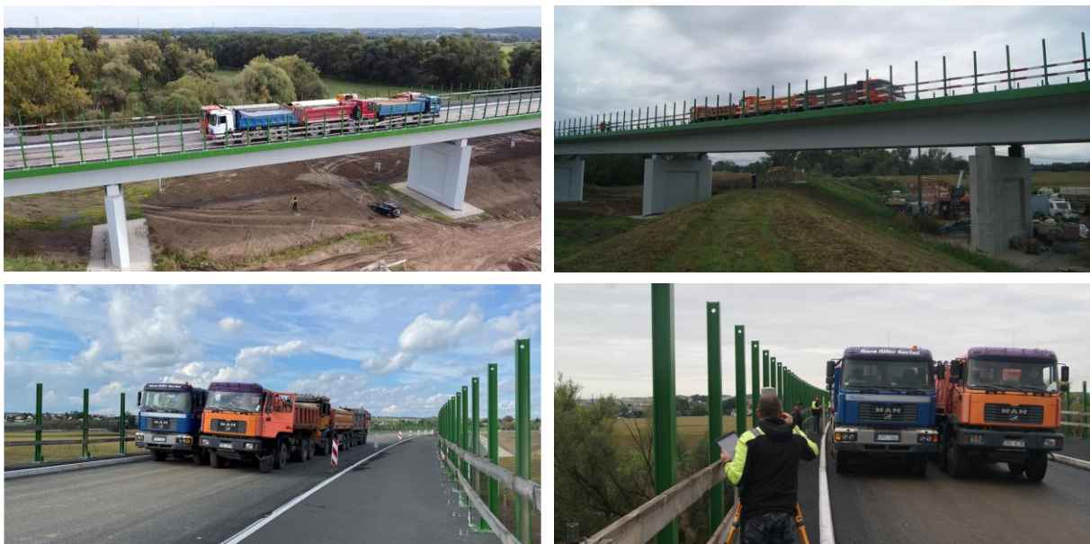
Rysunek 90. Próbné obciążenie obiektu MG-1
