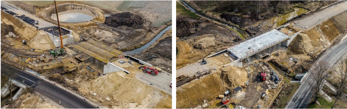
Rysunek 50. Obiekt MD-18 w trakcie budowy [202]
