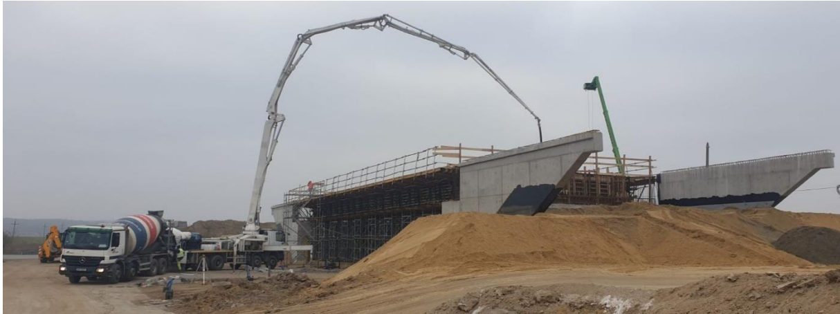
Rysunek 42. Obiekt WG-4 w trakcie budowy
