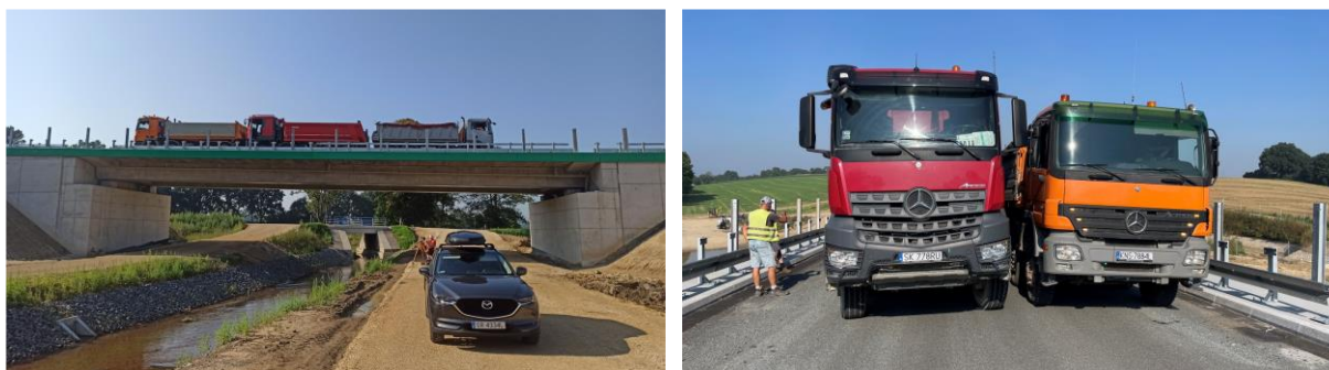
Rysunek 94. Próbné obciążenie obiektu MD-18
