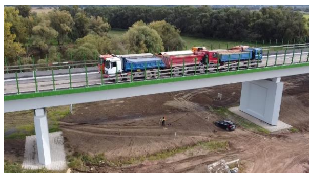
Rysunek 87. Pojazdy obciążające po wjeździe na badane objekty
