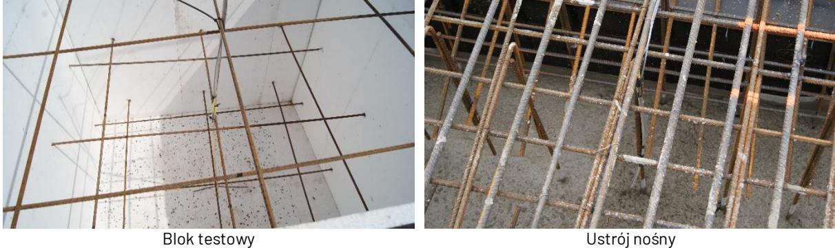
Rysunek 73. Lokalizacja czujników temperatury w betonowanym elemencie
