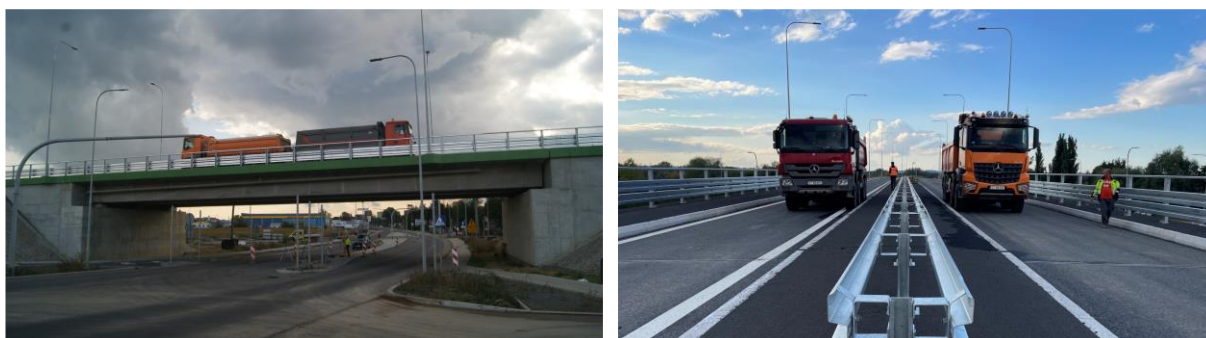
Rysunek 92. Drugie próbnego obciążenie obiektu WG-4
