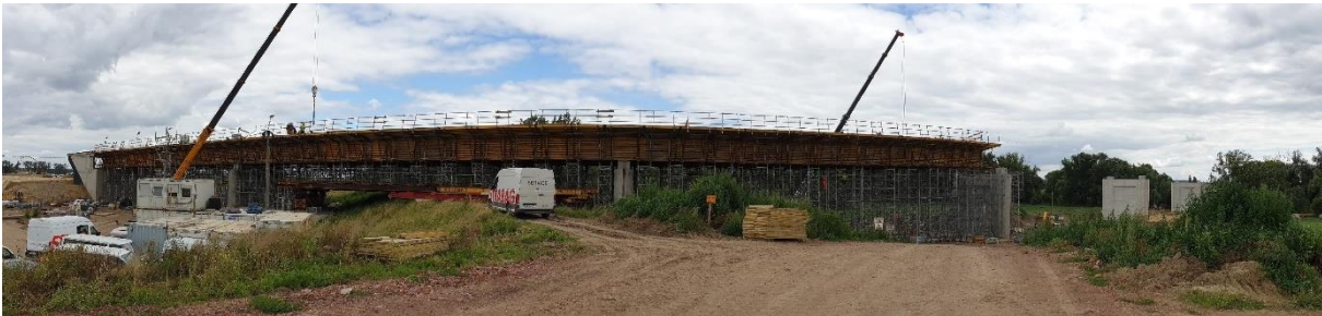
Rysunek 38. Obiekt MG-1 w trakcie budowy
