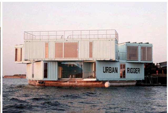
Ilustracja 21. Z prawej strony: Urban rigger, jednostki mieszkalne umieszczone na nabrzeżu wykonane z kontenerów morskich, proj. Bjarke Ingels Group.
