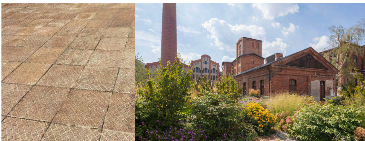
Ilustracja 90. Z lewej strony: Inwestycja Fuzja Łódź, 2021, posadzka na zagospodarowaniu terenu wykonana z odzyskanych płyt żeliwnych. Źródło: Materiały Medusa Group
