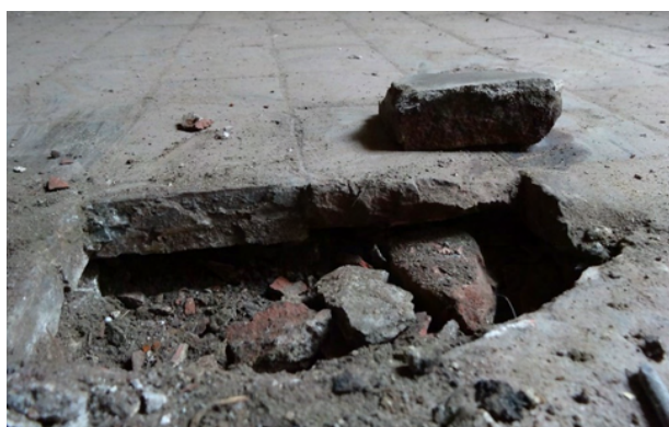
Ilustracja 85. Z lewej strony: Inwestycja Fuzja Łódź, 2021, odkrywka historycznej posadzki z cegły klinkierowej w budynku E2. Źródło: Materiały Medusa Group, zdjęcie Sandra Przepiórkowska
