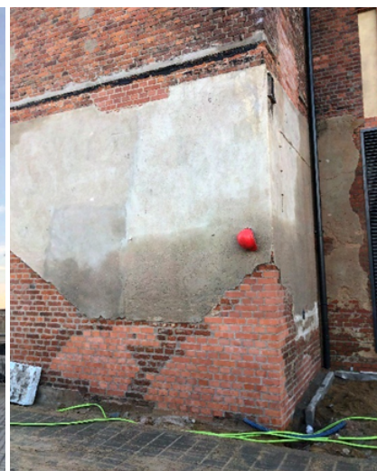
Ilustracja 89. Z prawej strony: Inwestycja Fuzja Łódź, 2021, Inwestycja Fuzja Łódź, 2021, ściana historyczna uzupełniona cegłą z odzysku, zachowanie historycznych tynków. Źródło: Materiały Medusa Group, zdjęcie Sandra Przepiórkowska
