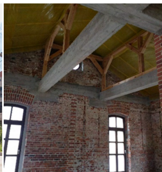
Ilustracja 83. Wnętrze budynku E03, widoczne naprawy muru ceglanego i nowa więźba dachowa wraz z wzmocnieniami belkami żelbetowymi Źródło: Materiały Medusa Group
