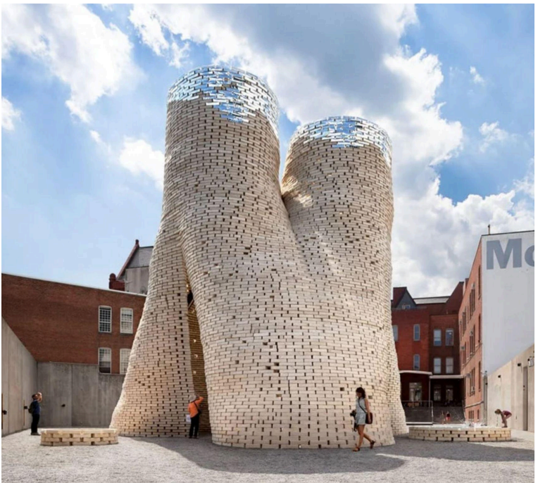
Ilustracja 125. Z prawej strony: Pawilon "Hy-Fi" z cegieł z mycelium w galerii MOMA Ps2 w Nowym Jorku (wystawa czasowa). Projekt: The Living. Źródło: www.moma.org/collection/works/188561 , materiały the Living
