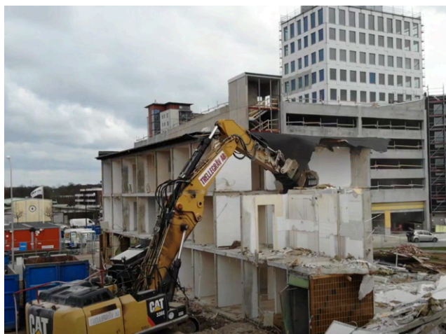
Ilustracja 26. Wspierany przez fundusze UE program ReCreate ma na celu odzysk prefabrykowanych elementów konstrukcyjnych. Na zdjęciu proces rozbiórki Źródło: https://www.youtube.com/watch?v=OREdk6I1eqw
