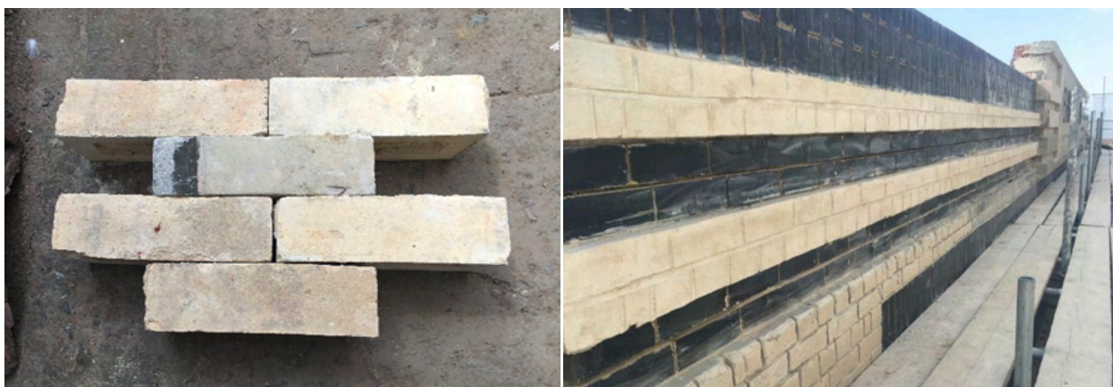
Ilustracja 51. Z lewej strony: Empire House w Londynie, 2020, cegła odzyskana z tylnej elewacji podczas remontu budynku. Źródło: Materiały Medusa Group
