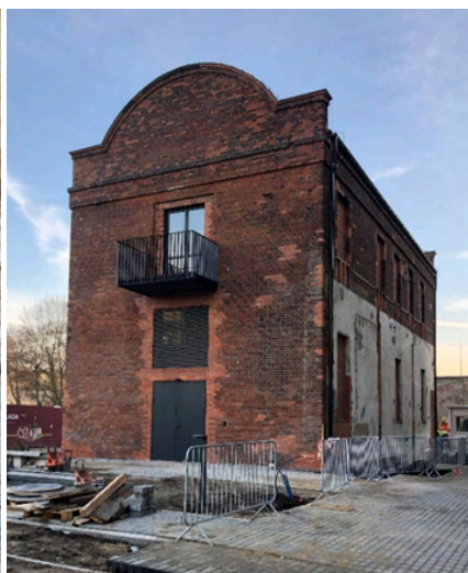
Ilustracja 88. Z prawej strony: Inwestycja Fuzja Łódź, 2021, budynek E05; widoczne ceglane uzupełnienia na elewacji. Źródło: Materiały Medusa Group, zdjęcie Sandra Przepiórkowska
