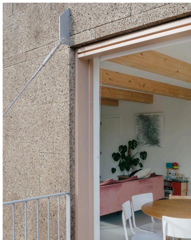
Ilustracja 128. Zbliżenie na korkową elewację budynku. Projekt: Officeu Architects. Źródło: https://www.dezeen.com/2022/10/01/officeu-cork-clad-de-sijs-co-housing-belgium/
