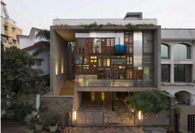
Ilustracja 59: Elewacja zewnętrzna wykonana z recyklowanych drzwi i okien.
