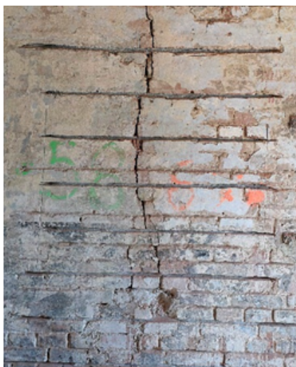
Ilustracja 87. Z lewej strony: Inwestycja Fuzja Łódź, 2021, naprawa (zszywanie) ścian ceglanych w celu uniknięcia wymiany ściany konstrukcyjnej. Źródło: Materiały Medusa Group, zdjęcie Sandra Przepiórkowska
