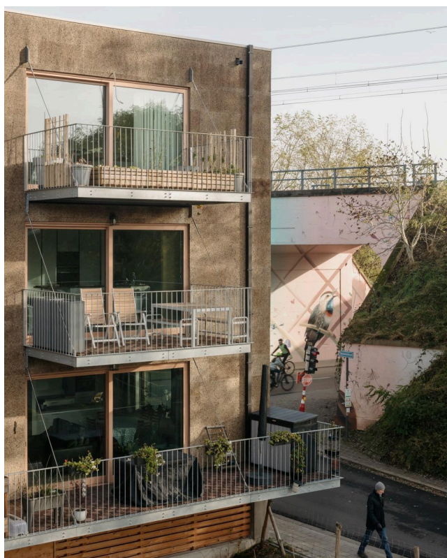
Ilustracja 127. Budynek z elewacją pokrytą korkiem w Leuven w Belgii. Projekt: Officeu Architects. Źródło: https://www.dezeen.com/2022/10/01/officeu-cork-clad-de-sijs-co-housing-belgium/
