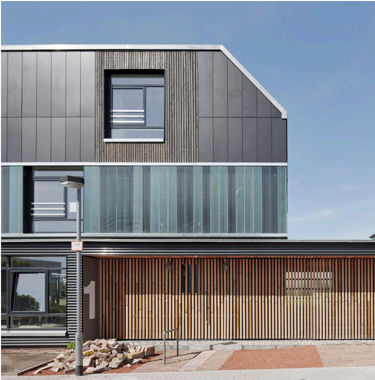
Ilustracja 74. Z lewej strony: elewacja frontowa. Zastosowano materiały stanowiące końcówki serii np. dyle szklane z poprzednich inwestycji. Źródło: Materiały Cityförster
