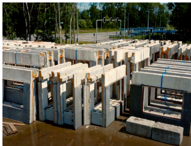
Ilustracja 27. Przygotowane do ponownego użycia prefabrykaty odzyskane w wyniku selektywnej rozbiórki prowadzonej przez program ReCreate. Źródło: https://www.youtube.com/watch?v=OREdk6I1eqw
