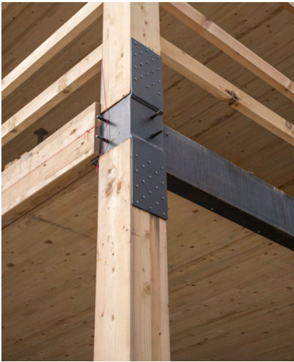
Ilustracja 106, 107. Detal połączenia słupa wykonanego z drewna klejonego z prefabrykowanym stropem drewnianym
