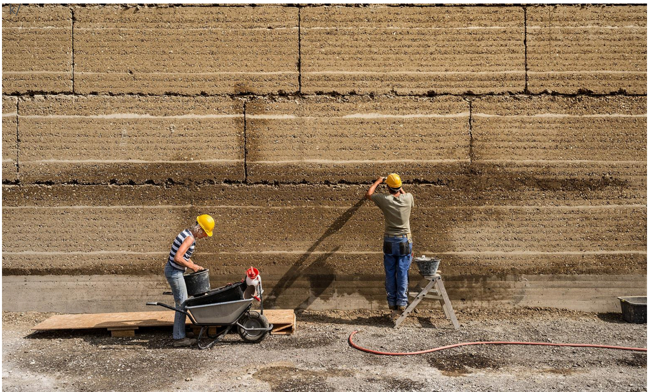
Ilustracja 126. Montaż i obróbka ścian w technice ziemi ubijanej, Ricola Kraeuterzentrum. Proj: Herzog & de Meuron. Źródło: www.moma.org/collection/works/188561
