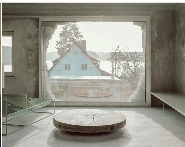
Ilustracja 118. Z prawej strony:.. Dom urządzony w dawnej fabryce bielizny. Antivilla pod Poczdammem w Niemczech autorstwa Arno Brandhuber'a jest budynkiem-manifestem. Na zewnątrz domu wygląda się przez otwory okienne wykute w elewacji budynku pozostawione bez dodatkowego wykończenia. W celu uwypuklenia "ruin" (nazywanych tak przez autora) i uniknięcia konieczności obróbki otworu, stolarka okienna jest osadzona w innej płaszczyźnie - wysunięta przed lico muru po stronie wewnętrznej ściany. Źródło: Materiały Brandhuber
