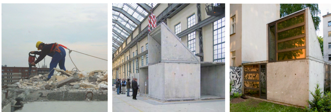
Ilustracja 31-33. Eksperymentalny budynek Plattenpalast, wzniesiony z recyklowanych konstrukcyjnych elementów prefabrykowanych.
