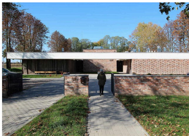
Ilustracja 56. Wejście główne do budynku.
