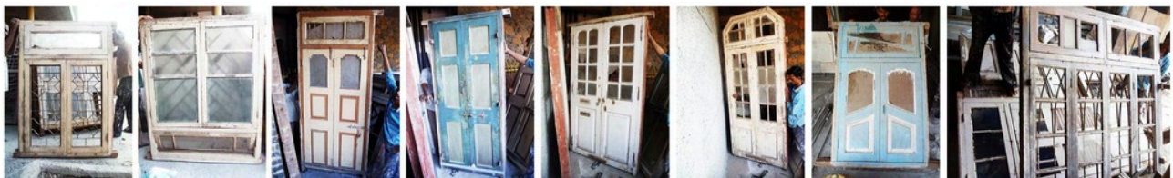
Ilustracja 61: Inwentaryzacja drzwi i okien odzyskanych z rozbiórek okolicznych domów. Każda para drzwi i okno zostały poddane renowacji oraz odpowiednio zabezpieczone przed wbudowaniem w elewację.
