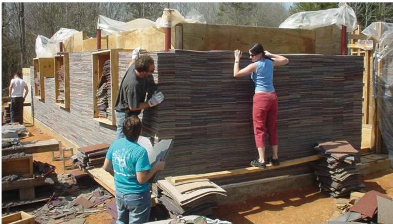
Ilustracja 65: Budowa ścian z kafelek dywanowych.
