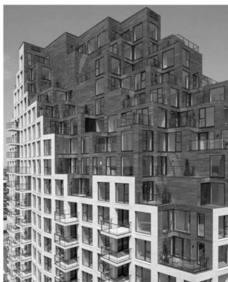
Ryc. 2.47. Budynek mieszkalny wielorodzinny, Haga, Holandia, projektant: MVRDV, źródło: www.mvrdv.nl , dostęp: 09.09.2022 r.
