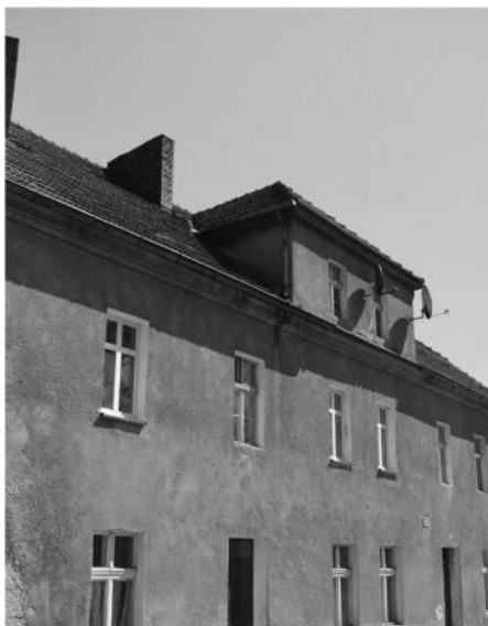
Ryc. 2.23. Budynek mieszkalny wielorodzinny, Chrzelice, Polska, projektant: Agata Gąsowska-Kramarz, źródło: opracowanie własne.
