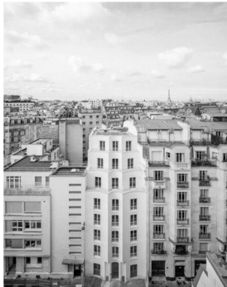
Ryc. 2.50. Budynek mieszkalny wielorodzinny, Paryż, Francja, projektant: Jean-Christophe Quinton architecte, źródło: www.archdaily.com , dostęp: 9.09.2022 r.
