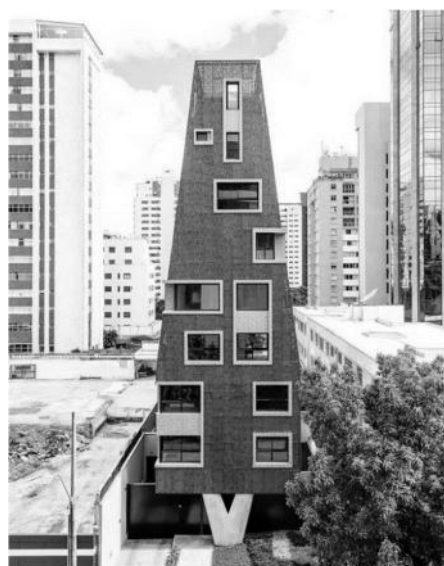
Ryc. 2.59. Budynek mieszkalny wielorodzinny, Belo Horizonte, Brazylia, projektant: Gisele Borges Arquitetura, źródło: www.archdaily.com , dostęp: 9.09.2022 r.
