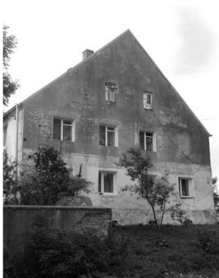
Ryc. 2.35. Budynek mieszkalny wielorodzinnny, Starczów, Polska, projektant: Agata Gąsowska-Kramarz, źródło: opracowanie własne.
