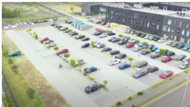
Rys. 11.4 Parking przed siedzibą firmy Blees
