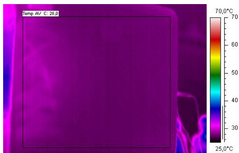
Rys.6.20. Temperatura prawej ściany – po 120 minutach.
