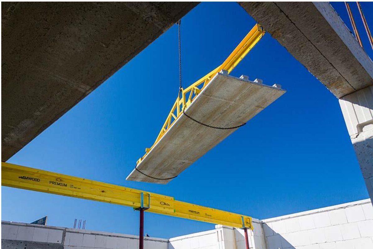
Rys. 32. Montaż płyty stropu Konbet S-Panel za pomocą żurawia samojezdnego Fig. 32. Installation of Konbet S-Panel slab using a self-propelled crane
