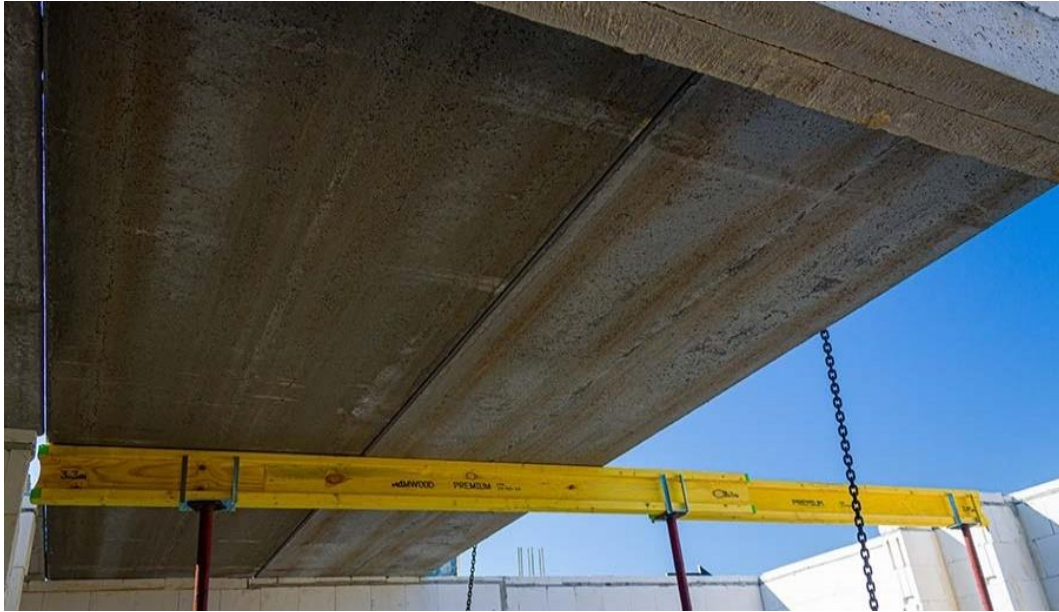
Rys. 36. Podparcie montażowe stropu Konbet S-Panel Fig. 36. Konbet S-Panel ceiling mounting support
