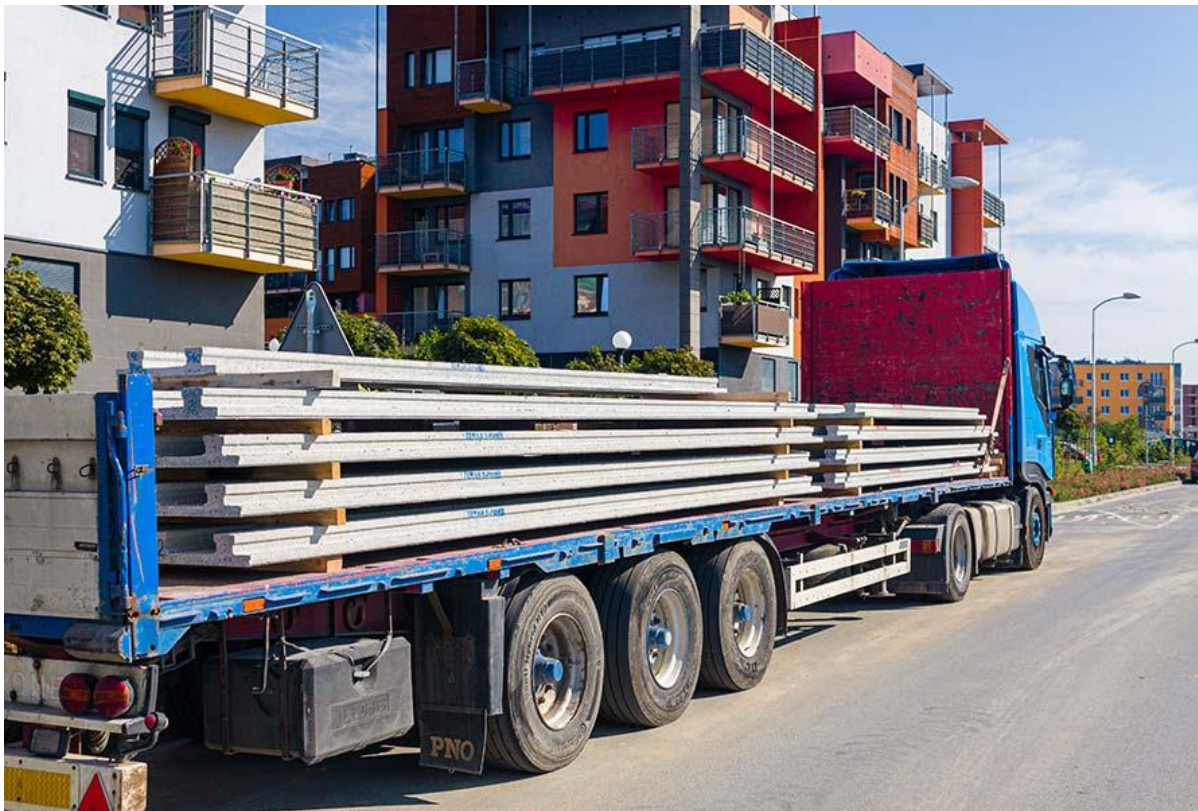
Rys. 28. Prefabrykaty stropu Konbet S-Panel na naczepie Fig. 28. Precast Konbet S-Panel slabs on the trailer
