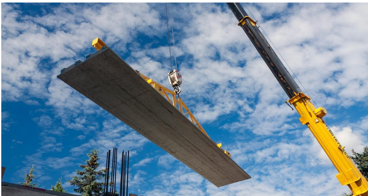
Rys. 29. Podnoszenie płyty Konbet S-Panel dedykowanym trawersem Fig. 29. Lifting of Konbet S-Panel slab with dedicated traverse
