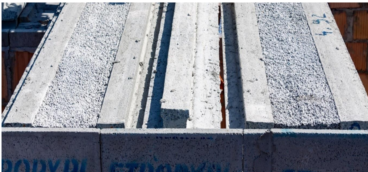
Rys. 25. Płyta uzupełniająca stropu Teriva Panel o szerokości 30 cm Fig. 25. Supplementary plate width of 30 cm for the Teriva Panel ceiling
