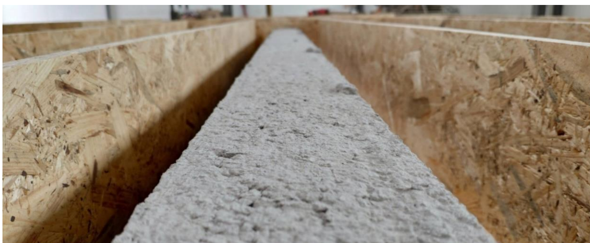
Rys. 8. Powierzchnia żebra stropu Teriva Panel Fig. 8. Surface of Teriva Panel rib
