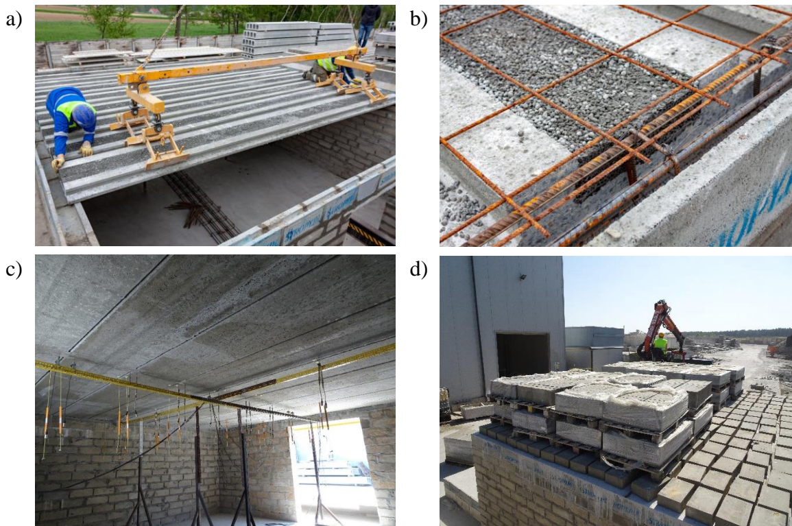
Rys. 57. Model badawczy: a) układanie paneli stropowych, b) zbrojenie nadpodporowe, c) czujniki indukcyjne i znaczniki geodezyjne, d) obciążenie pozostawione na czas badań długotrwałych Fig. 57. Research model: a) panel laying, b) support reinforcement, c) inductive and geodetic sensors, d) long-term load
