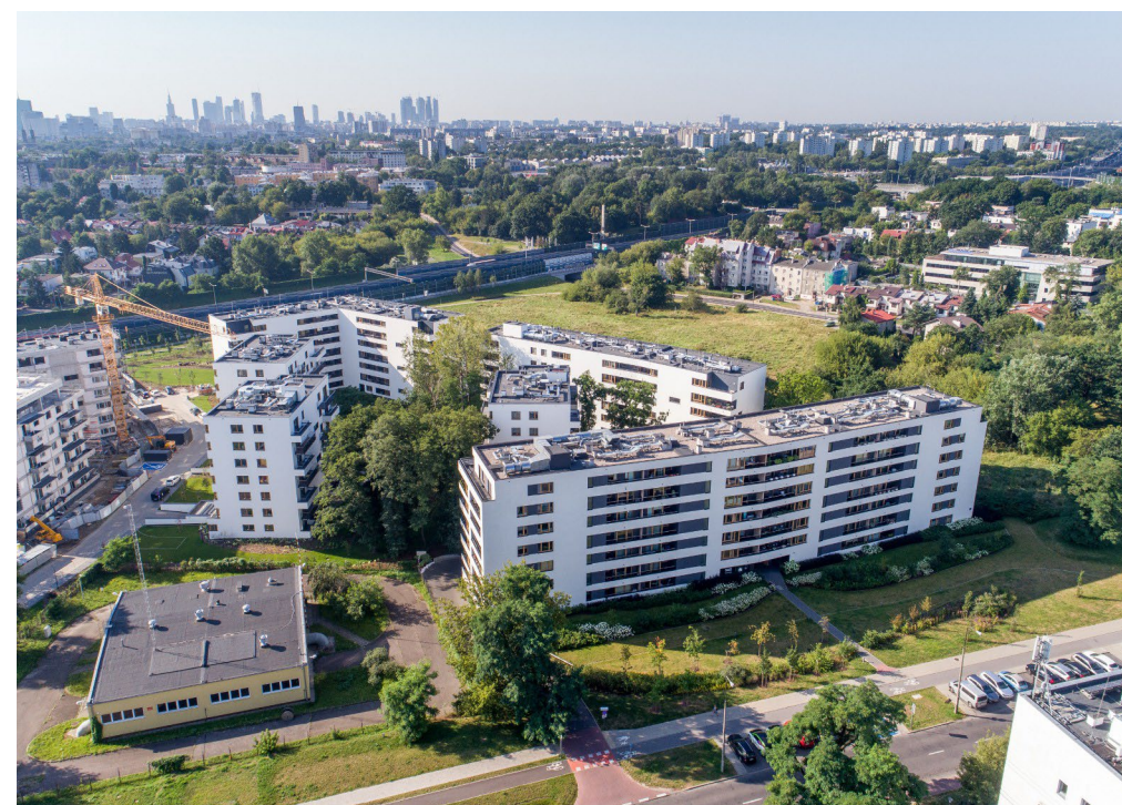
Il.70. Osiedle Mickiewicza w Warszawie, projekt HRA Architekci/The Mickiewicz estate in Warsaw, project HRA Architekci, autor zdjęć/author of the photos: Piotr Krajewski
