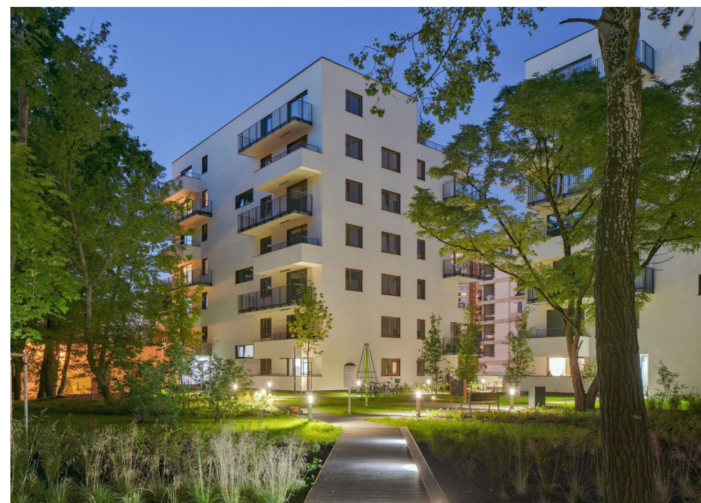
Il.68. Osiedle Mickiewicza w Warszawie, projekt HRA Architekci/The Mickiewicz estate in Warsaw, project HRA Architekci, autor zdjęć/author of the photos: Piotr Krajewski
