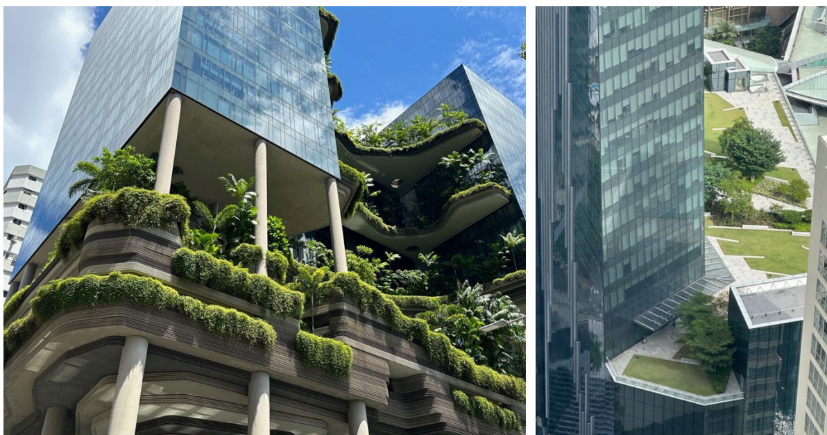
Rys. 36.2. Budynek hotelu, Singapur (po lewej) i budynek biurowy w Kuala Lumpur, Malezja (po prawej)
