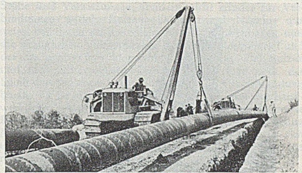
Abb. 8. Verlegung von Rohren in Gräben durch Raupenschlepper der Allis-Chalmers Co. mit seitlich angebrachten Kranauslegern.
