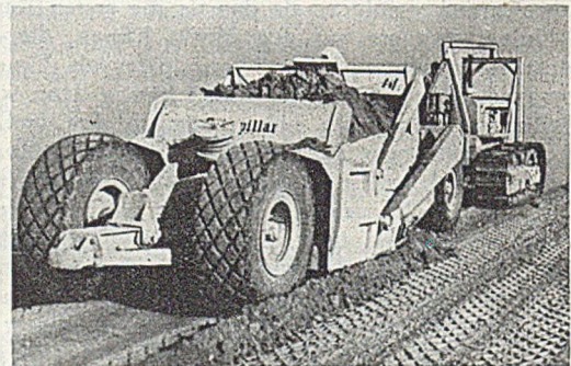
Abb. 1. Raupenschlepper mit angehängtem Schürfkübelwagen (Inhalt bis 14 m 3 ) bei Straßenbauarbeiten (Fabrikat: Caterpillar Tractor Co.).
