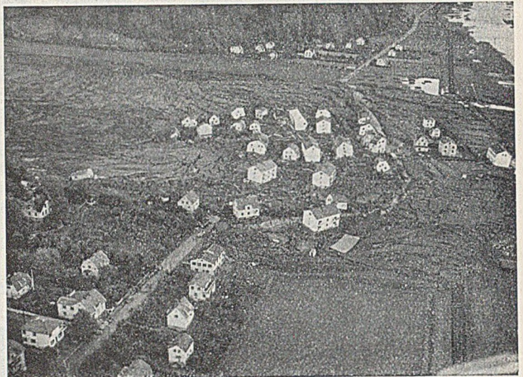
Abb. 1. Katastrophe in Surte, Westschweden. Flugbild des Rutschgebietes, rechts der Göta-Älv. In der Mitte die unterbrochene und verschobene Landstraße, an der u. a. das mitten auseinandergebrochene Haus steht. Rechts der unterbrochene Eisenbahndamm, das Bahnhofsgebäude Surte-Södra ist nach rechts aus dem Bildfeld hinausgeschoben. Links die neu entstandene Ton- und Lehmwüste.
