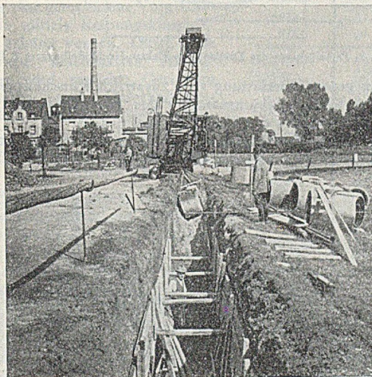
Abb. 4. Universalbagger B 206 beim Ausheben eines Grabens, als Schlepplöffelbagger arbeitend
