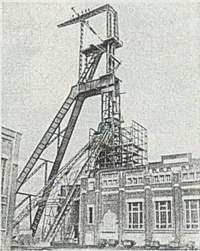
Abb. 10. Das Fördergerüst für den Schacht Marie-José vor Entfernen des alten Gerüsts.
