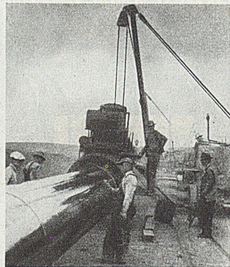
Abb. 2. Reinigen und Bituminieren der Rohre.
