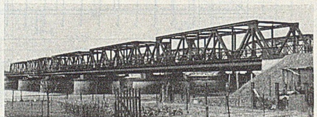
Abb. 10. Wiederhergestellte danebenliegende Eisenbahnbrücke.
