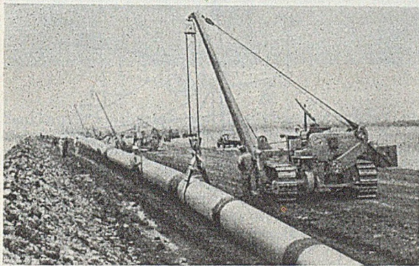
Abb. 4. Große Rohrlänge fertig zum Verlegen.
