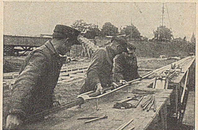
Abb. 15 b. Einführen der Drahtbündel in die Metallfolie.
