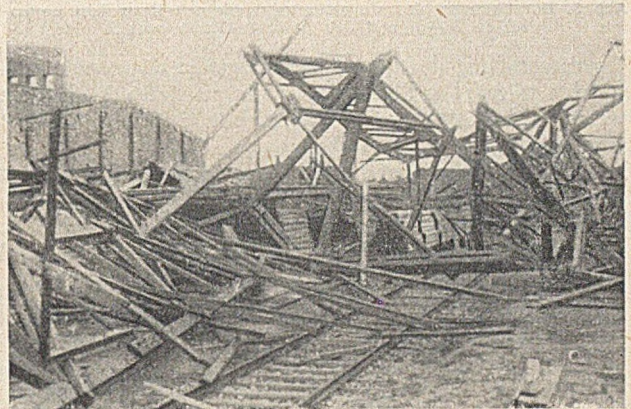
Abb. 2. Die Trümmer der vollkommen eingestürzten Holzhalle.
