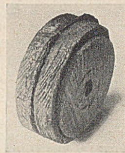
Abb. 4. Holzkörper im Sparren nach Herstellung der Ausfäassung.
