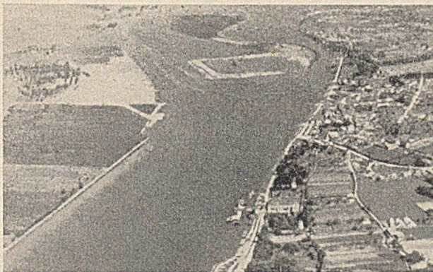
Abb. 3. Luftbild der Sperrstelle nach Verlegung des Fahrwassers und Herstellung des Oberstrom-Dammes, kurz vor Schließung der letzten Lücke im Unterstrom-Damm.
